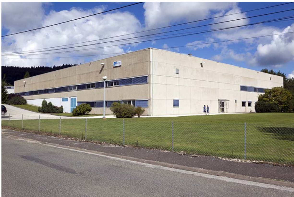
Vue d'ensemble, depuis le sud.
