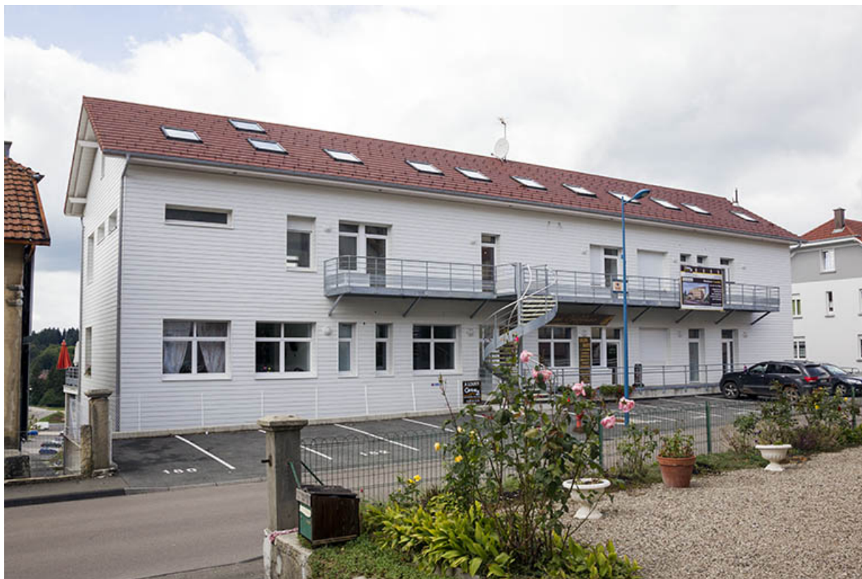
Bâtiments du 3e quart du 20e siècle : façade antérieure, de trois quarts gauche (sud-est). 25, Maîche, 19, 21, 26 rue de Saint-Hippolyte
