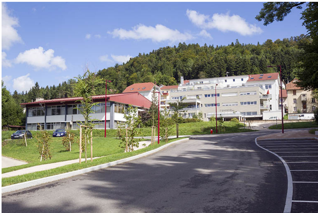
Une grosse entreprise : l'usine d'ébauches de montre Joseph Jeambrun (1900) puis France Ebauches, aux 19, 21 et 26 rue de Saint-Hippolyte. Usine aux n° 19 et 21 (1957-1958, 1971) à l'arrière-plan à droite, usine Robert Jeambrun (1961-1962) à gauche. 25, Maîche
