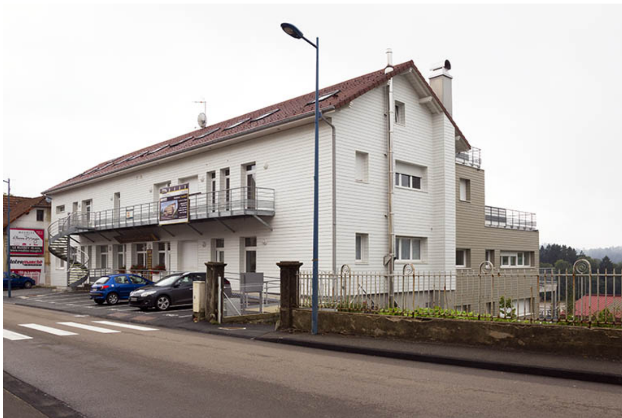
Usine n° 2 (Ets Joseph Jeambrun), au 19 rue de Saint-Hippolyte à Maïche. 25, Maïche, 19, 21, 26 rue de Saint-Hippolyte
