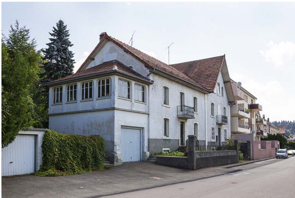
Usine n° 1 (Ets Joseph Jeambrun), au 26 rue de Saint-Hippolyte à Maîche. 25, Maîche
