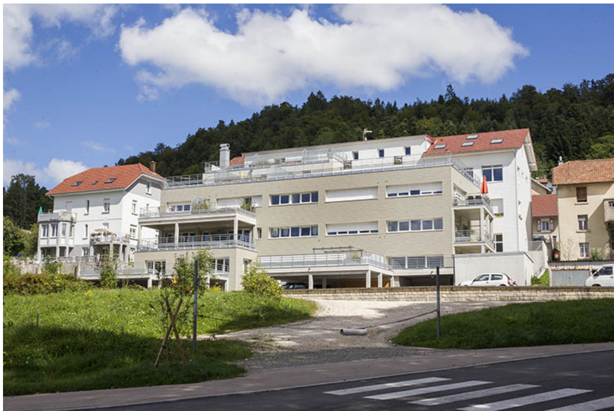
Bâtiments du 3e quart du 20e siècle : façade postérieure, de trois quarts droite (sud-ouest).
