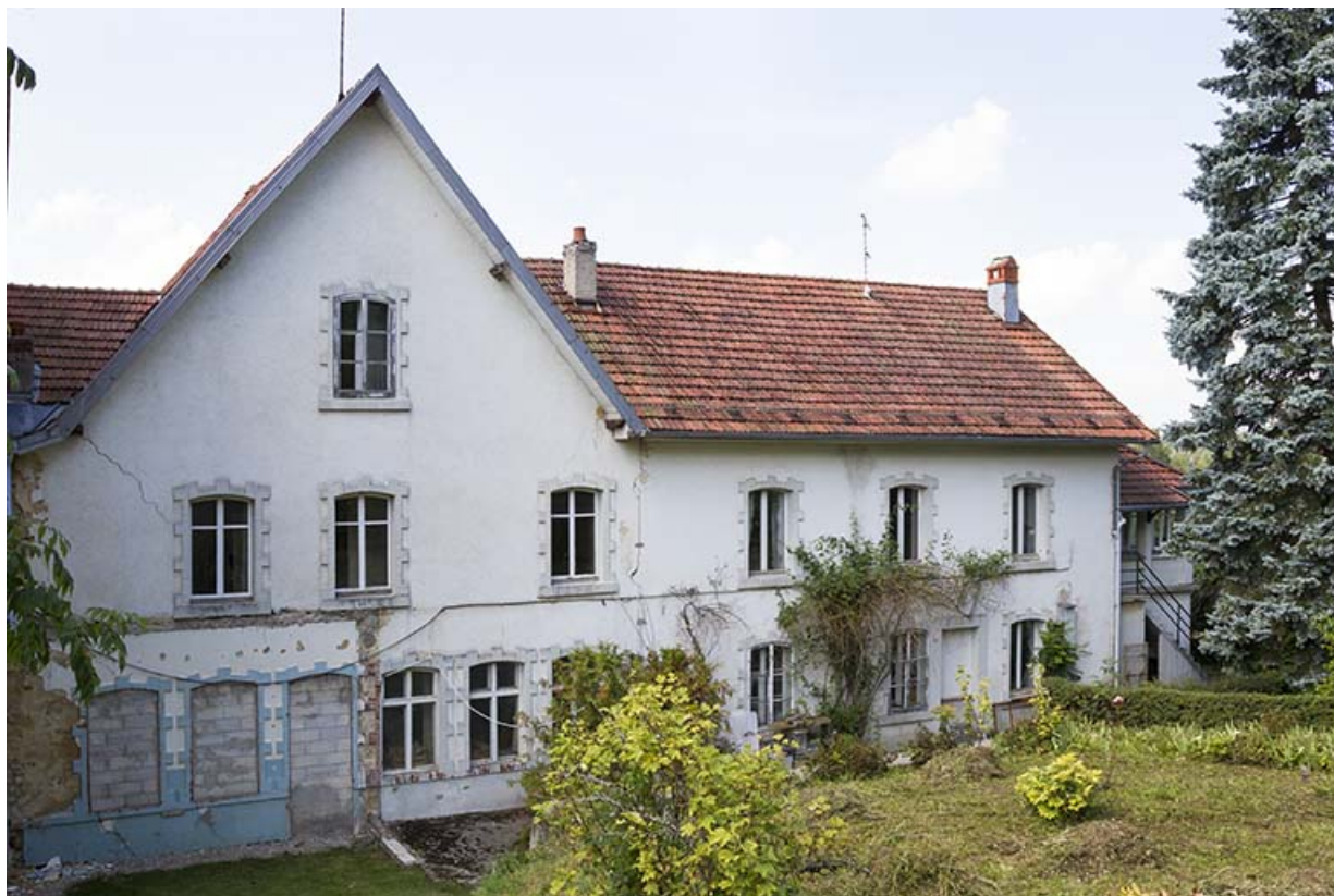
Bâtiments du 1er quart du 20e siècle : façade postérieure.
