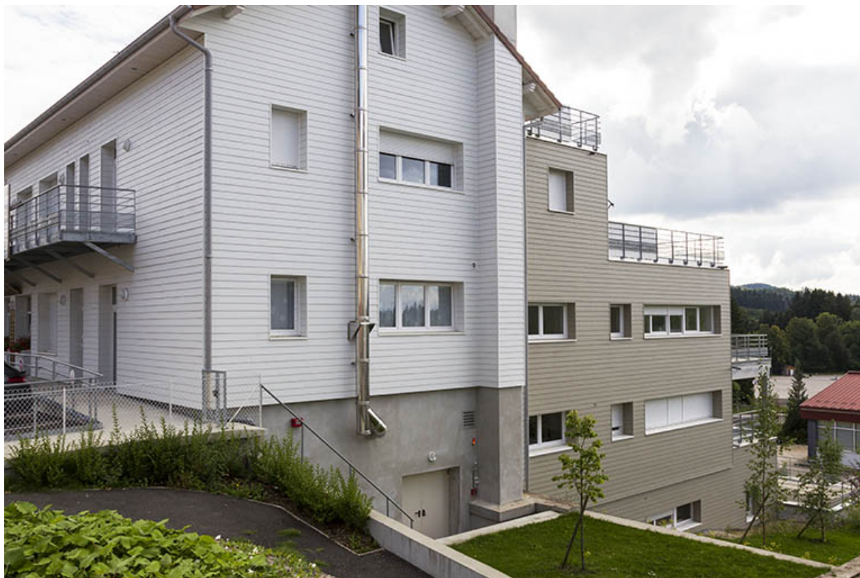
Bâtiments du 3e quart du 20e siècle : façade latérale droite.
