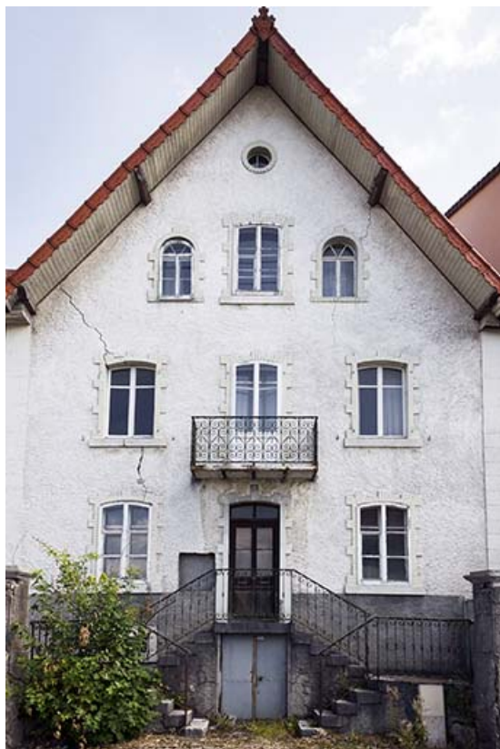
Bâtiment des années 1914-1918 : façade antérieure. 25, Maîche, 19, 21, 26 rue de Saint-Hippolyte
