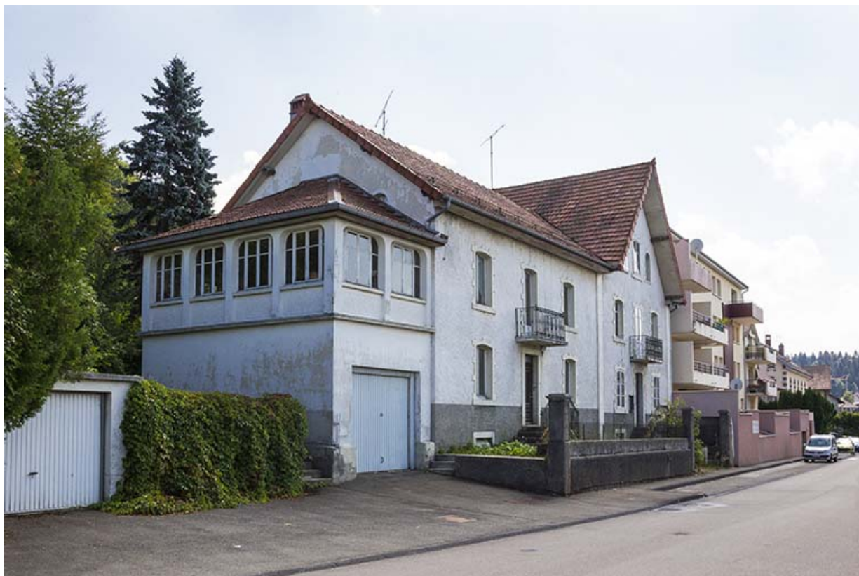
Usine n° 1 (Ets Joseph Jeambrun), au 26 rue de Saint-Hippolyte à Maîche. 25, Maîche, 19, 21, 26 rue de Saint-Hippolyte
