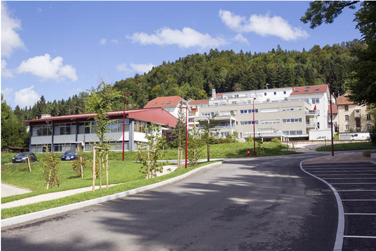
Une grosse entreprise : l'usine d'ébauches de montre Joseph Jeambrun (1900) puis France Ebauches, aux 19, 21 et 26 rue de Saint-Hippolyte. Usine aux n° 19 et 21 (1957-1958, 1971) à l'arrière-plan à droite, usine Robert Jeambrun (1961-1962) à gauche. 25, Maïche, 19, 21, 26 rue de Saint-Hippolyte
