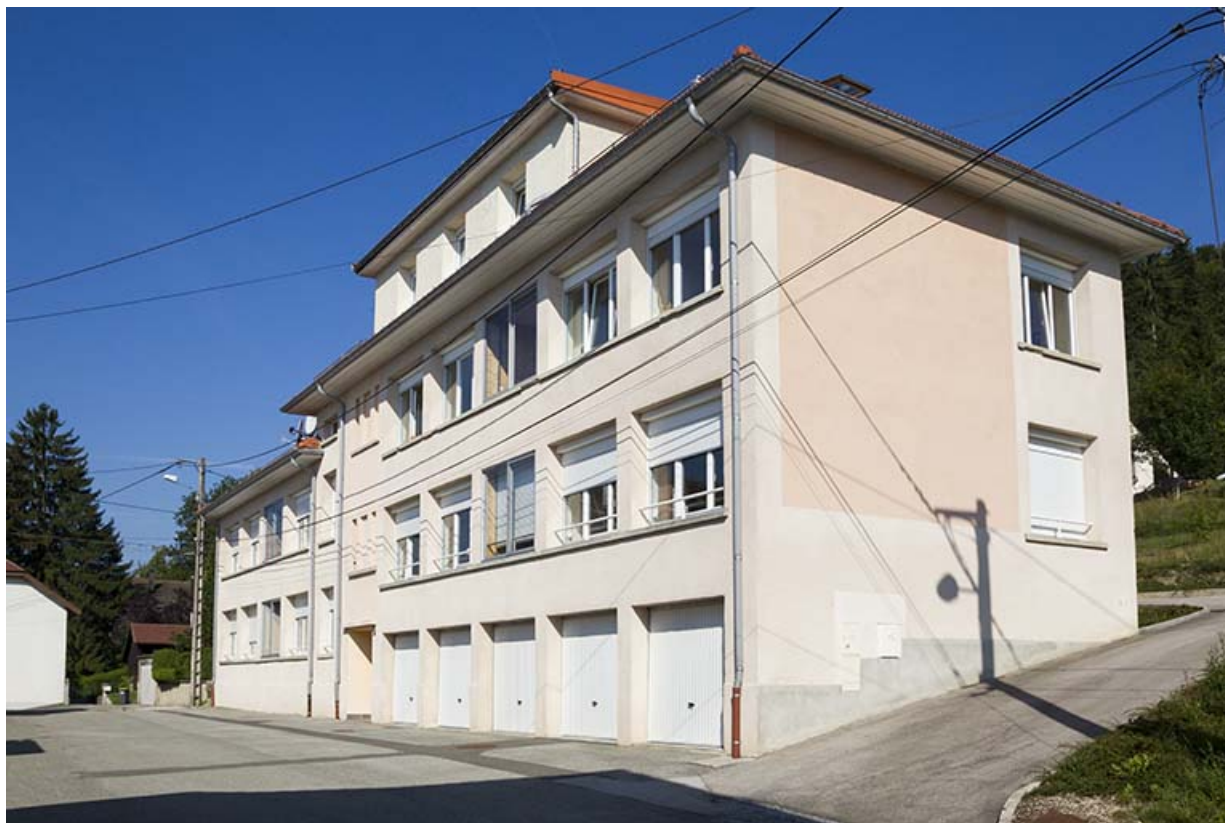
Vue d'ensemble, depuis l'est (façades antérieure et latérale droite). 25, Maîche
