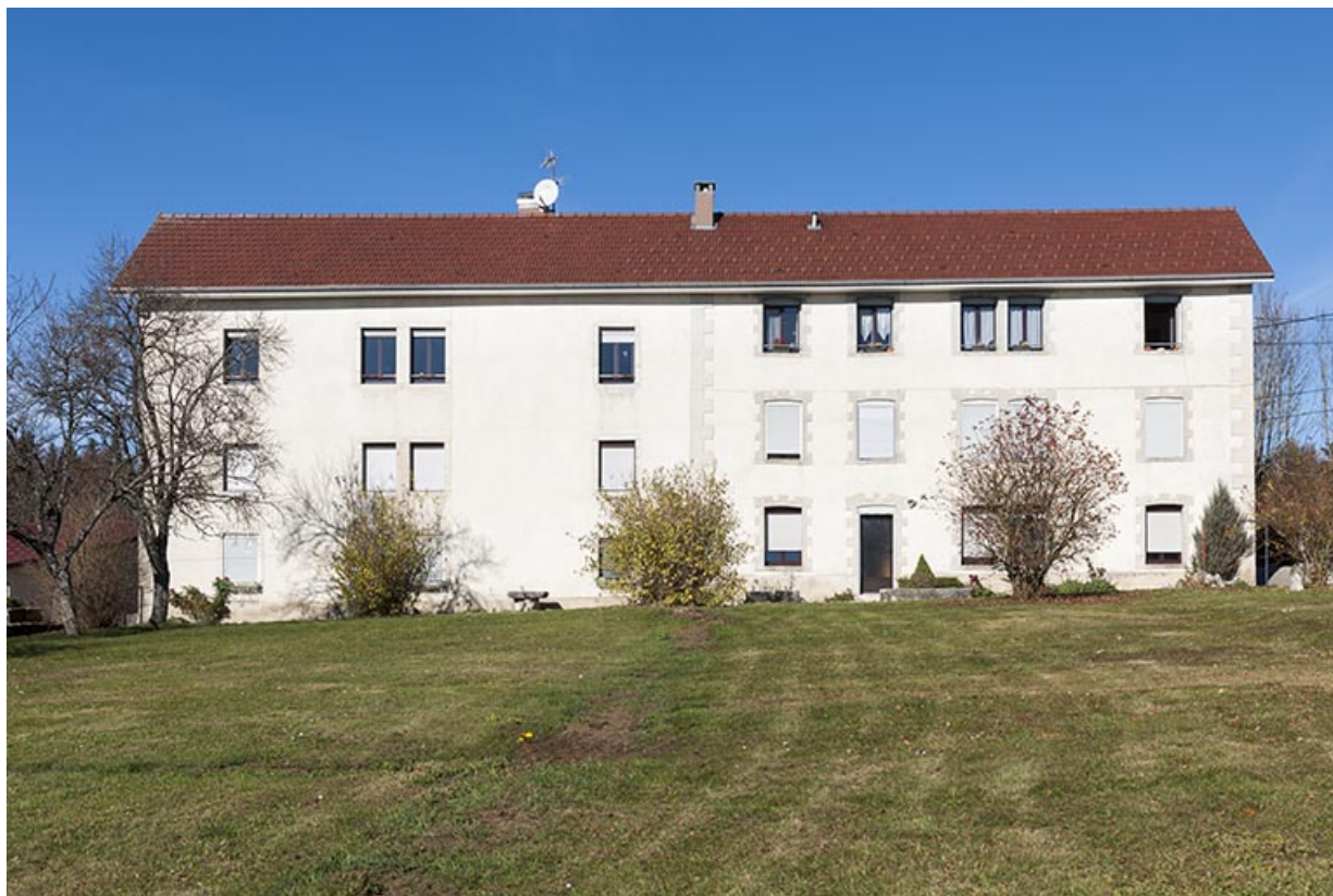
Ferme (à gauche) et atelier (à droite). 25, Maîche
