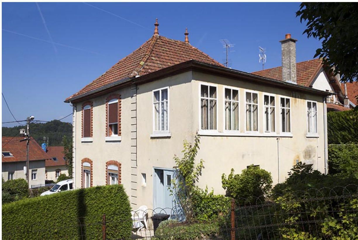
Vue d'ensemble, depuis l'est (façade latérale droite de la maison et atelier de fabrication). 25, Maîche
