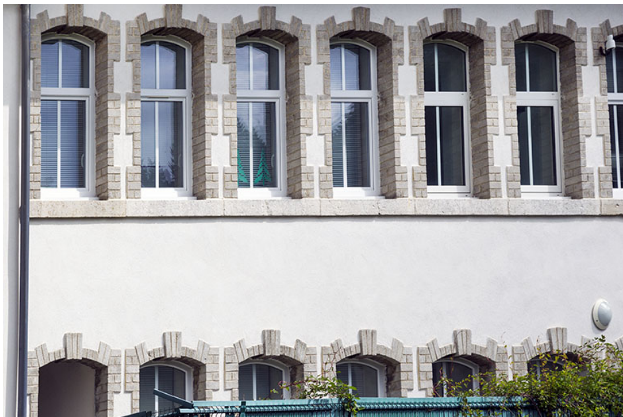
Atelier d'origine : fenêtres multiples. 25, Maîche
