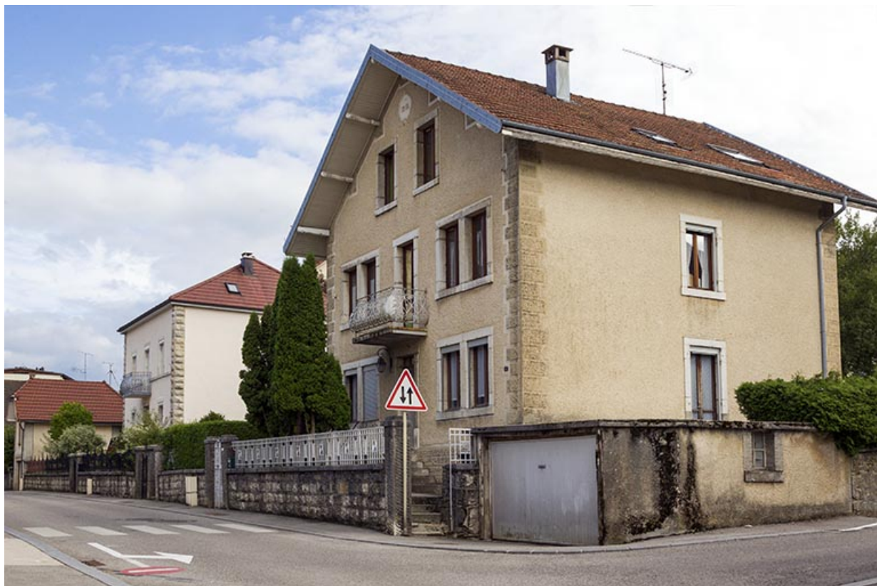
Vue d'ensemble du site, depuis l'ouest. 25, Maïche
