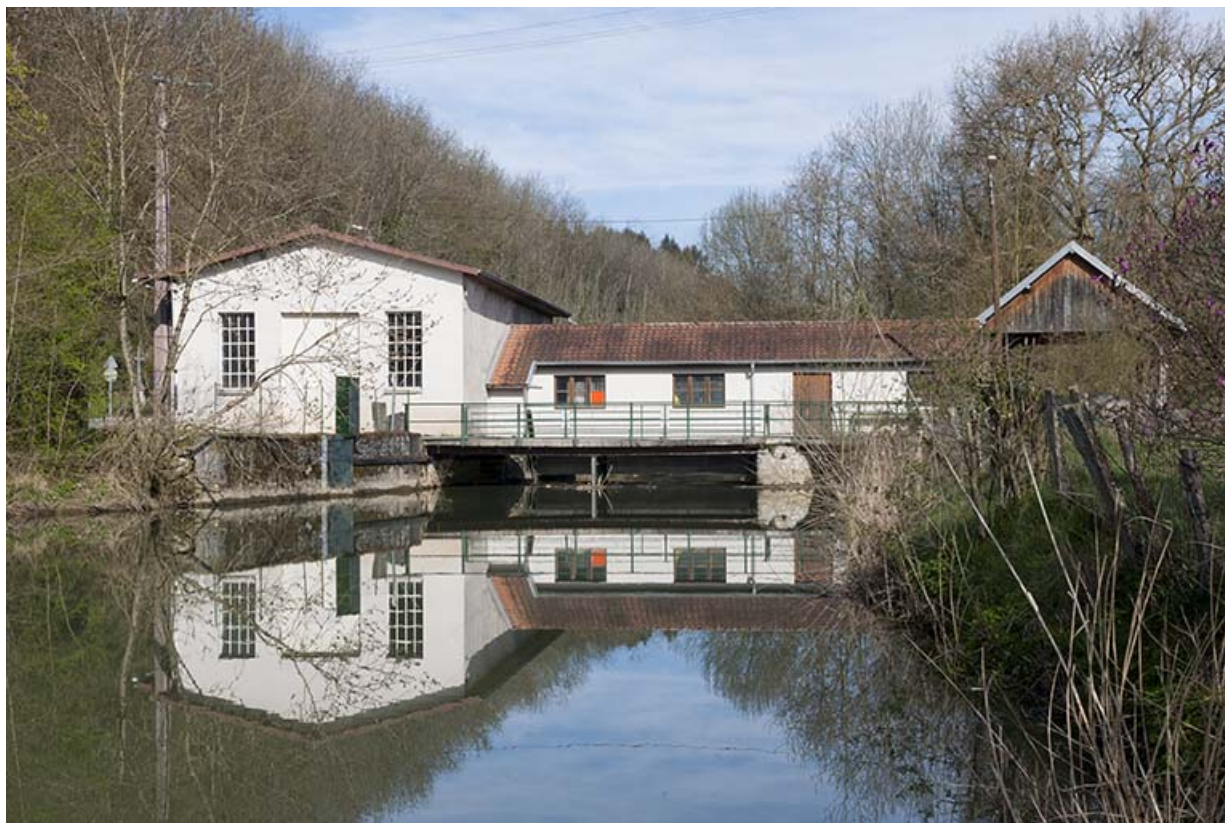
Vue d'ensemble depuis l'amont du bief de dérivation.
