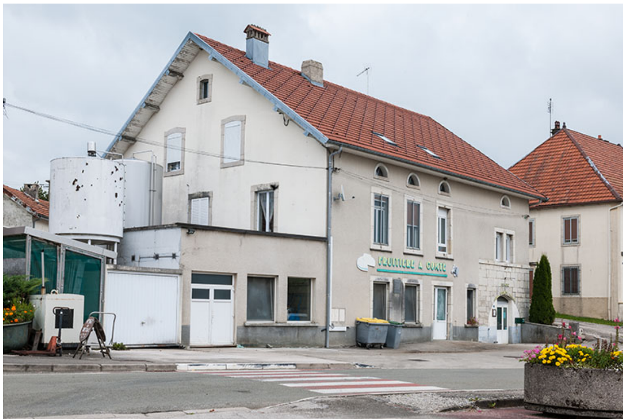
Vue depuis le sud-ouest. 25, Avoudrey Grande Rue
