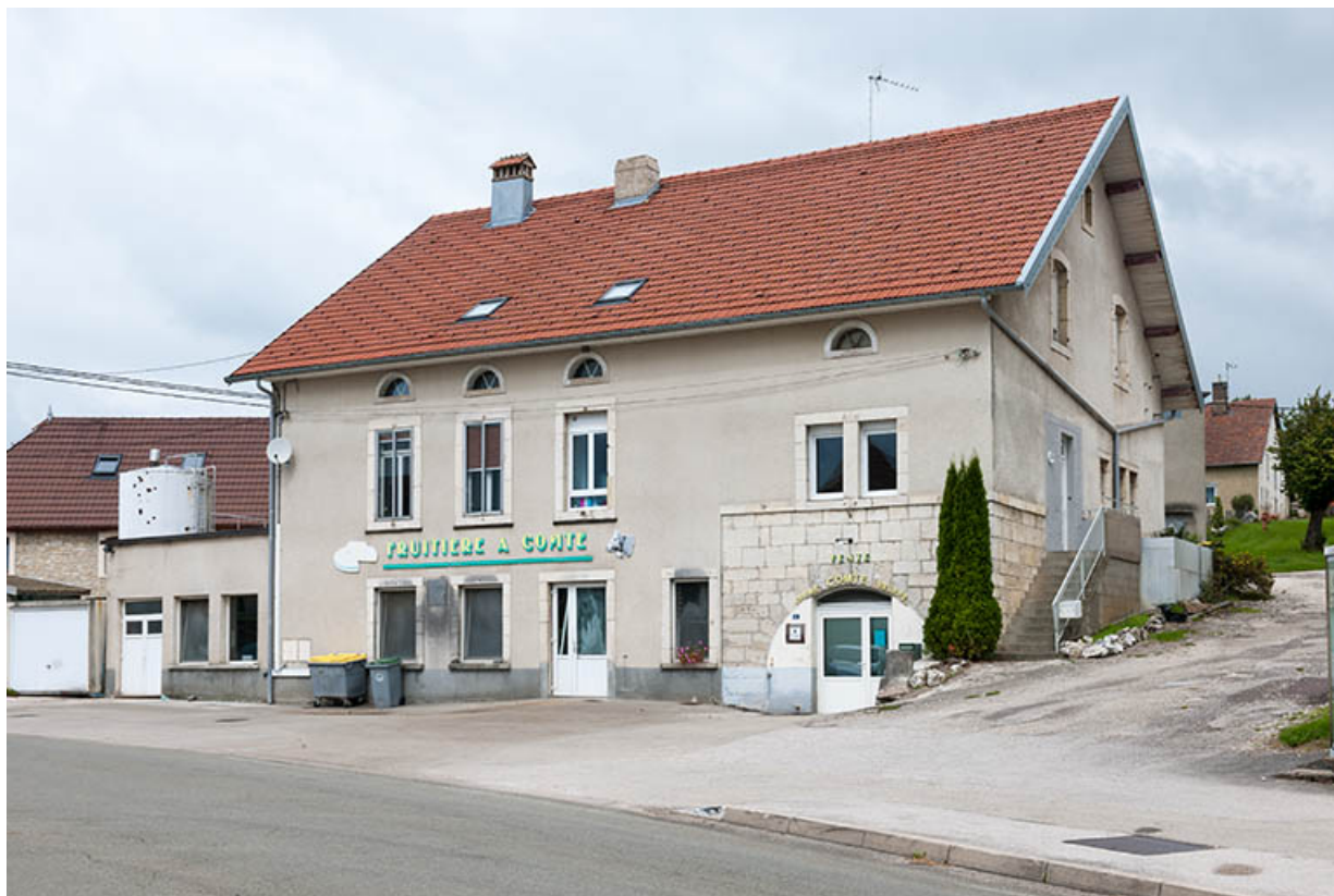
Vue d'ensemble depuis le sud.
