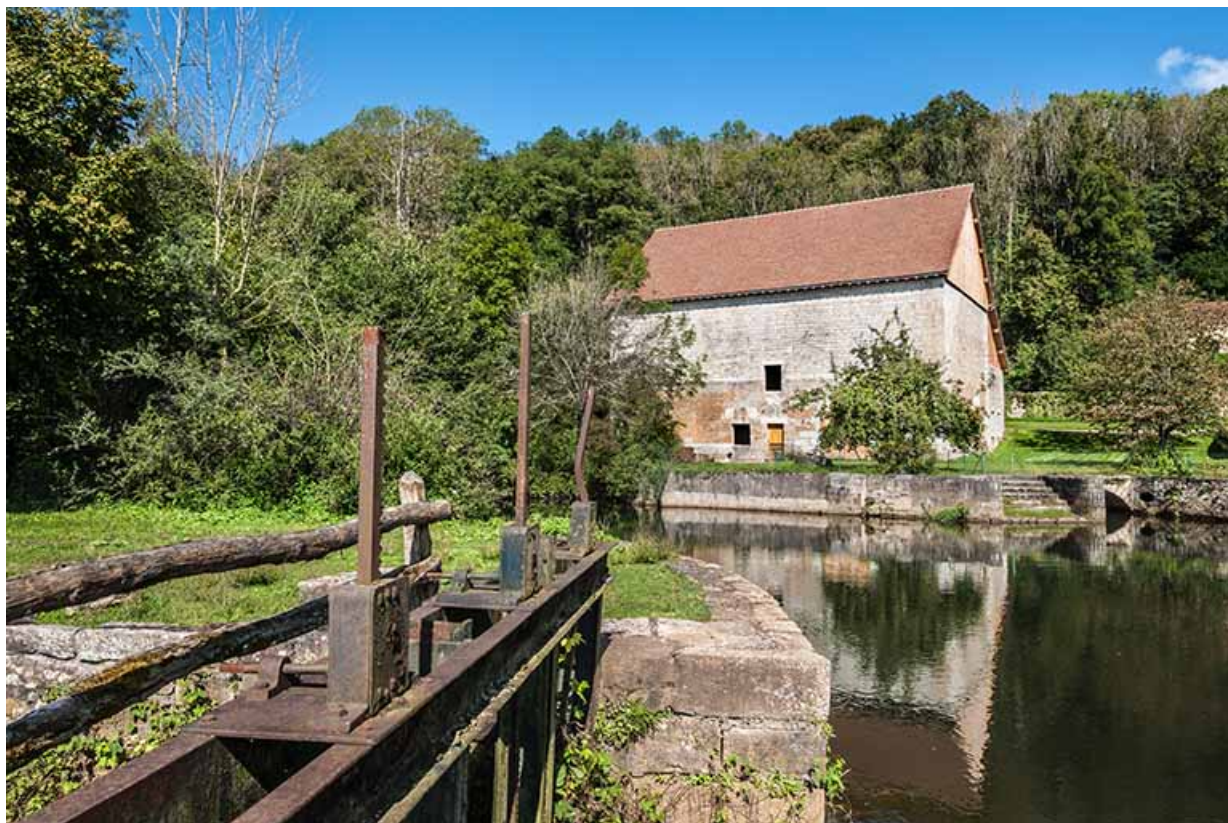
Bâtiment du haut fourneau depuis le vannage de l'ancien atelier de forge.
