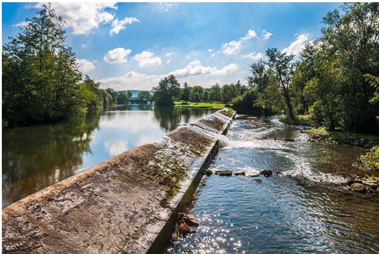
Vue d'ensemble du barrage depuis la rive droite.
