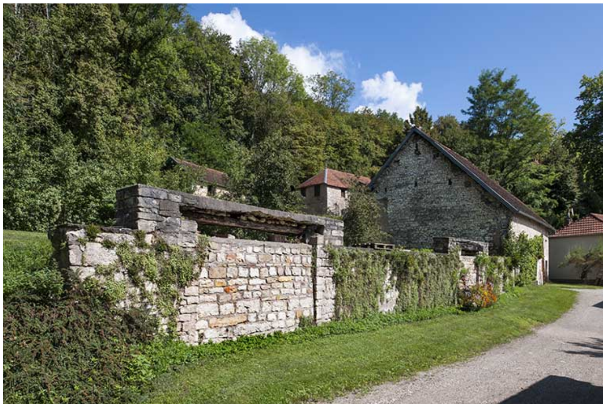
Vestiges de la halle à charbon (premier plan) et bâtiment agricole.
