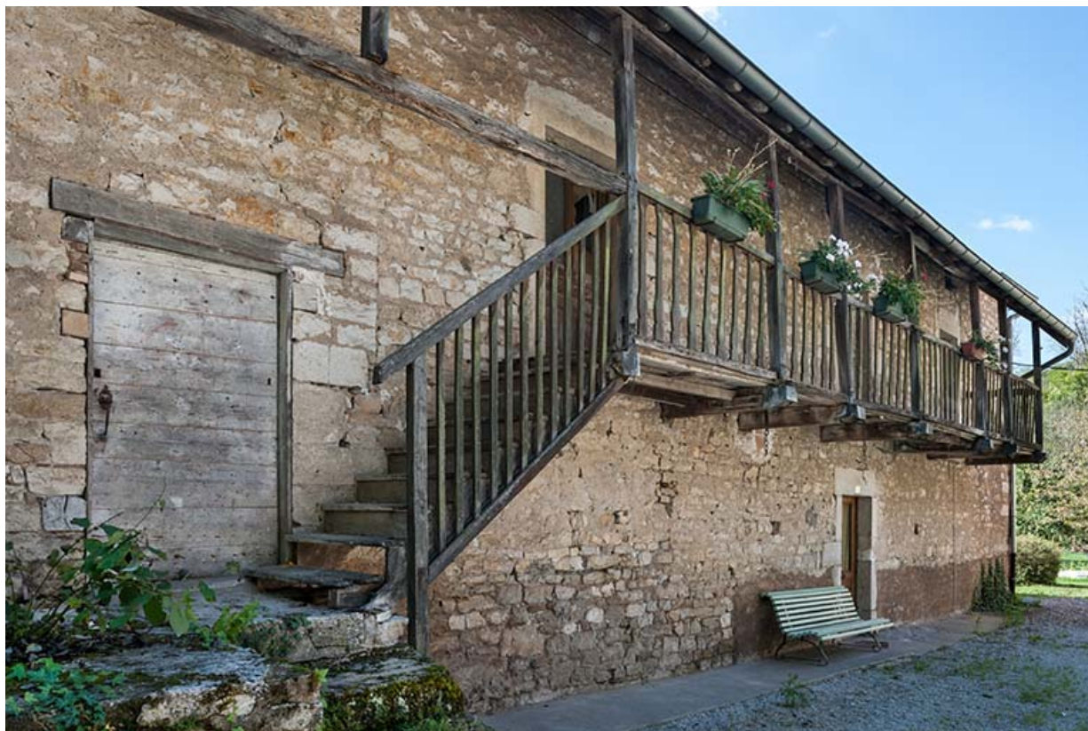
Détail de la façade nord du logement patronal.
