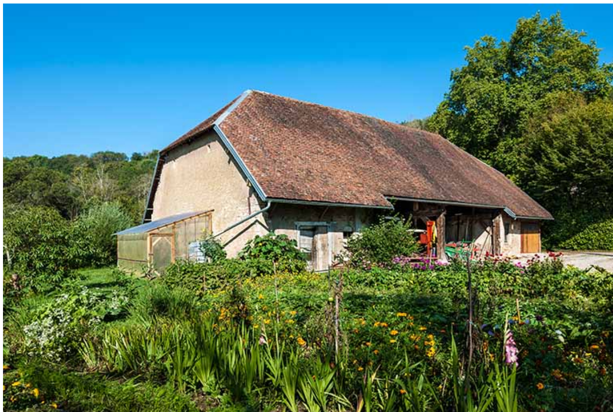
Vue du magasin industriel depuis le sud-est. 25, Montagney-Servigny rue du Haut fourneau
