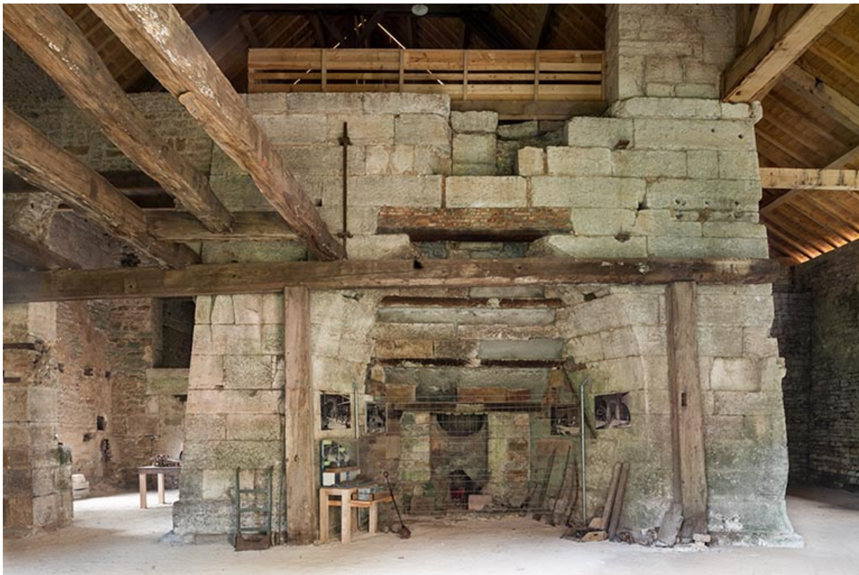
Haut fourneau, vu de face.
