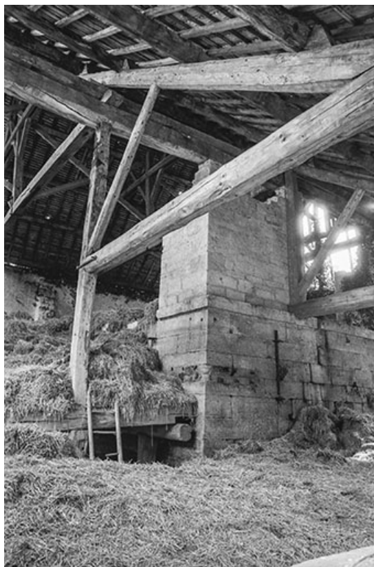
Partie supérieure du haut-fourneau.
