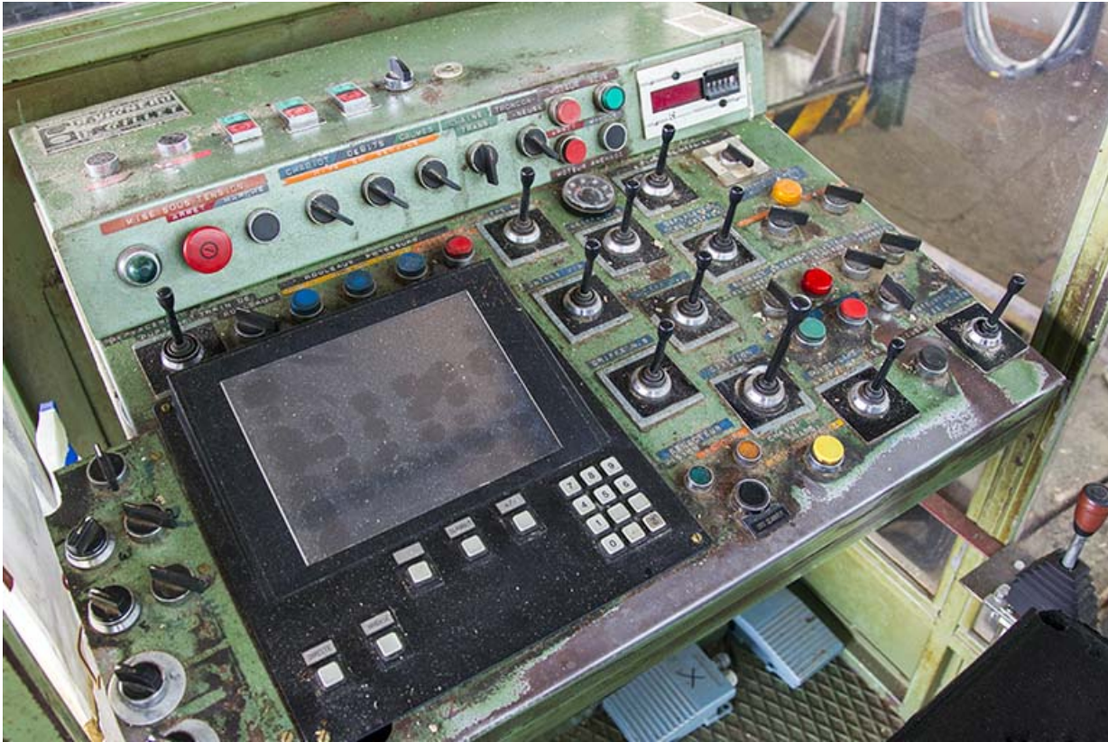
Atelier de fabrication de 1980-1982 : pupitre du poste de commande de la scie Gillet et Vigneau.
