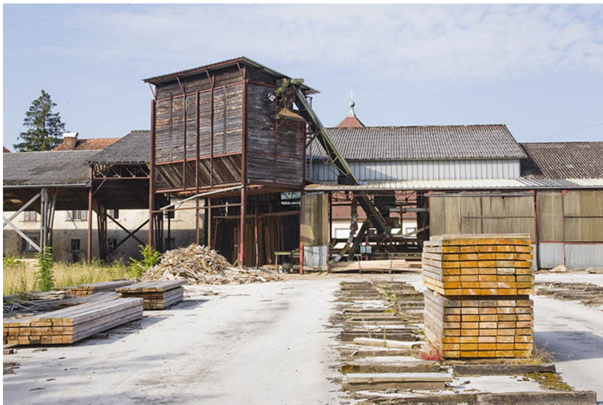
Silo à sciure et hangar de 1969-1970.
