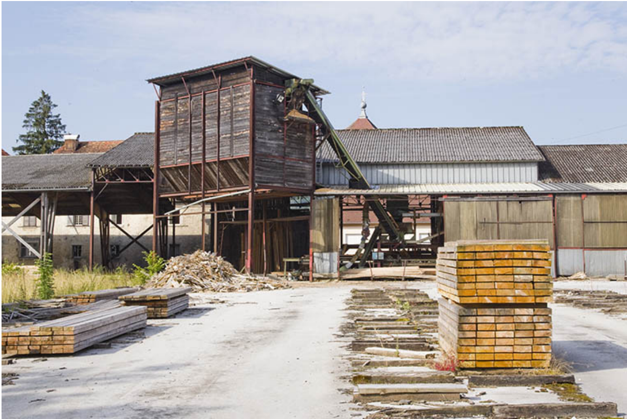
Silo à sciure et hangar de 1969-1970.
