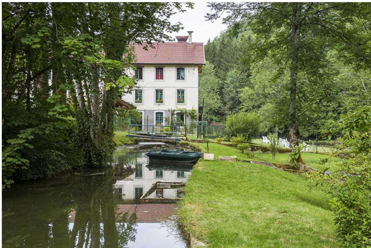
Moulin, façade antérieure : bief d'aménée.
