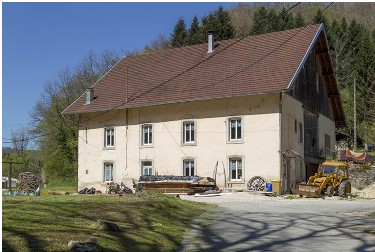
Site du moulin : logement d'ouvriers, depuis l'ouest.
