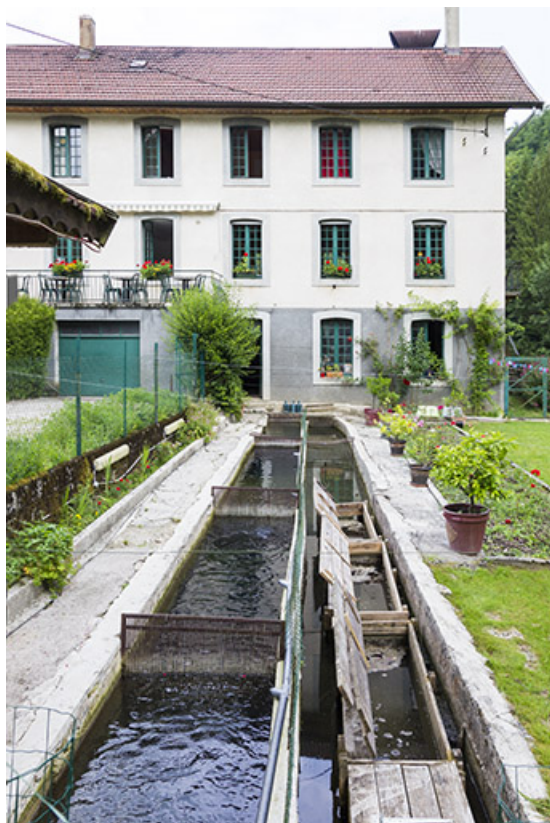
Moulin, façade antérieure : bief d'aménée transformé en vivier.
