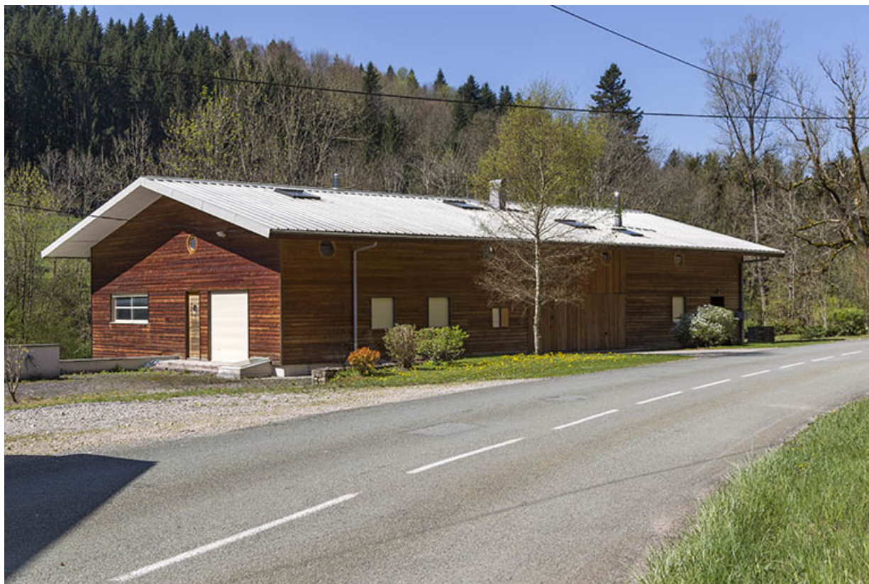
Site de la scierie : atelier de fabrication refait, depuis le nord-est.
