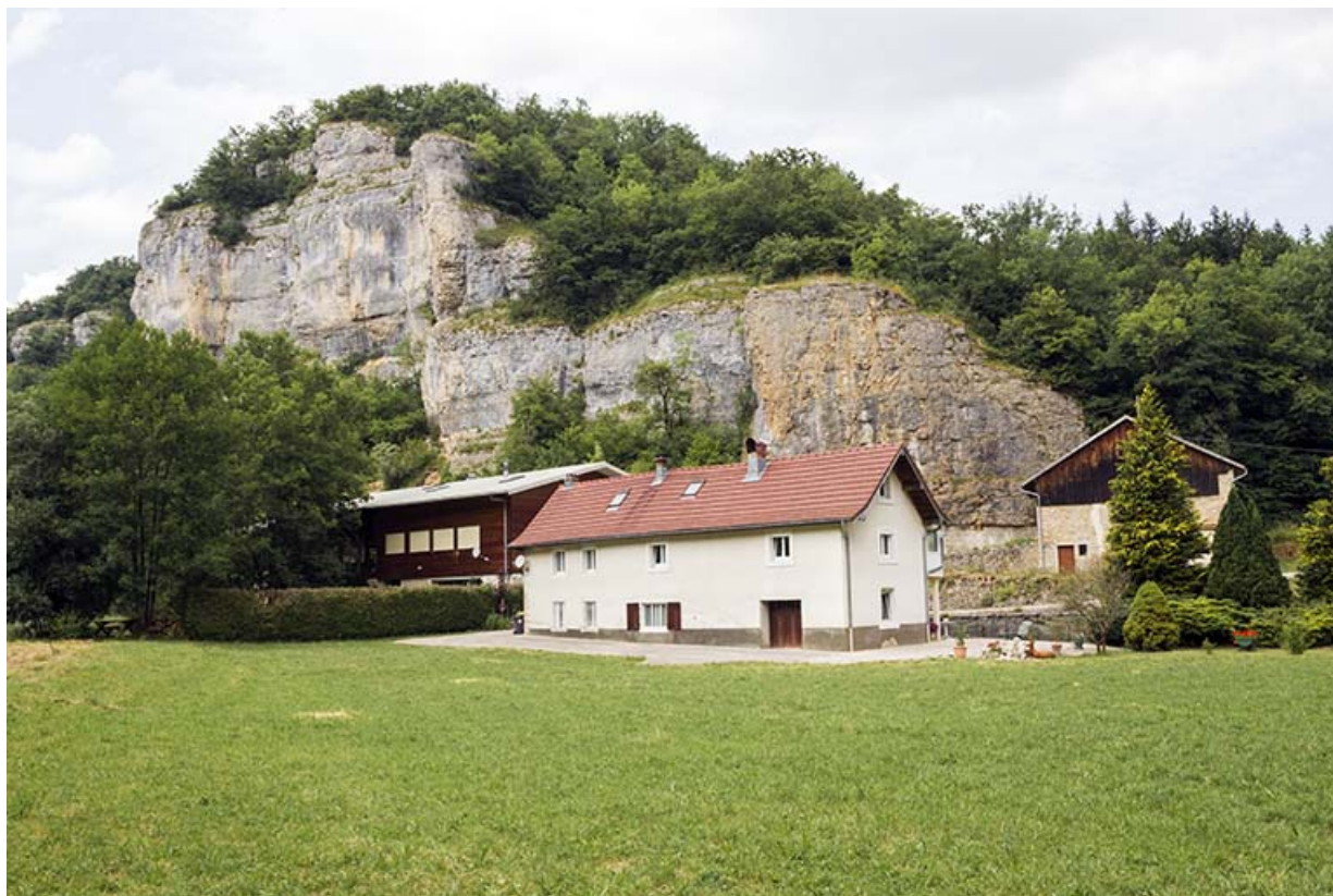
Site de la scierie : vue d'ensemble, depuis le sud-est.
