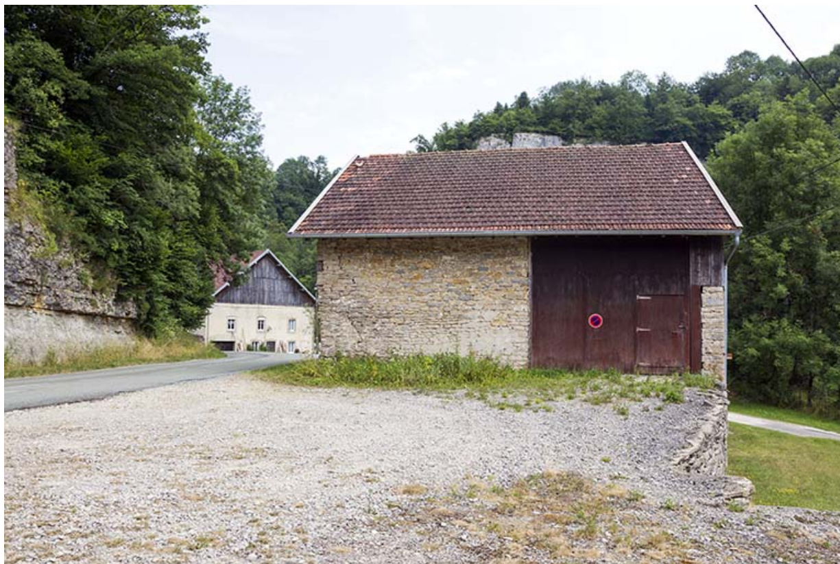
Site de la scierie : remise et étable (avec à l'arrière-plan le logement d'ouvriers proche du moulin). 25, Cour-Saint-Maurice, lieudit : le Moulin du Bas
