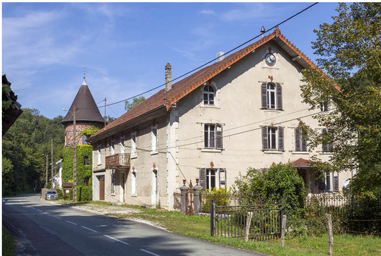
Logement patronal de 1900 : façades antérieure et latérale droite.
