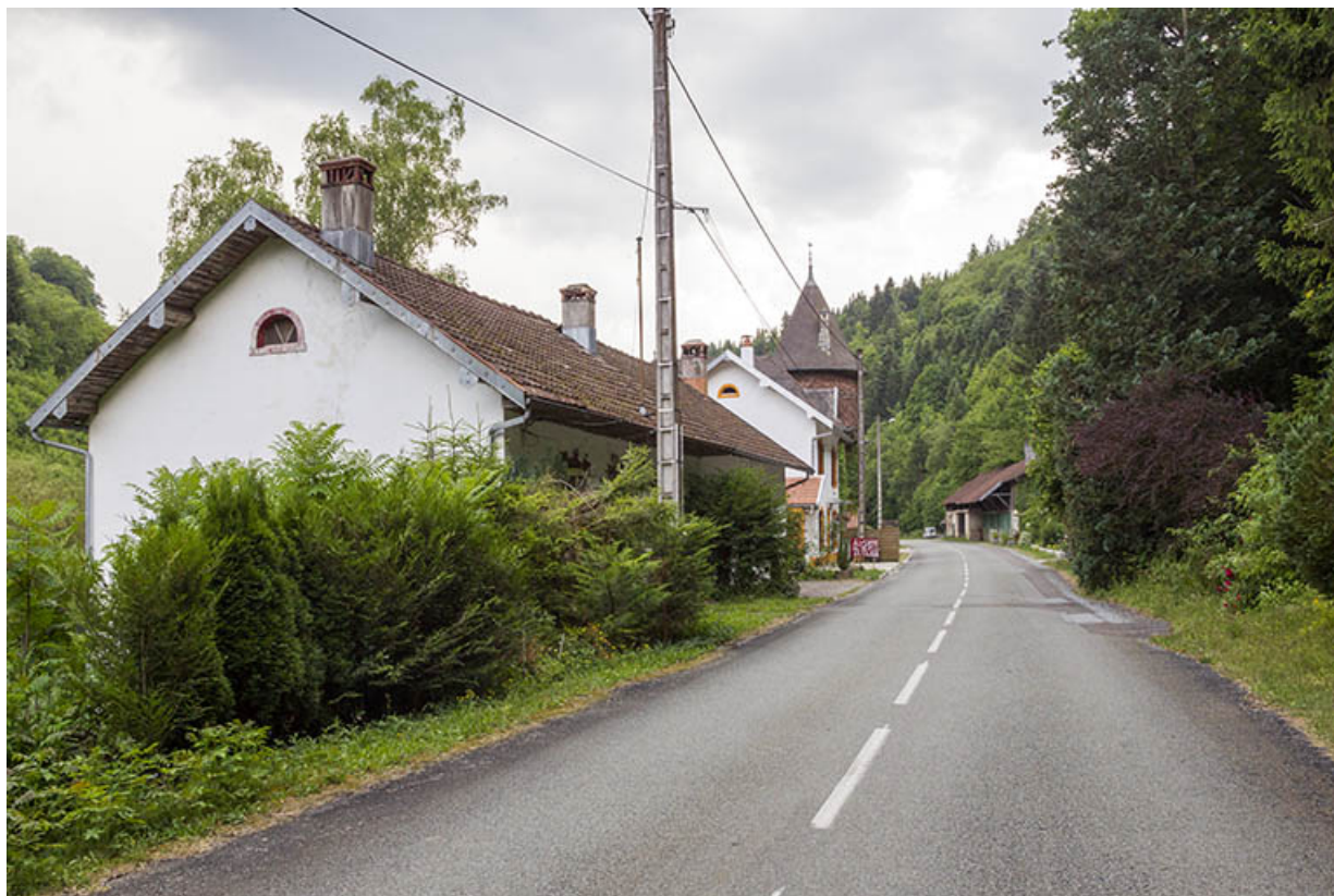
Vue d'ensemble du site, depuis le nord.
