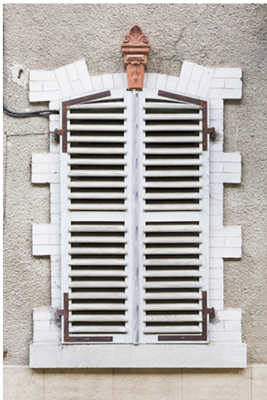
Logement patronal de 1900, façade antérieure : une fenêtre.
