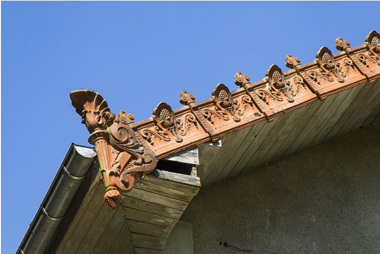
Logement patronal de 1900, façade latérale droite : acrotère et tuiles de rive en céramique.
