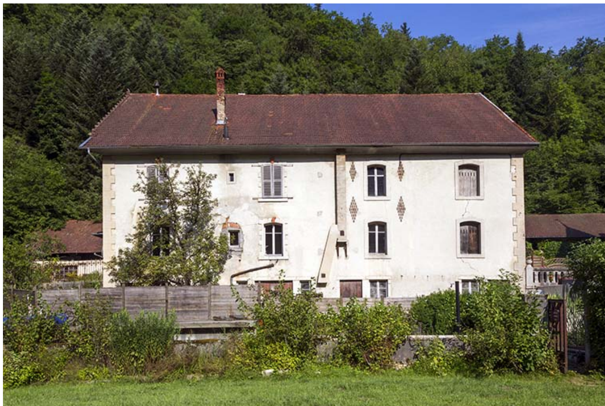
Logement patronal de 1900 : façade postérieure.
