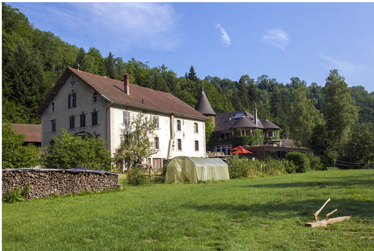
Vue d'ensemble du site, depuis le sud-est.
