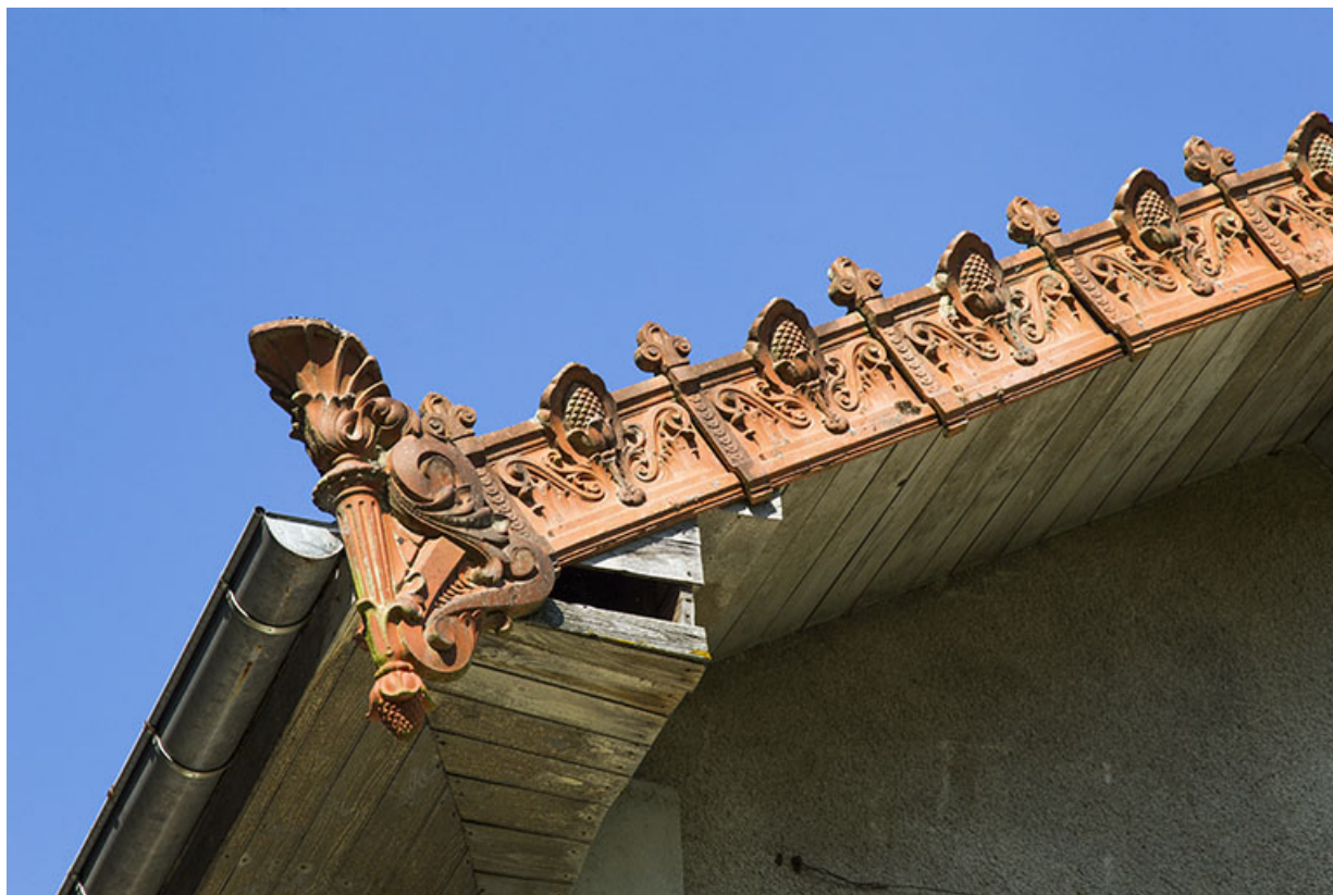
Logement patronal de 1900, façade latérale droite : acrotère et tuiles de rive en céramique. 25, Vaucluse, lieudit : le Moulin du Milieu
