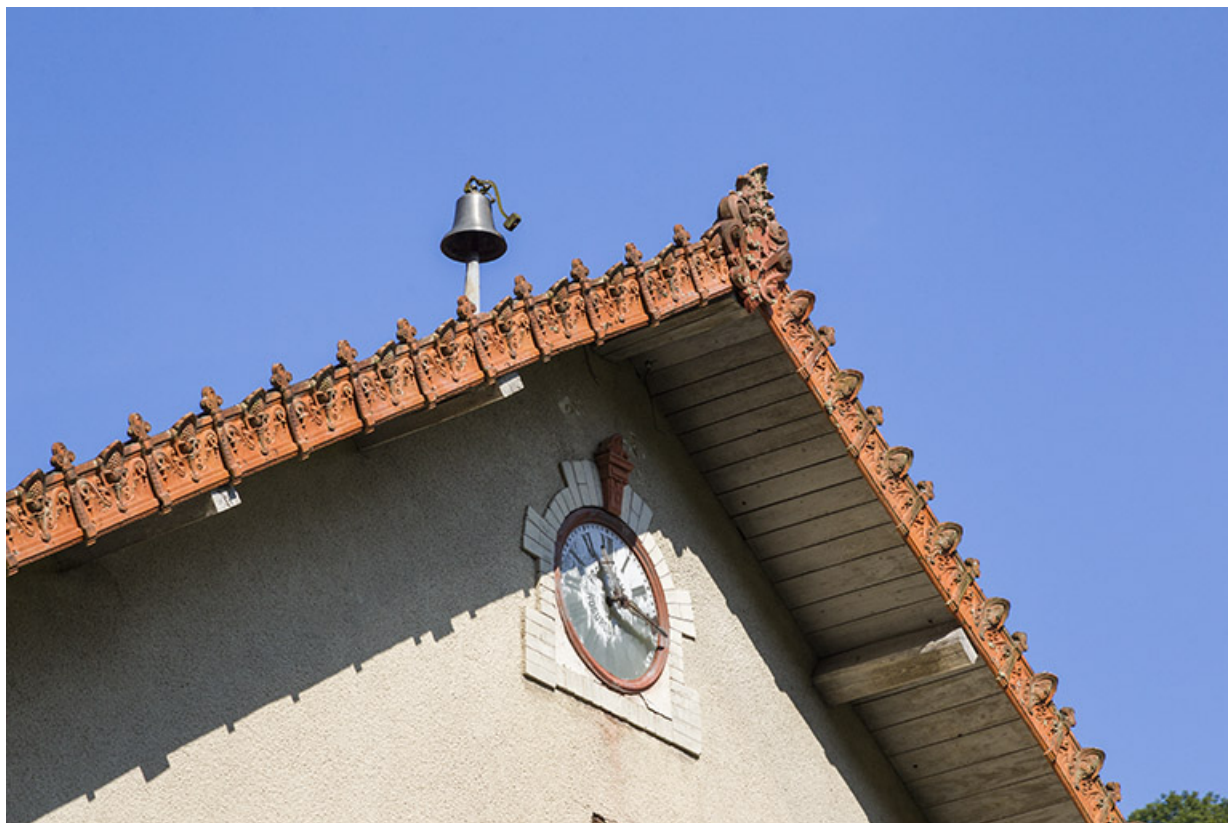
Logement patronal de 1900, façade latérale droite : horloge et cloche.
