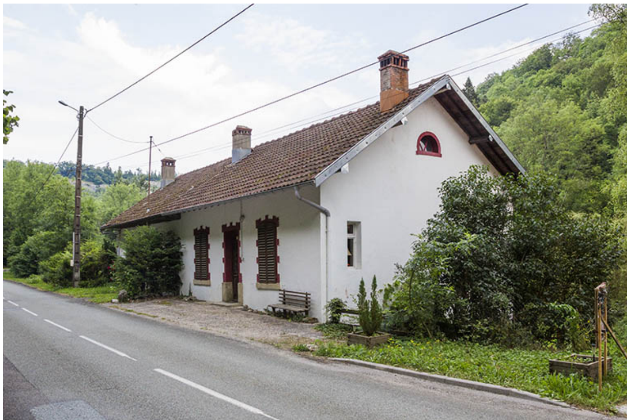
Logements d'ouvriers : vue d'ensemble, depuis le sud-ouest. Logement sud au premier plan. 25, Vaucluse, lieudit : le Moulin du Milieu
