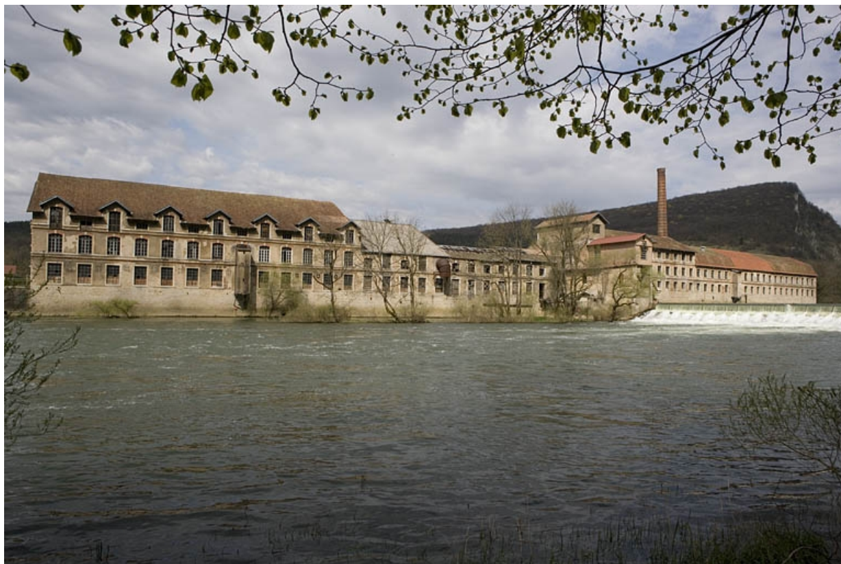
Vue d'ensemble depuis l'aval.
