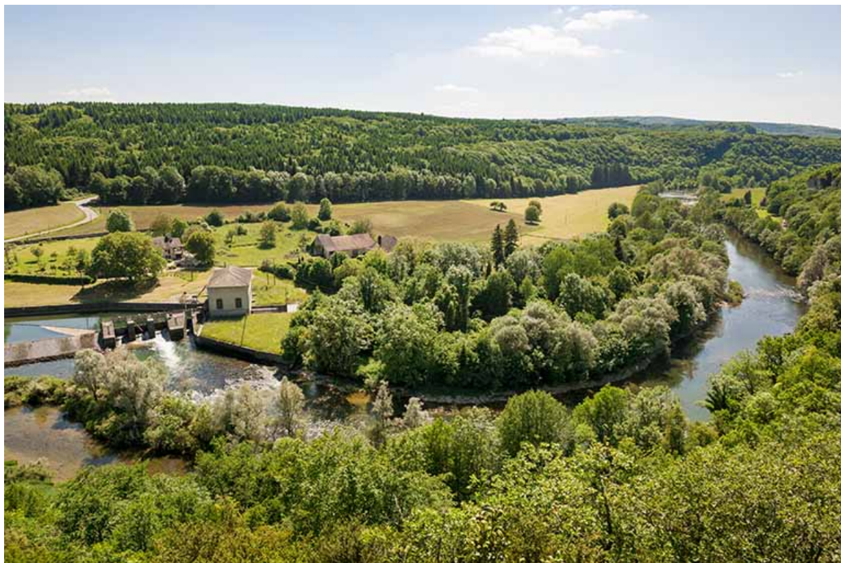
Vue plongeante d'ensemble depuis le nord-est.
