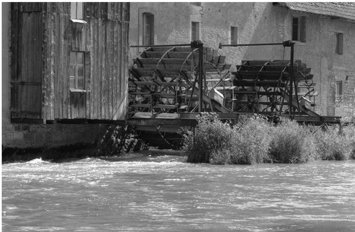
Façade postérieure : les deux roues à aubes.
