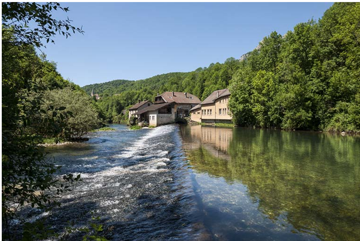
Vue d'ensemble depuis le barrage, en amont.
