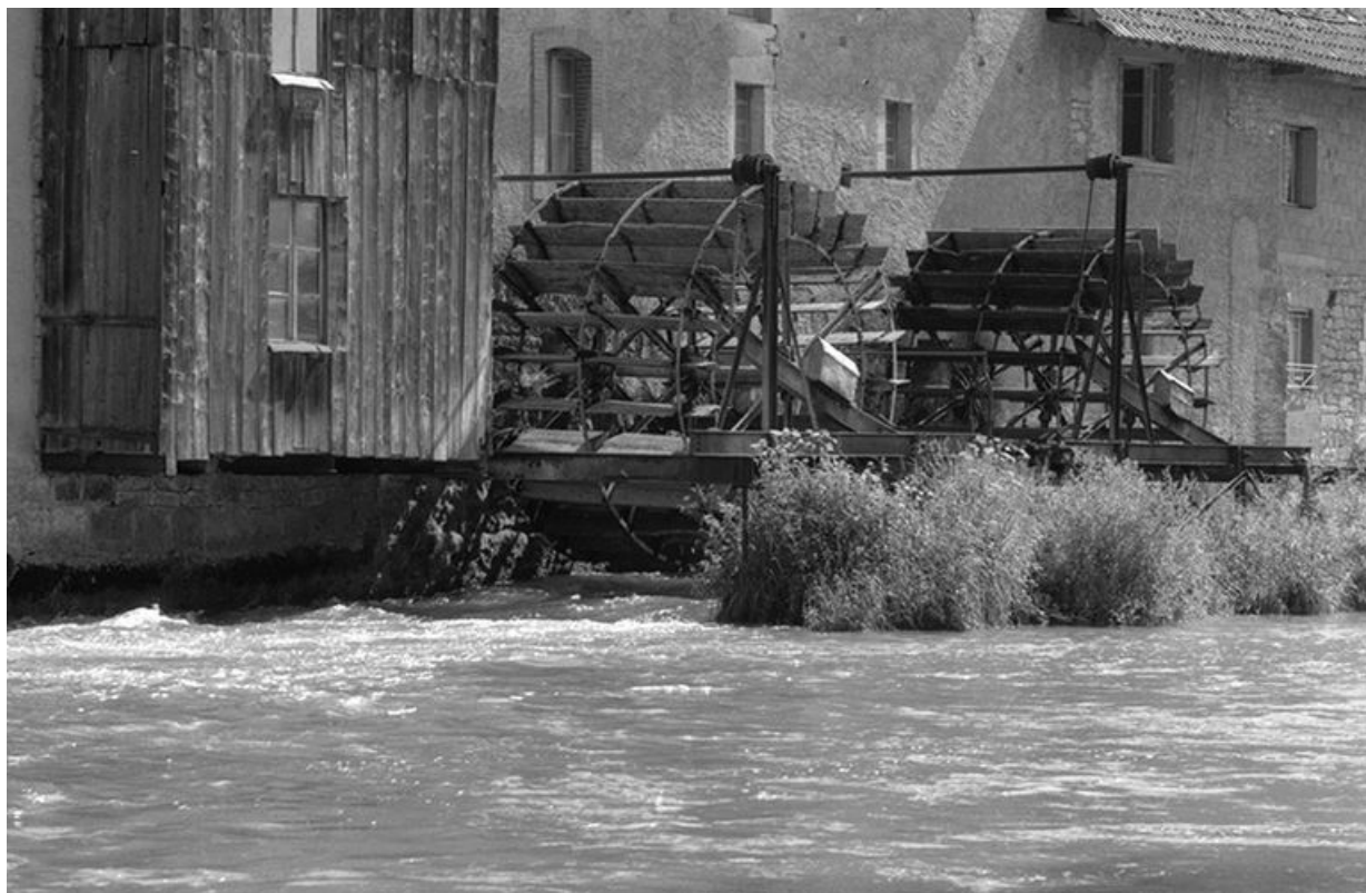
Façade postérieure : les deux roues à aubes.
