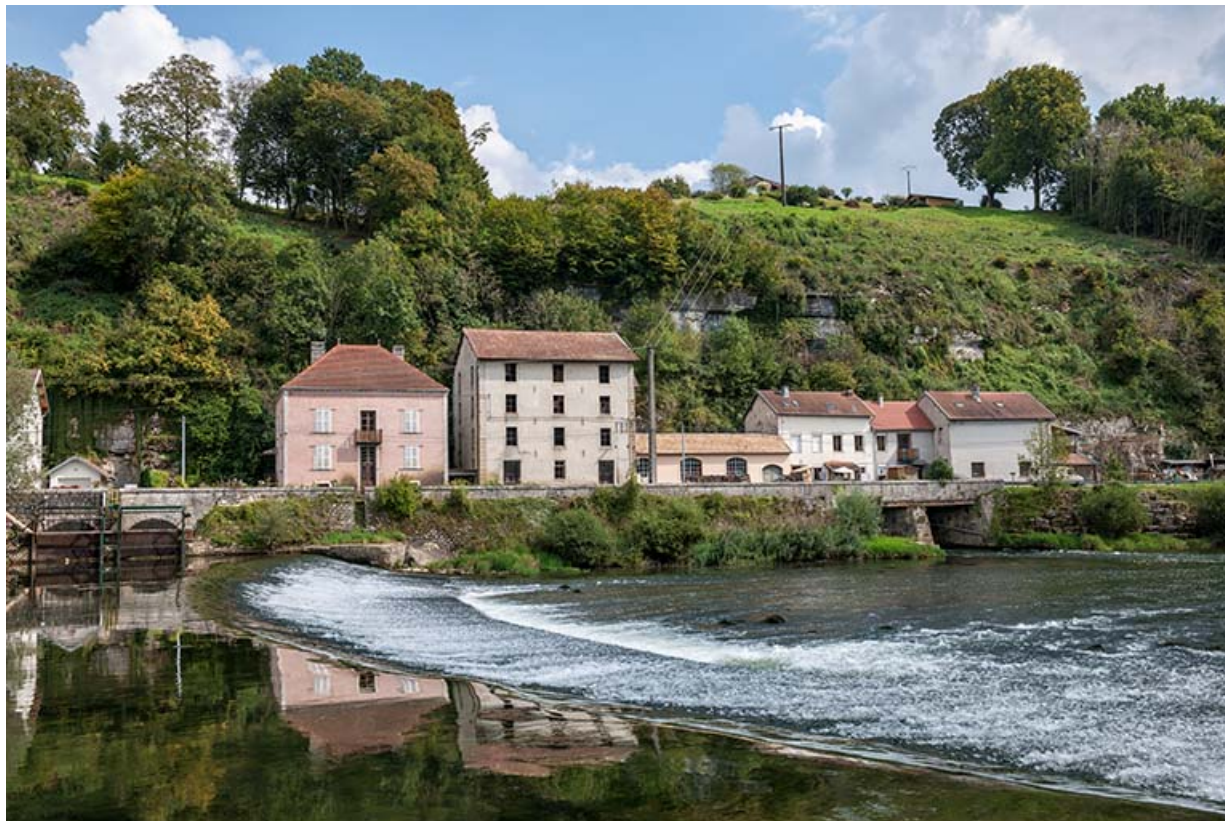
Vue d'ensemble depuis la rive droite.
