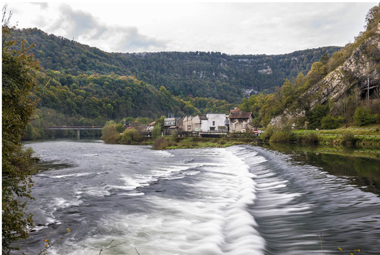
Vue d'ensemble depuis l'extrémité orientale du barrage.
