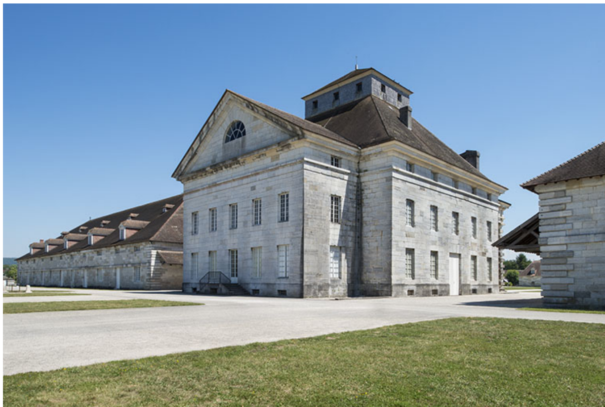
Façade postérieure de la berne est et de la maison du directeur.
