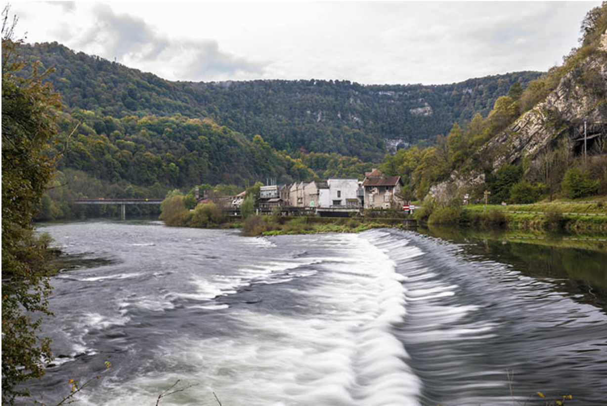
Vue d'ensemble depuis l'extrémité orientale du barrage.
