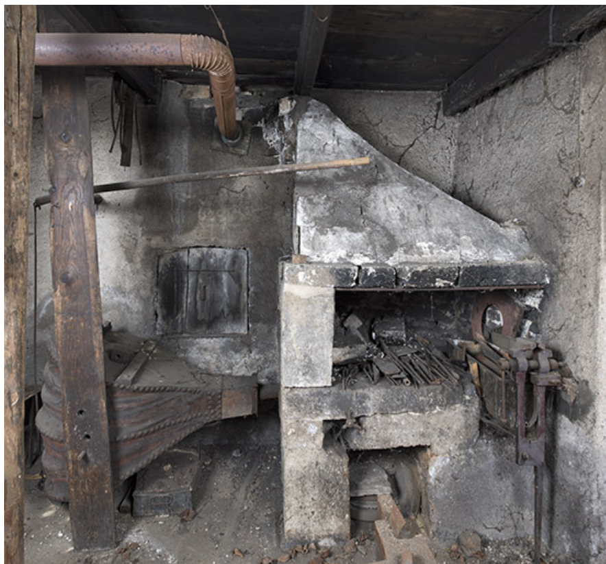
Maison et atelier d'outillage Ducommun, Bourlier, Charton puis Thomann, à Montécheroux : la forge.
