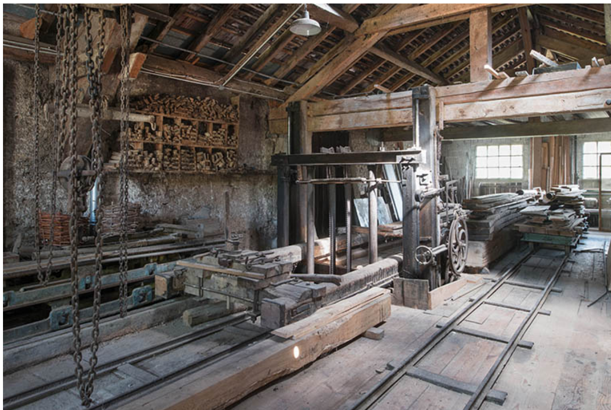
Vue intérieure de l'atelier de scierie.
