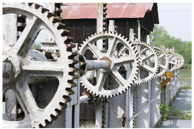
Vannage du barrage. Détail des engrenages.
