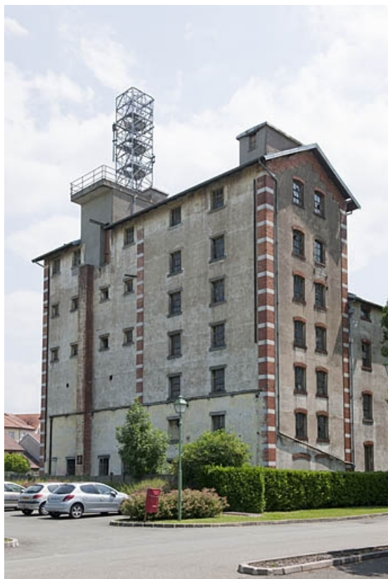
La malterie vue depuis le nord-ouest.
