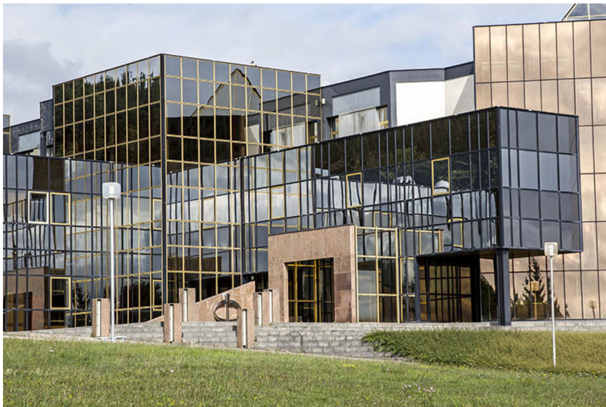
Entrée principale, depuis le sud-ouest.
