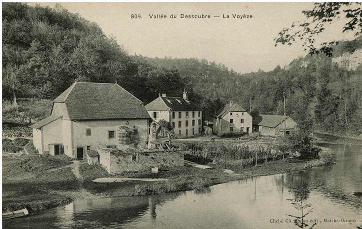
809. Vallée du Dessoubre - La Voyèze, 4e quart 19e siècle (avant 1903). 25, Vauclusotte, lieudit : la Voyèze
