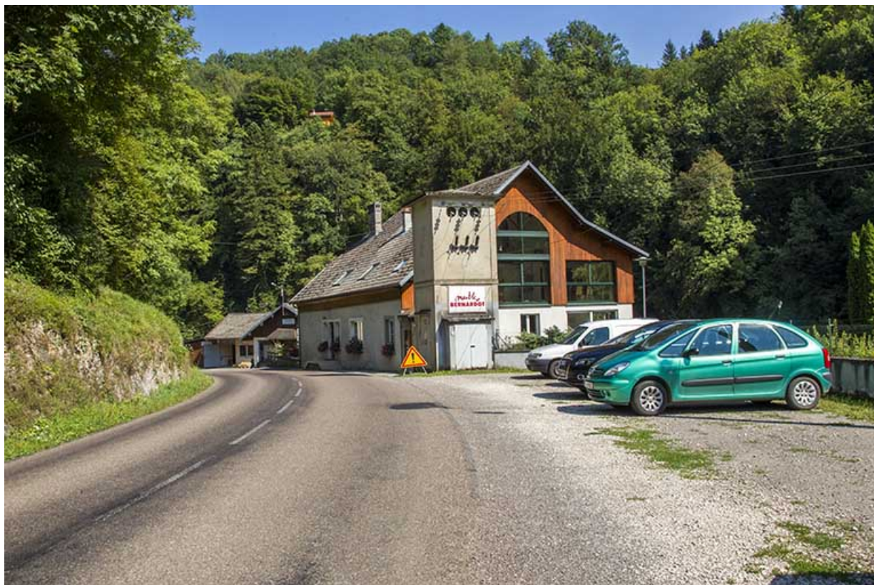
Le logement patronal et le transformateur, depuis la route à l'ouest.
