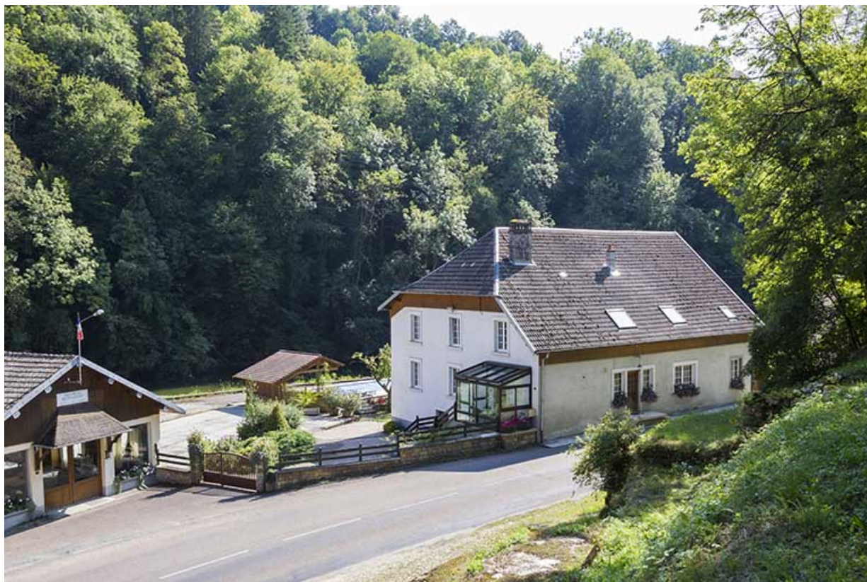
Le magasin et le logement patronal, depuis le nord.
