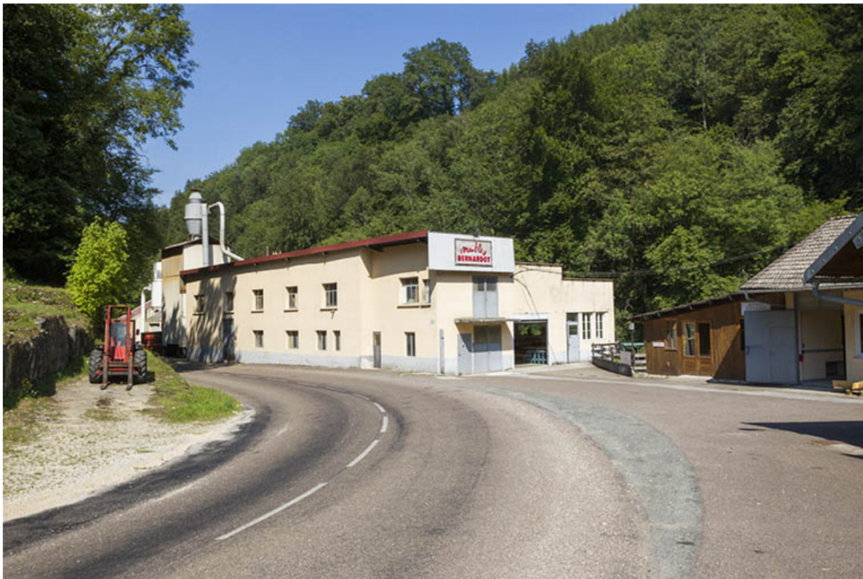
L'usine, depuis la route au sud : bâtiment refait en 1990.
