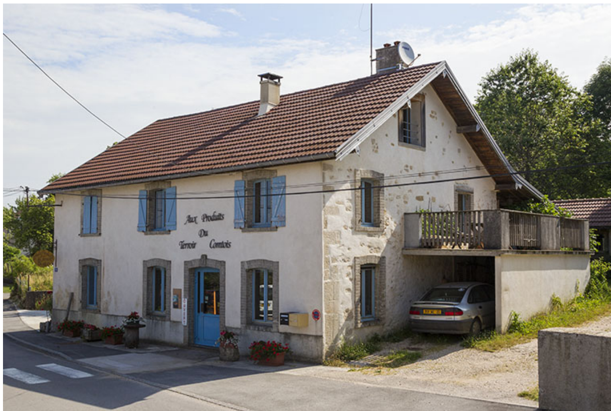
Façades antérieure et latérale droite.
