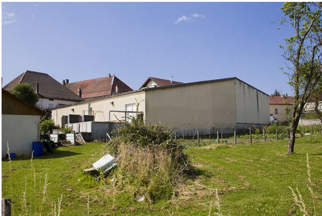
Façades postérieure et latérale gauche des extensions.
