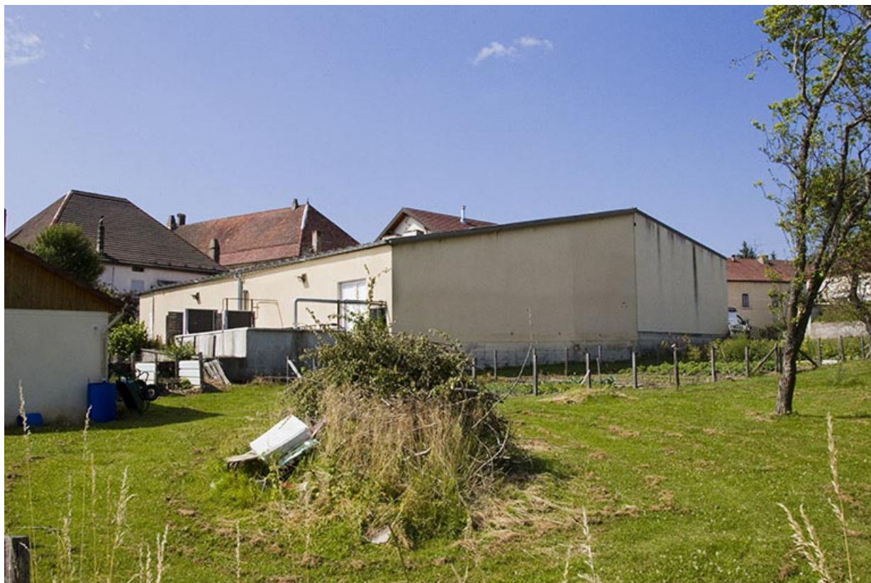
Façades postérieure et latérale gauche des extensions.
