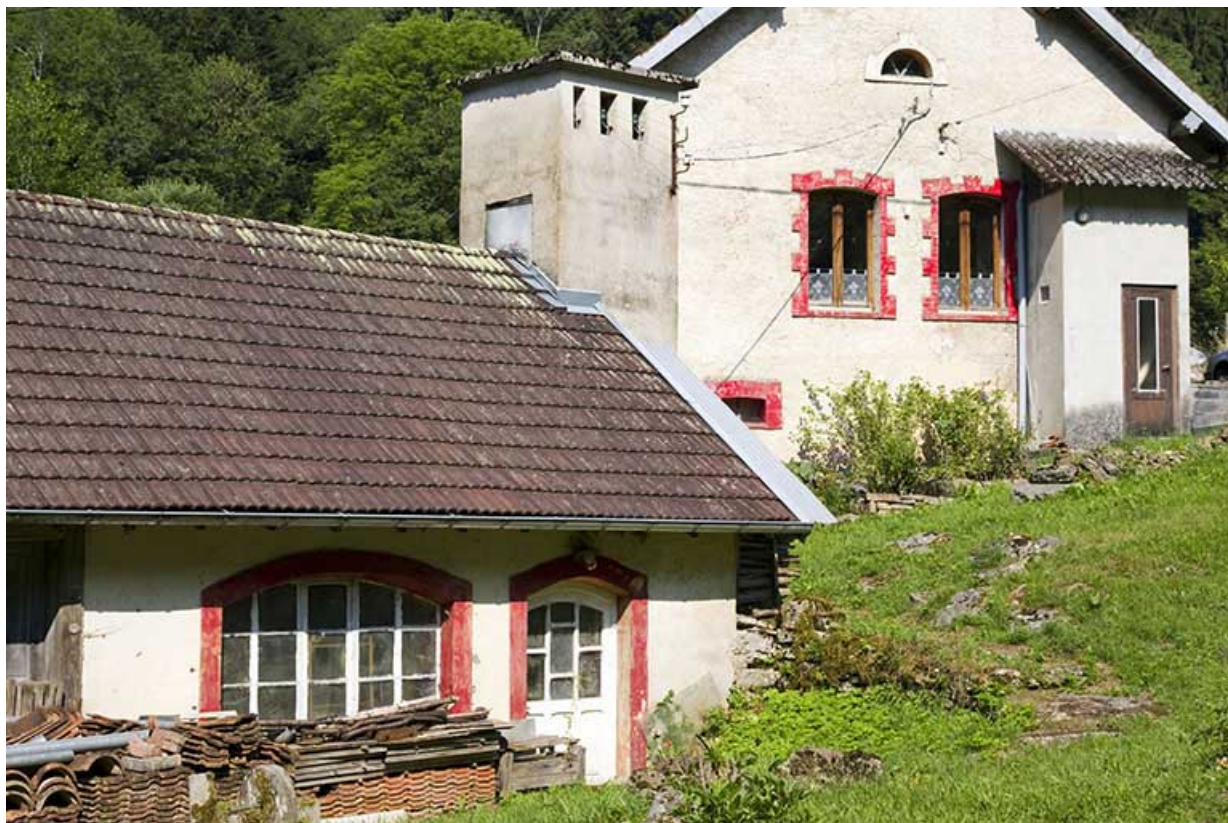
Centrale : extrémité nord de la façade antérieure, avec le logement d'ouvriers en arrière-plan. 25, Battenans-Varin, 2 et 4 rue du Pont, lieudit : Varin
