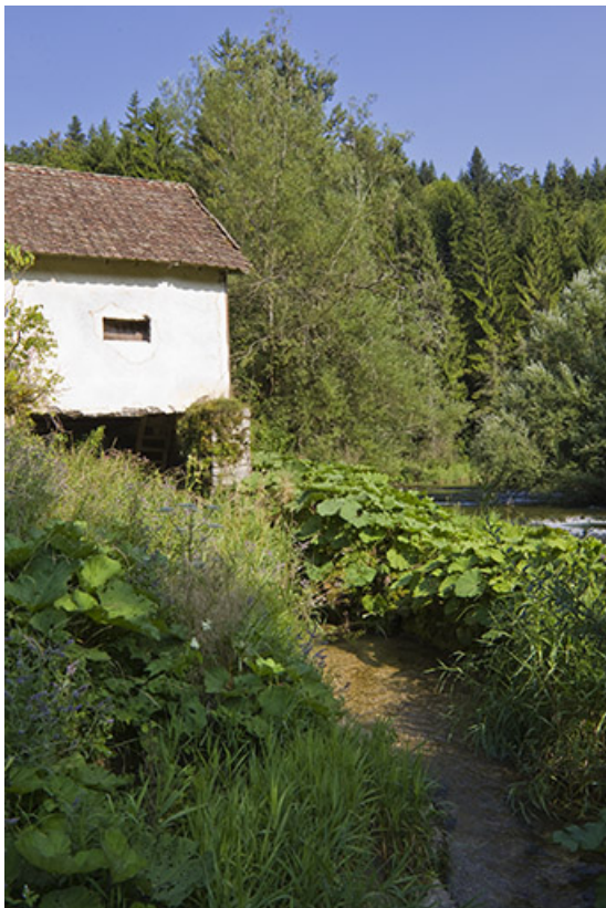
Centrale : extrémité sud de la façade postérieure et canal de fuite.
