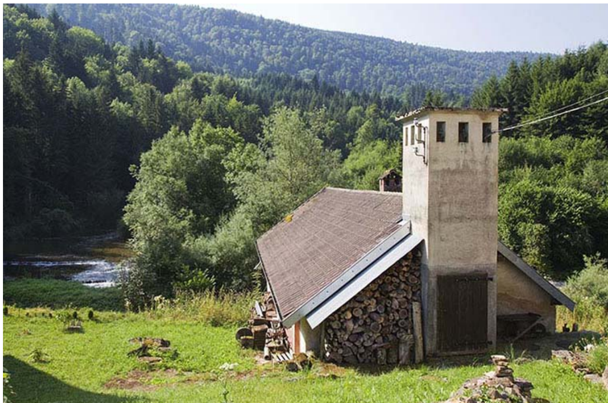
Centrale : façade latérale droite et transformateur.
