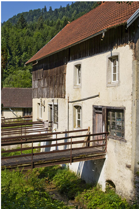
Scierie : façade postérieure, de trois quarts droite, et passerelles.
