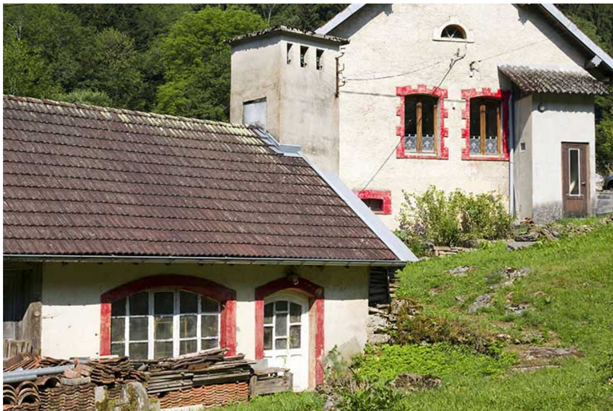
Centrale : extrémité nord de la façade antérieure, avec le logement d'ouvriers en arrière-plan. 25, Battenans-Varin, 2 et 4 rue du Pont, lieudit : Varin
