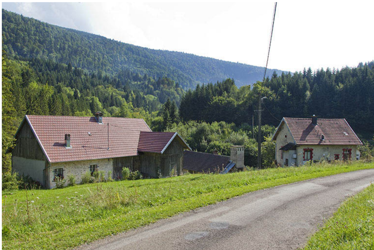
Vue d'ensemble du site, depuis le nord. De gauche à droite : scierie, centrale et logement d'ouvriers. 25, Battenans-Varin, 2 et 4 rue du Pont, lieudit : Varin
