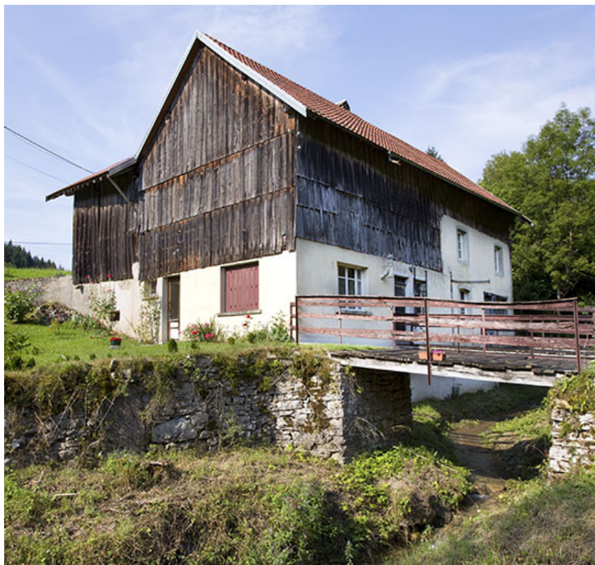
Scierie : façades postérieure et latérale droite.
