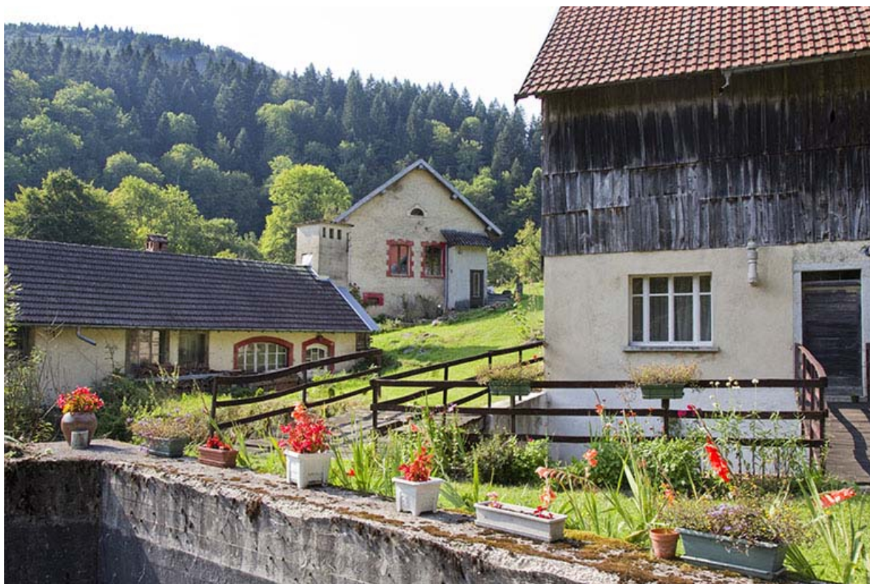
Scierie, façade postérieure : extrémité ouest et passerelles. A l'arrière-plan, centrale (à gauche) et logement d'ouvriers. 25, Battenans-Varin, 2 et 4 rue du Pont, lieudit : Varin
