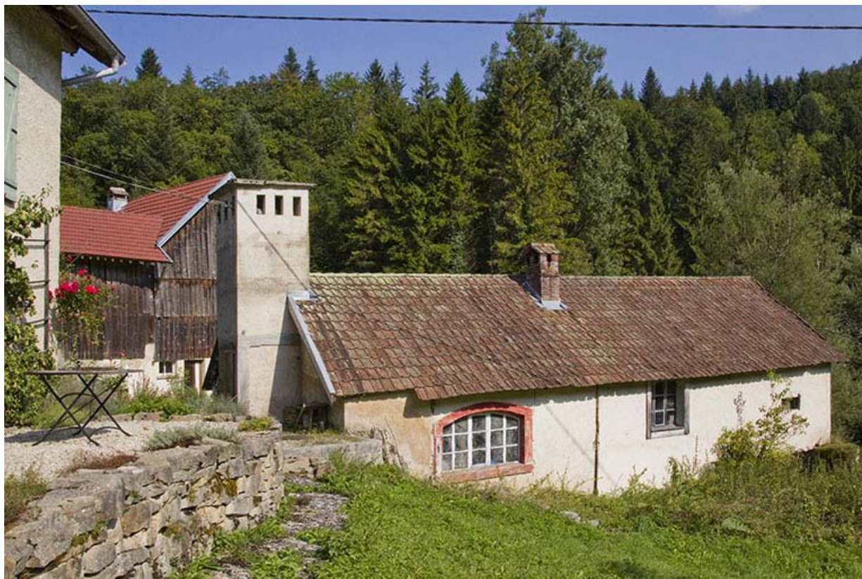
Centrale : façade postérieure, de trois quarts gauche.
