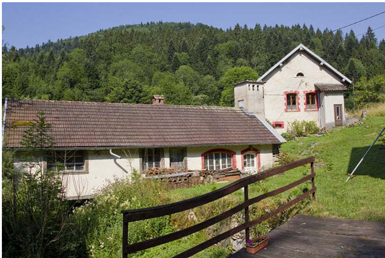
Centrale : façade antérieure, depuis une passerelle. Logement d'ouvriers à l'arrière-plan. 25, Battenans-Varin, 2 et 4 rue du Pont, lieudit : Varin
