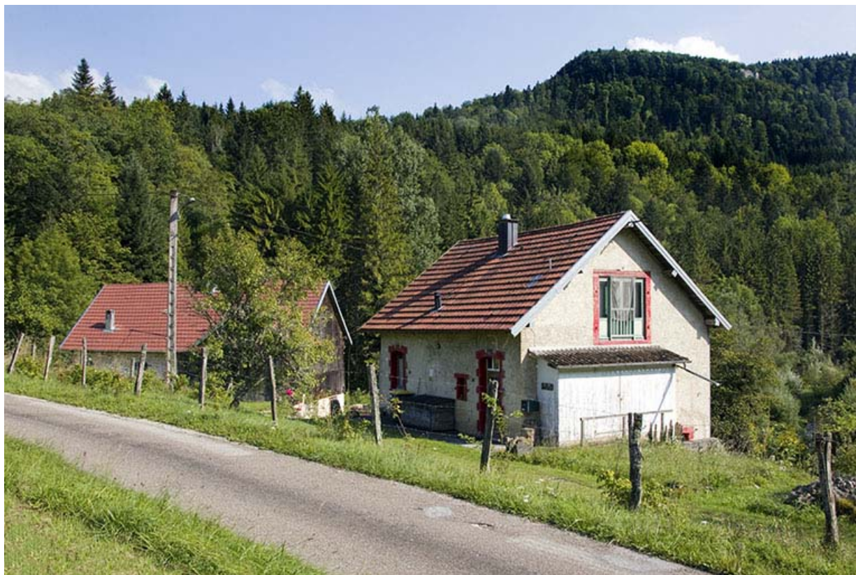
Vue d'ensemble du site, depuis l'ouest. Au premier plan, le logement d'ouvriers.
