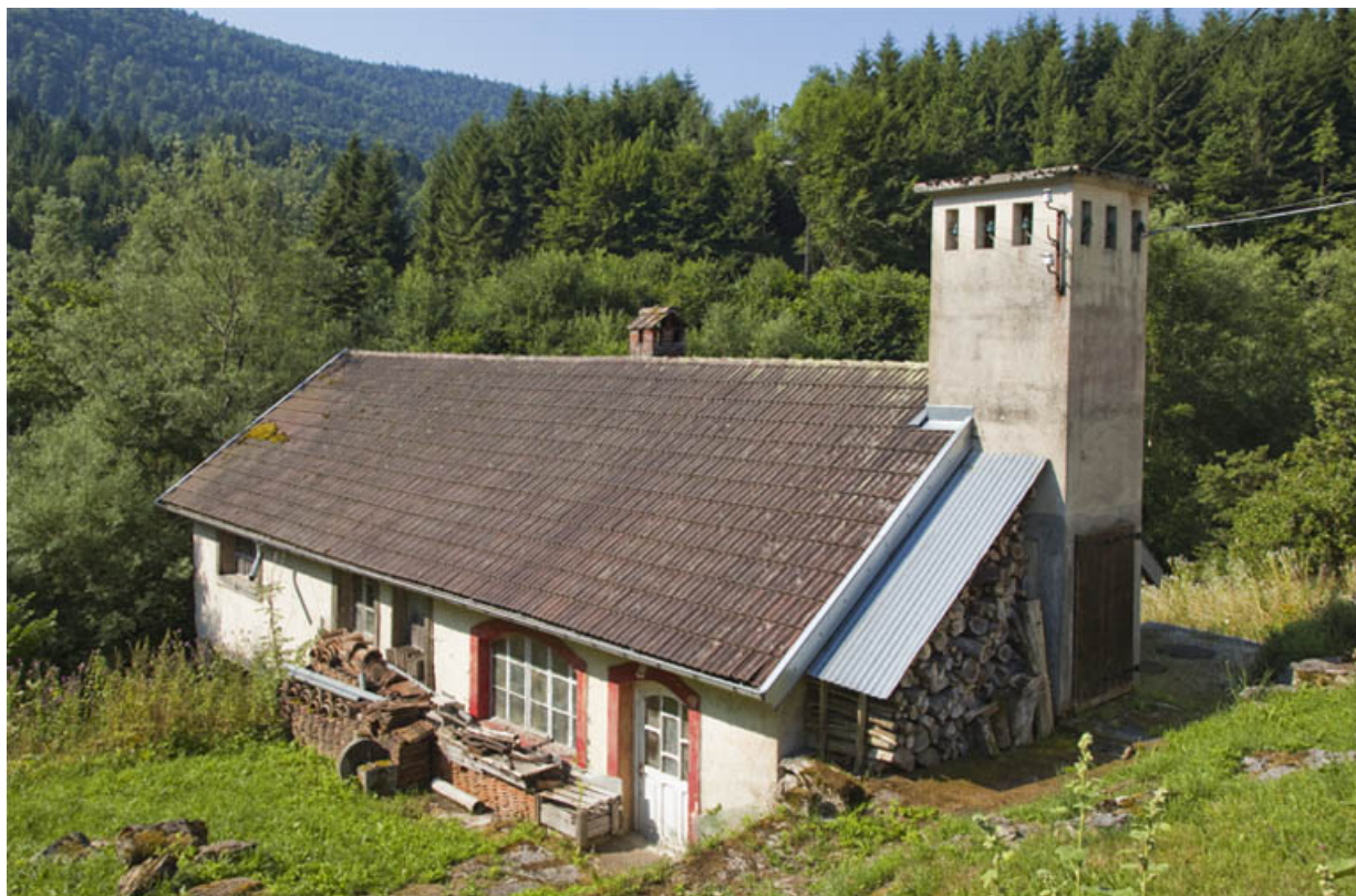
Centrale : façades antérieure et latérale droite, avec le transformateur.
