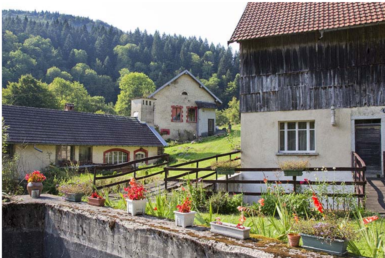
Scierie, façade postérieure : extrémité ouest et passerelles. A l'arrière-plan, centrale (à gauche) et logement d'ouvriers. 25, Battenans-Varin, 2 et 4 rue du Pont, lieudit : Varin
