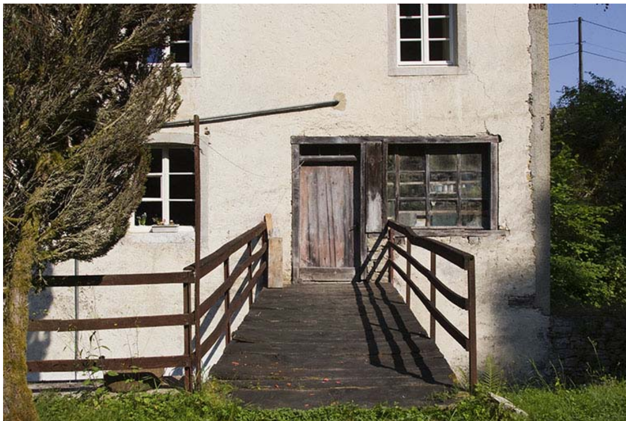
Scierie, façade postérieure : passerelle donnant accès à la pièce sous le logement.
