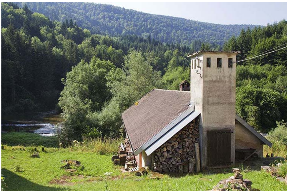
Centrale : façade latérale droite et transformateur.
