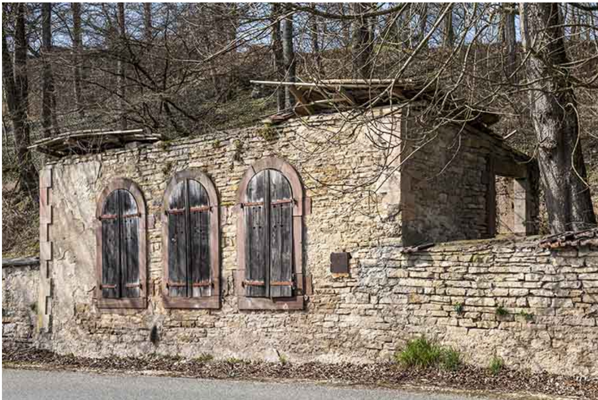
Vestiges du local de la machine élévatoire du château d'eau.
