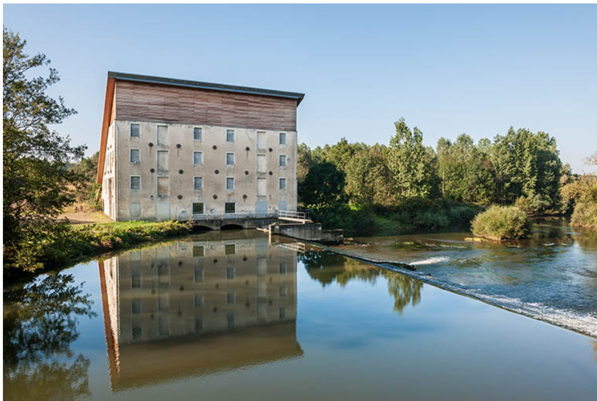
Vue d'ensemble depuis le pont.
