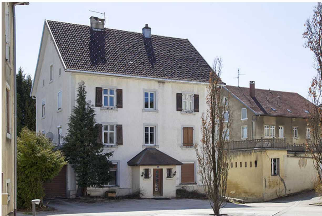
Façade antérieure, de trois quarts gauche. 25, Charquemont, 12 place de l' Hôtel de Ville
