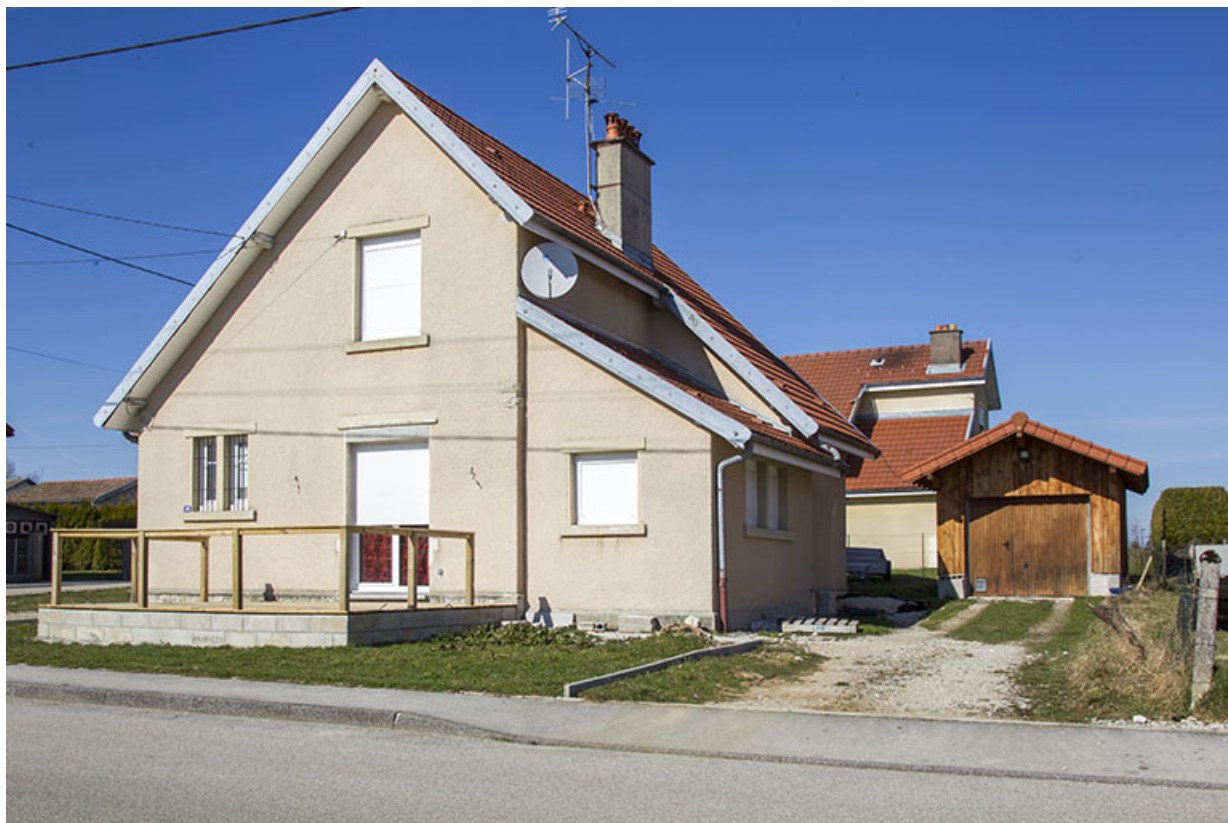
Vue d'ensemble, depuis le sud (façades antérieure et latérale droite). 25, Charquemont, 20 rue des Cités
