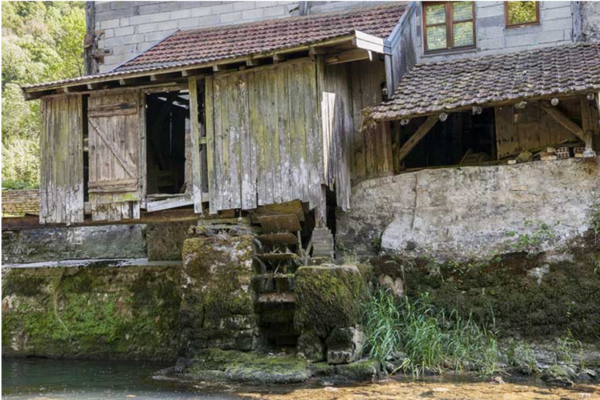
Façade nord. Le bâtiment d'eau.
