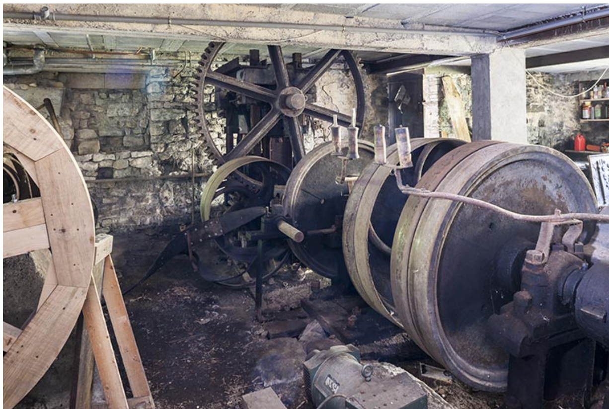
Système d'entraînement des martinets (volants de transmission et d'inertie). 25, Guillon-les-Bains, 4 rue de la Taillanderie
