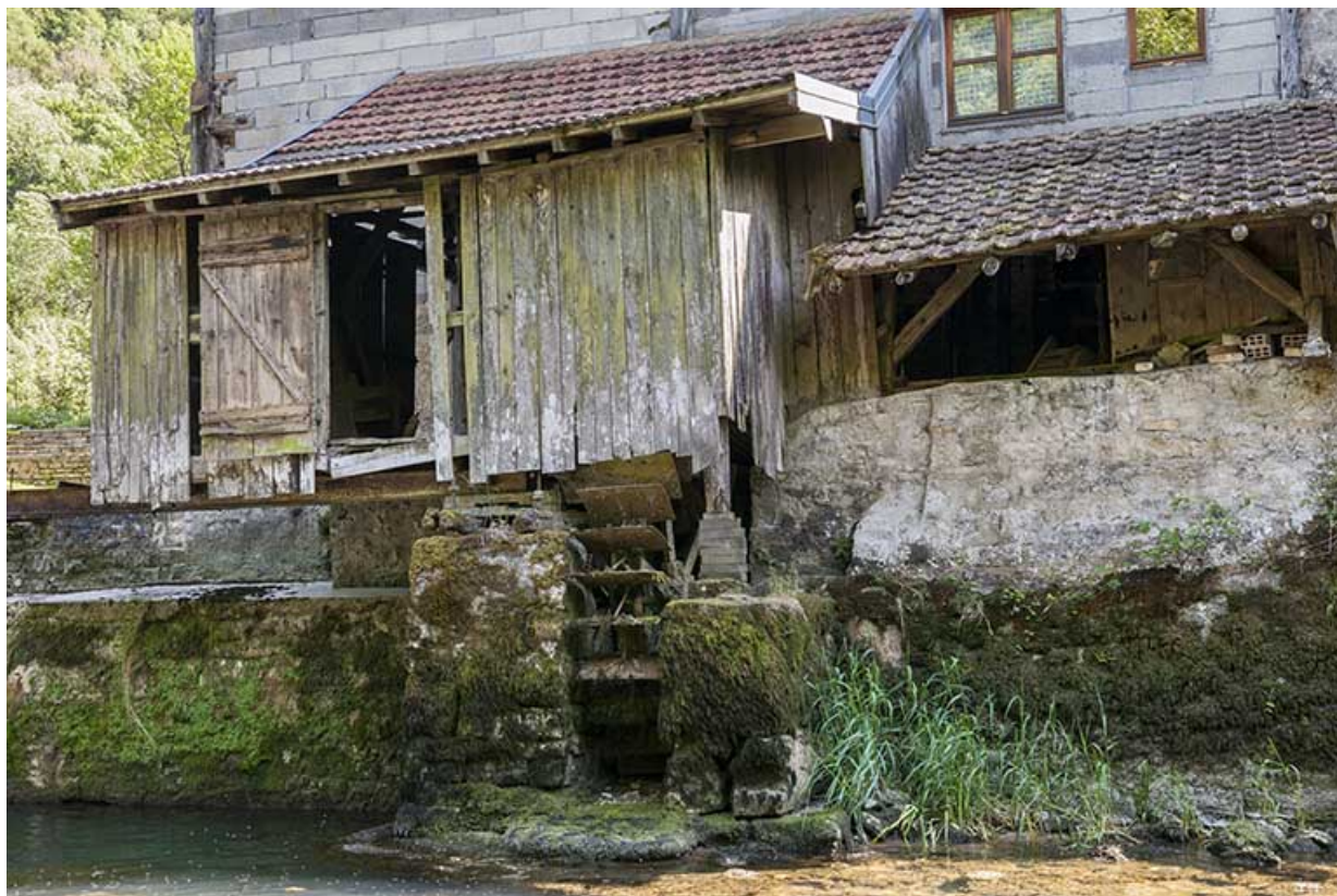
Façade nord. Le bâtiment d'eau.
