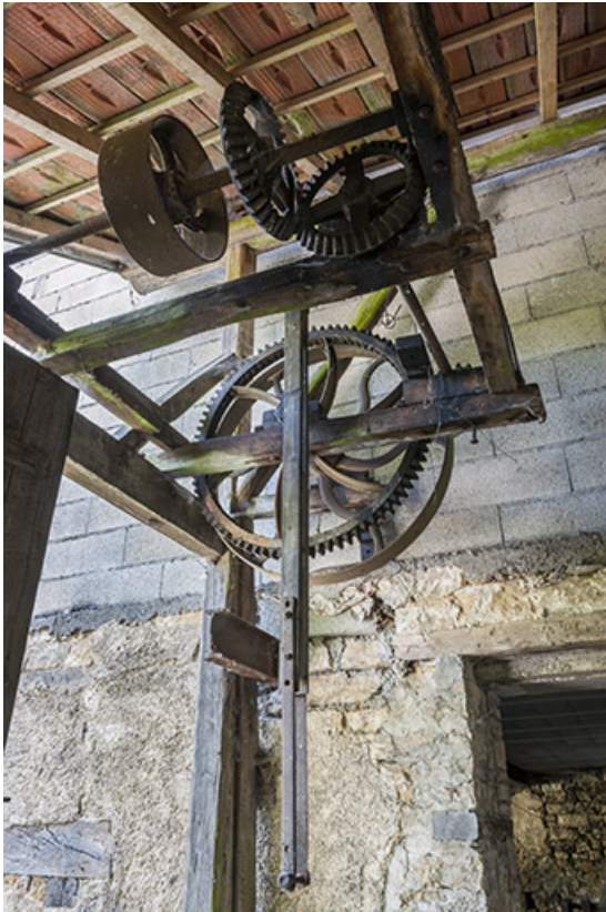
Bâtiment d'eau. Système de transmission des soufflets de la forge (disparus). 25, Guillon-les-Bains, 4 rue de la Taillanderie
