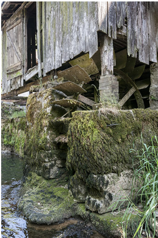
Bâtiment d'eau. Roue en dessous.
