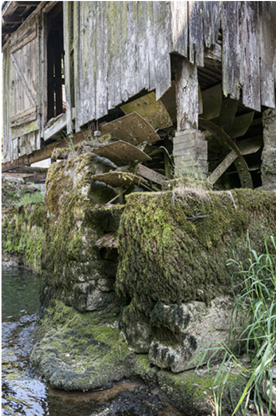
Bâtiment d'eau. Roue en dessous.
