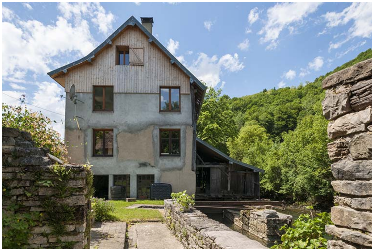
Pignon est (atelier de taillanderie à l'étage de soubassement).
