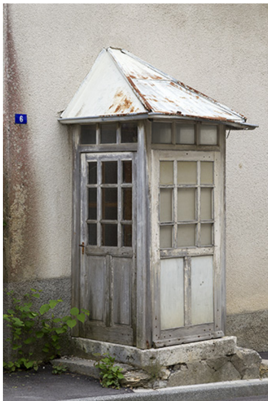
Façade antérieure : véranda.
