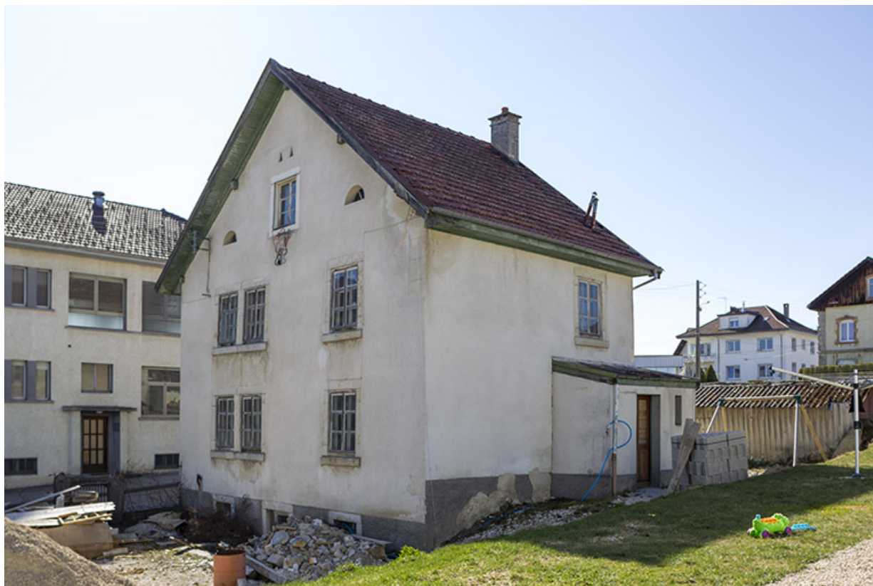
Façades postérieure et latérale droite.
