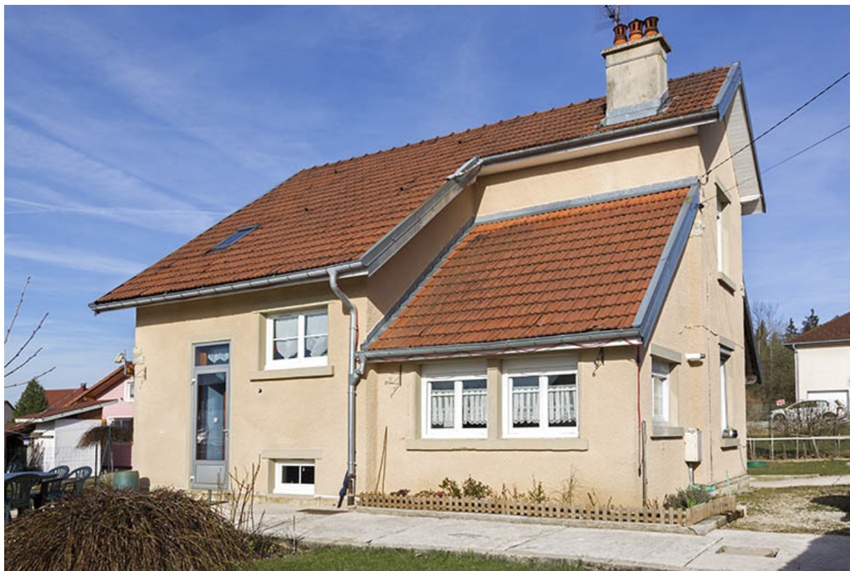
Façades antérieure (pignon) et latérale gauche.
