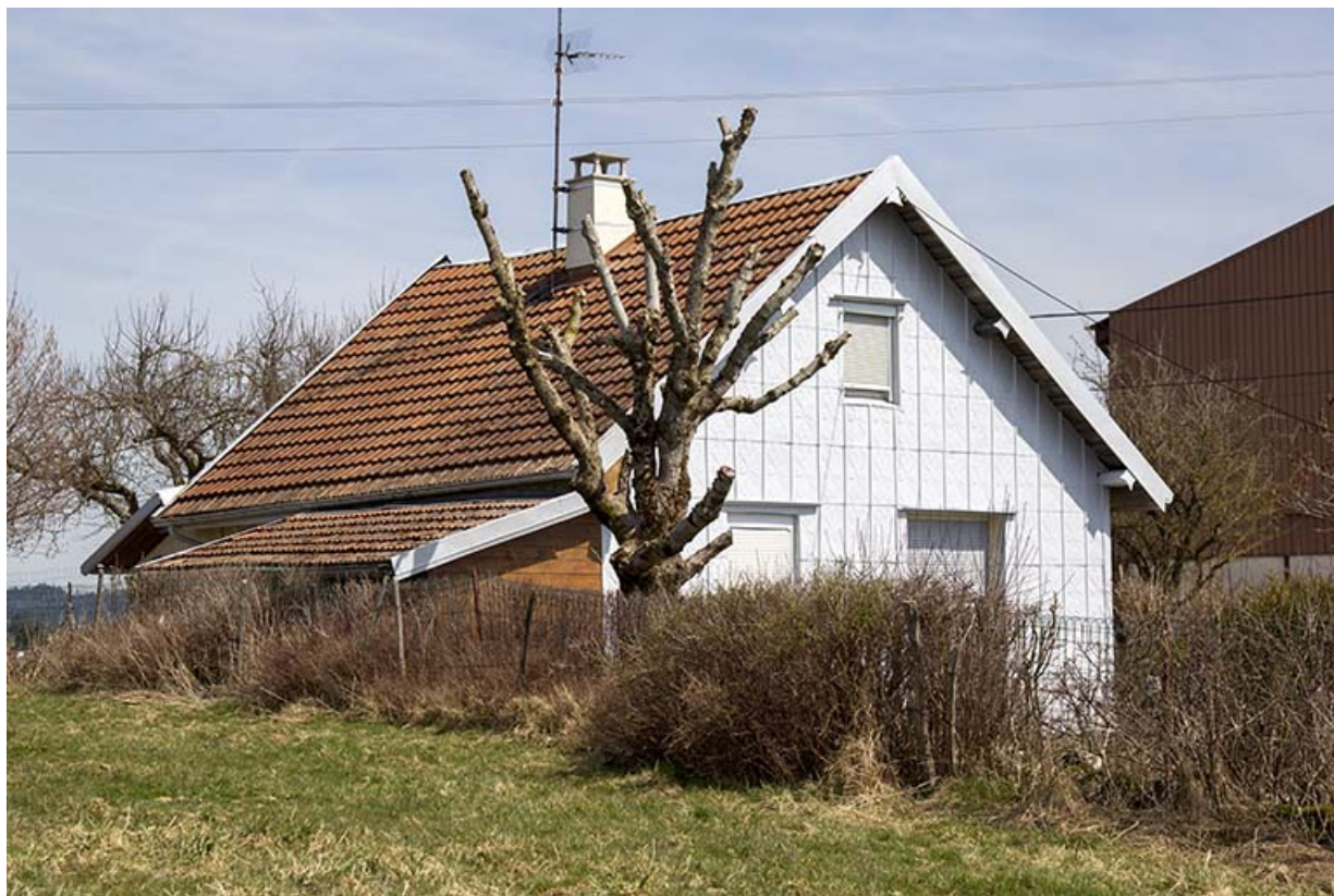
Façades postérieure et latérale gauche.
