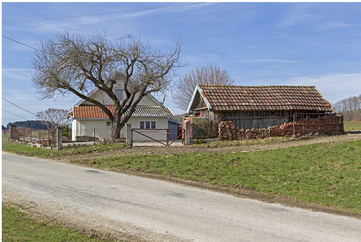
Vue d'ensemble, depuis le nord (façade latérale droite). 25, Charquemont rue du Crôt
