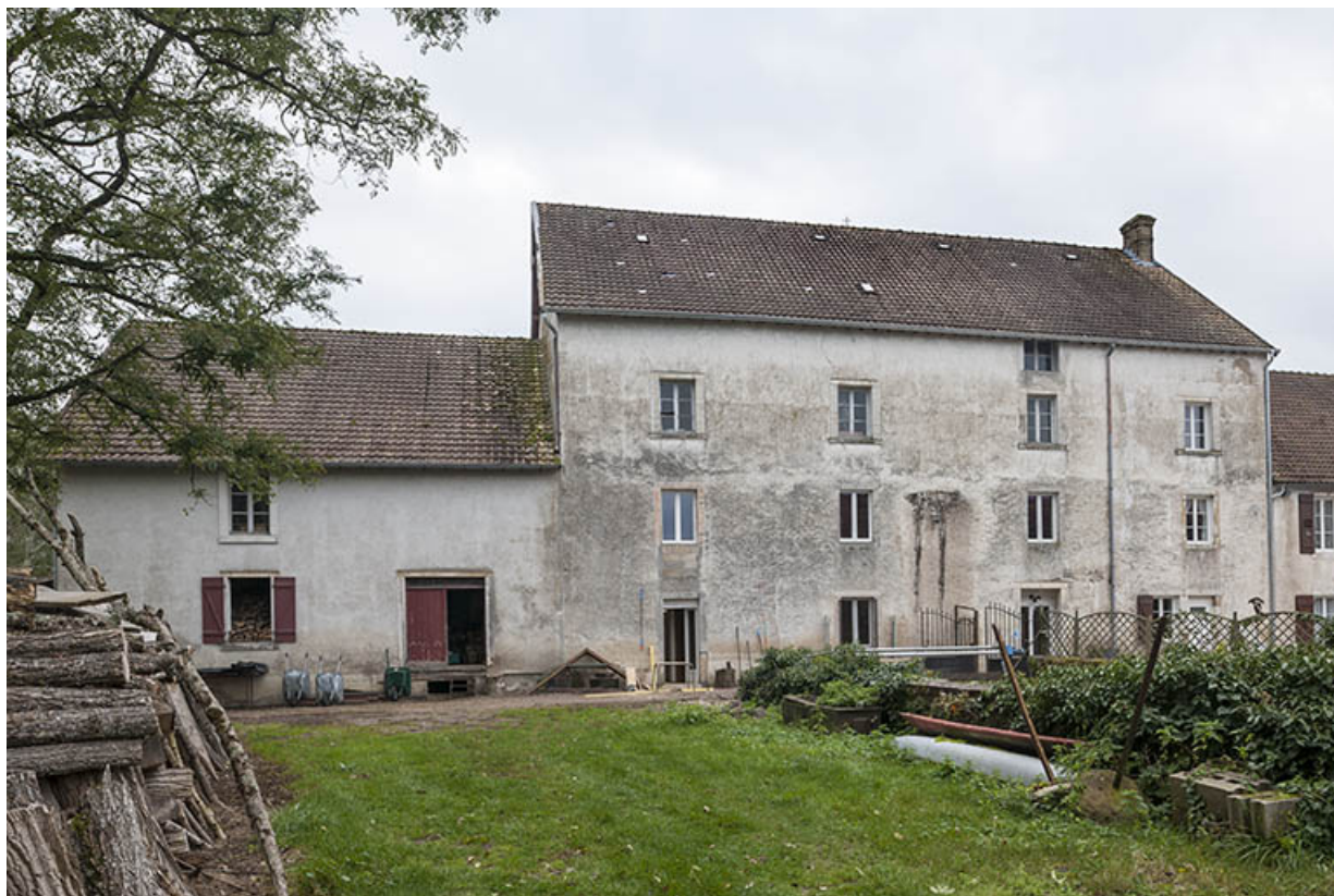
Façade ouest de l'atelier de minoterie.
