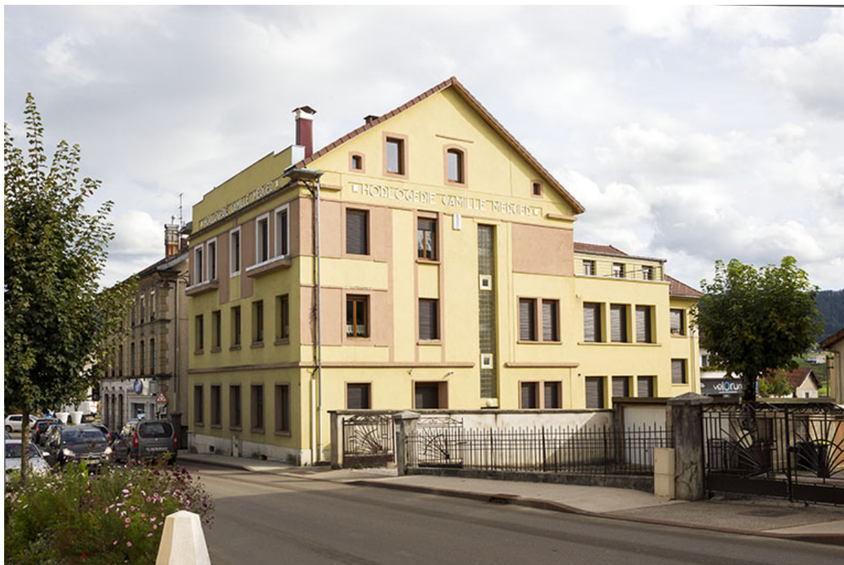
Vue d'ensemble, depuis l'ouest (immeuble et extension). 25, Morteau
