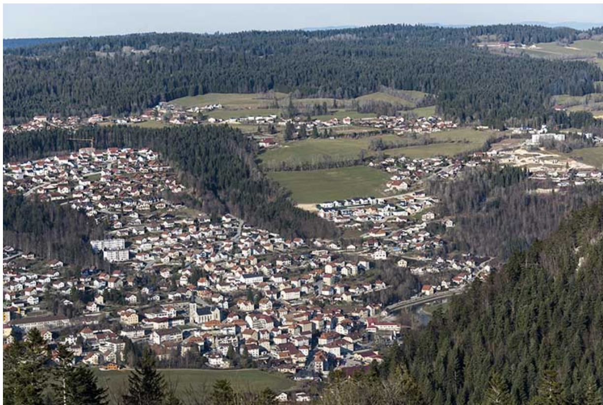
Vue d'ensemble de Villers-le-Lac, depuis le Meix Musy au sud. Le centre-ville et le Quartier neuf sont au centre de l'image. 25, Villers-le-Lac
