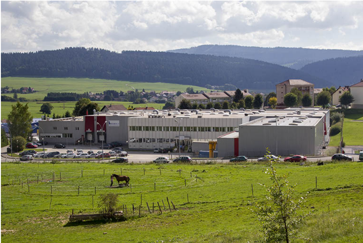
Fonderie et usine de pièces détachées en matière plastique Bourbon, à Morteau. 25, Morteau, 13 rue du Maréchal Leclerc
