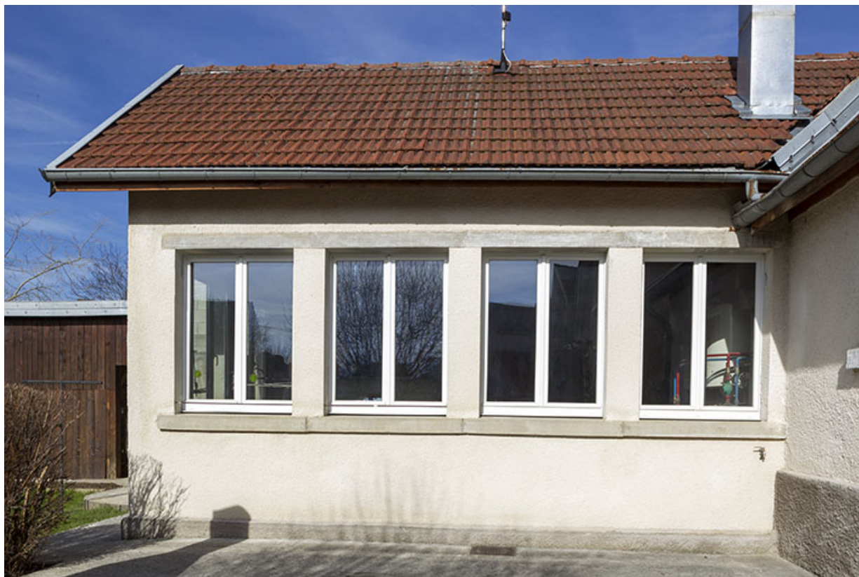
Atelier de fabrication : baies multiples à l'est. 25, Charquemont, 19 rue des Cités
