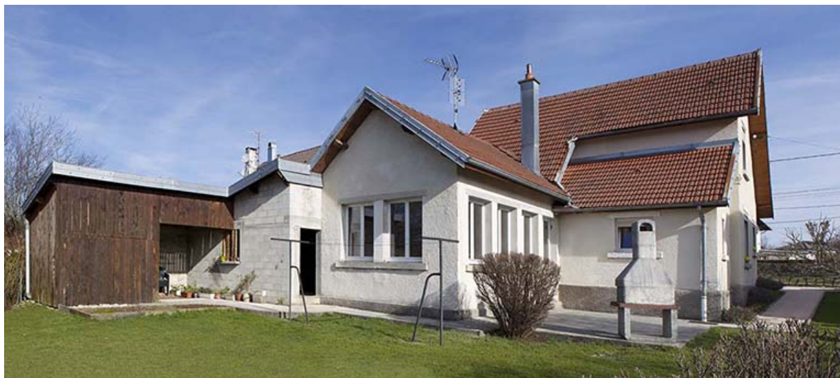
Vue d'ensemble, depuis le sud (bûcher, garage, atelier et façade postérieure de la maison). 25, Charquemont, 19 rue des Cités
