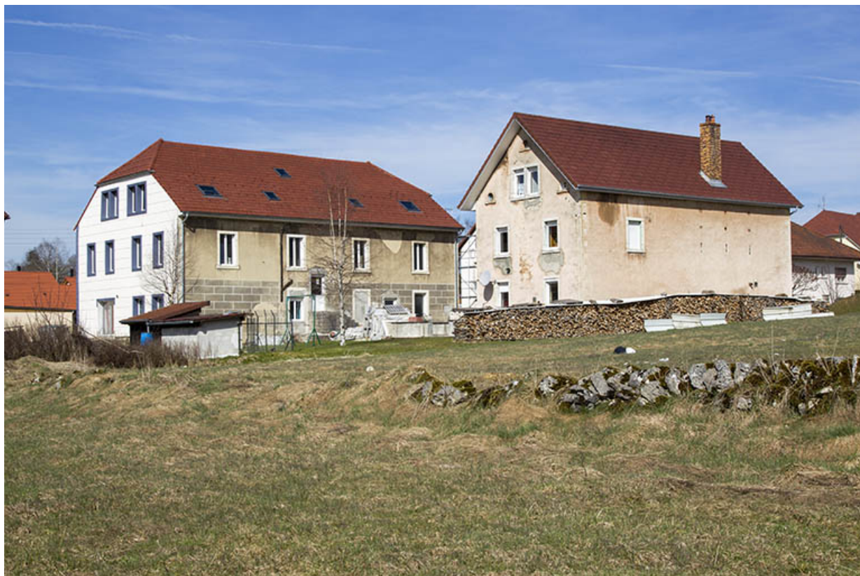
Vue d'ensemble, depuis le sud-est (façades postérieures et latérales droites). 25, Charquemont, 39 et 41 Grande Rue
