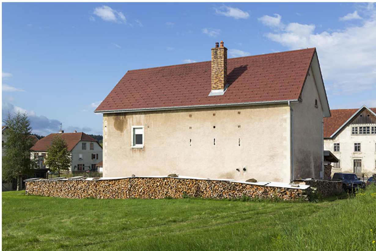
Bâtiment au n° 39 : façades postérieure et latérale gauche.
