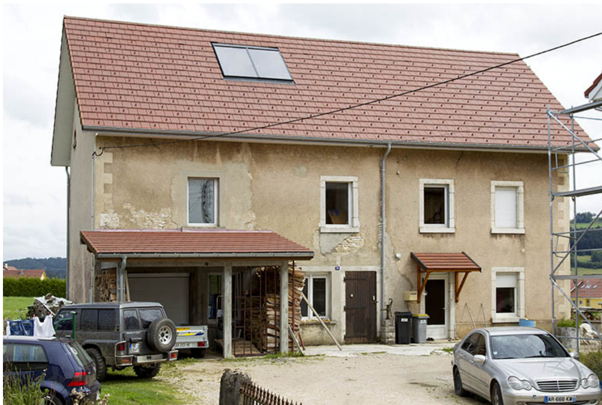
Bâtiment au n° 39 : façade antérieure.
