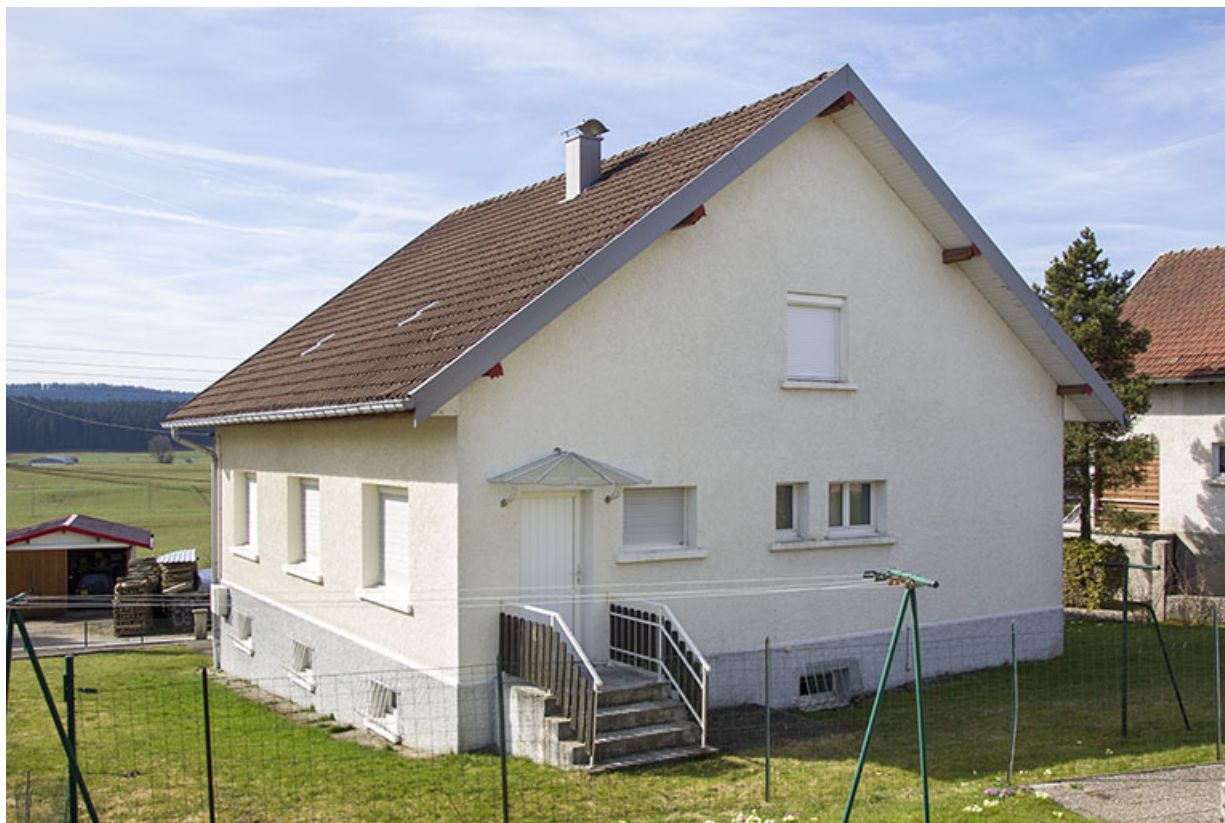
Façades postérieure et latérale droite.
