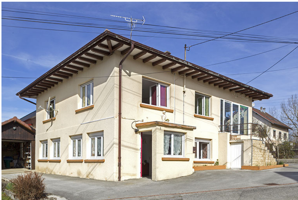
Une maison des "Castors" de 1955 : atelier de fournitures pour l'horlogerie d'Alexis Schroter (1 rue Guynemer). 25, Charquemont
