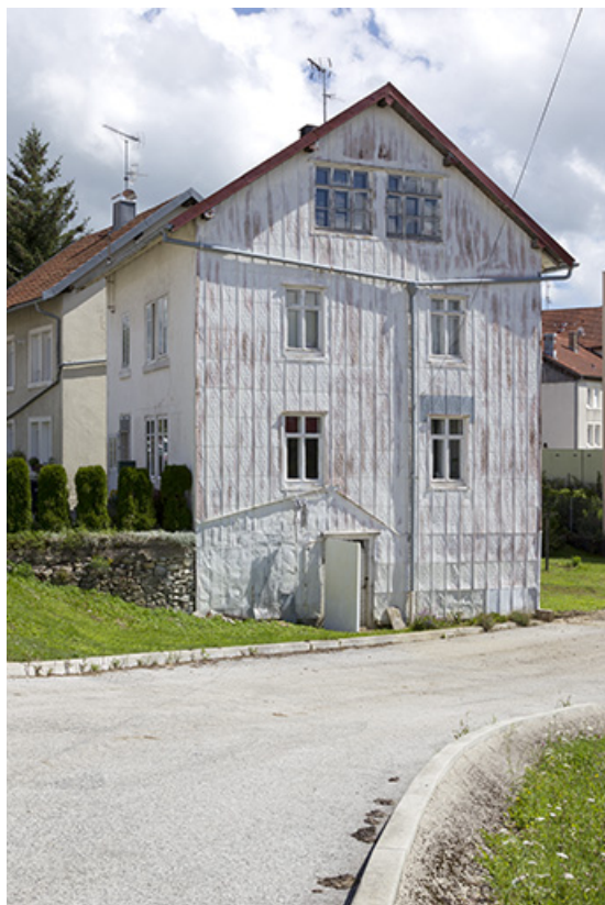
Façade latérale droite, de trois quarts gauche.
