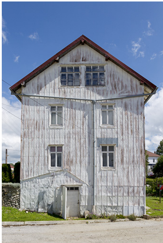
Façade latérale droite.
