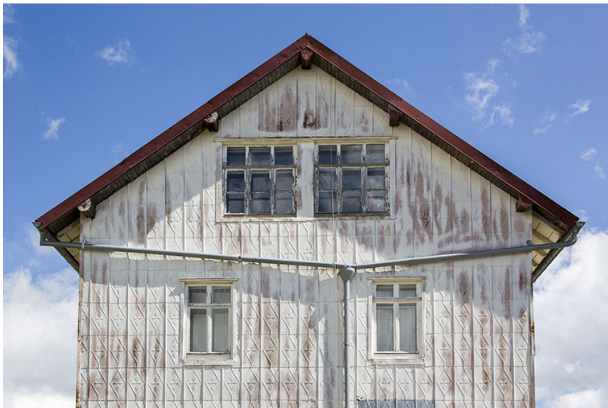
Façade latérale droite : fenêtres des niveaux supérieurs.
