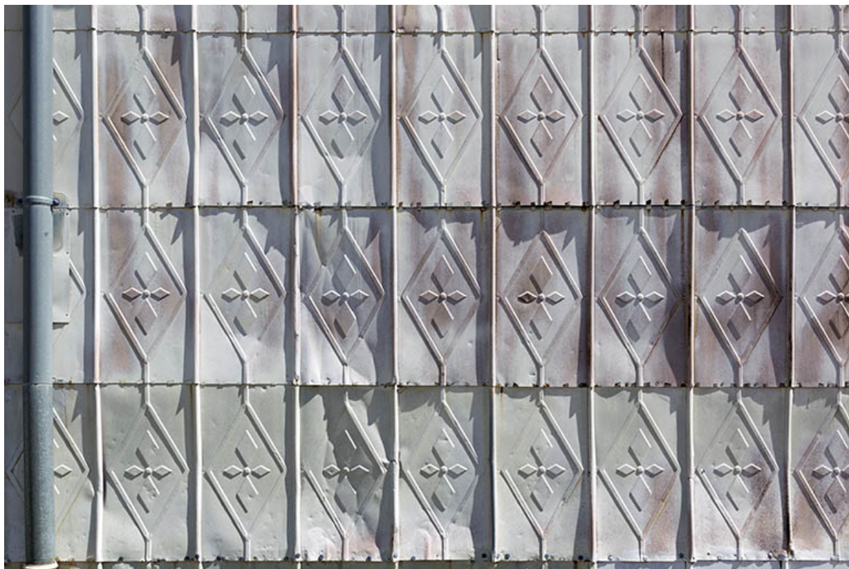
Façade latérale droite : essentage de tôle. 25, Charquemont, 5 rue de la Gare
