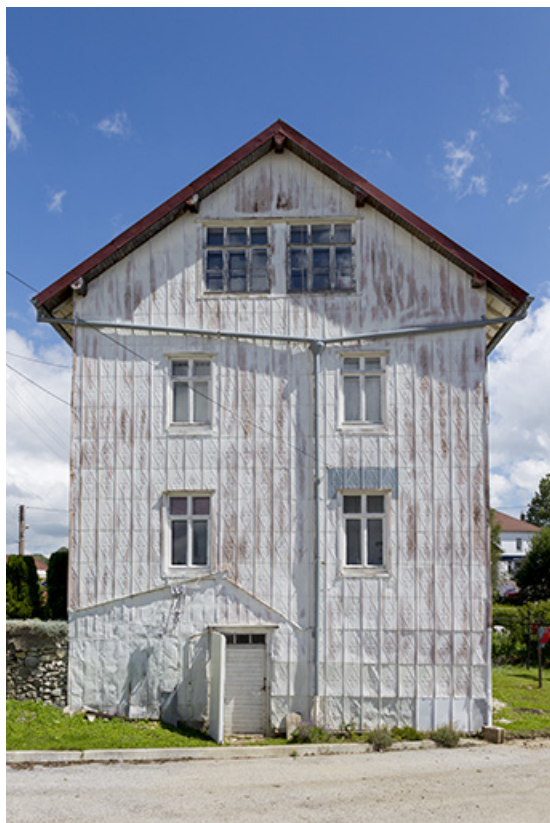
Façade latérale droite.
