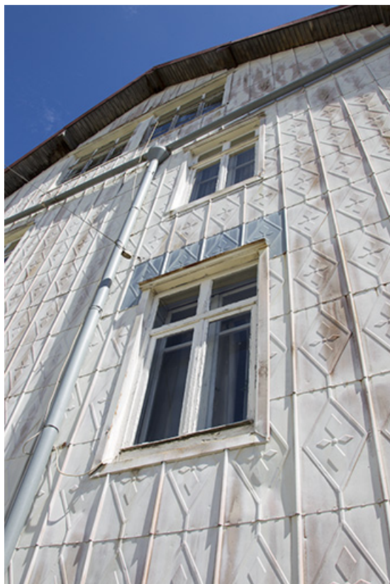
Façade latérale droite : fenêtres vues en contre-plongée. 25, Charquemont, 5 rue de la Gare
