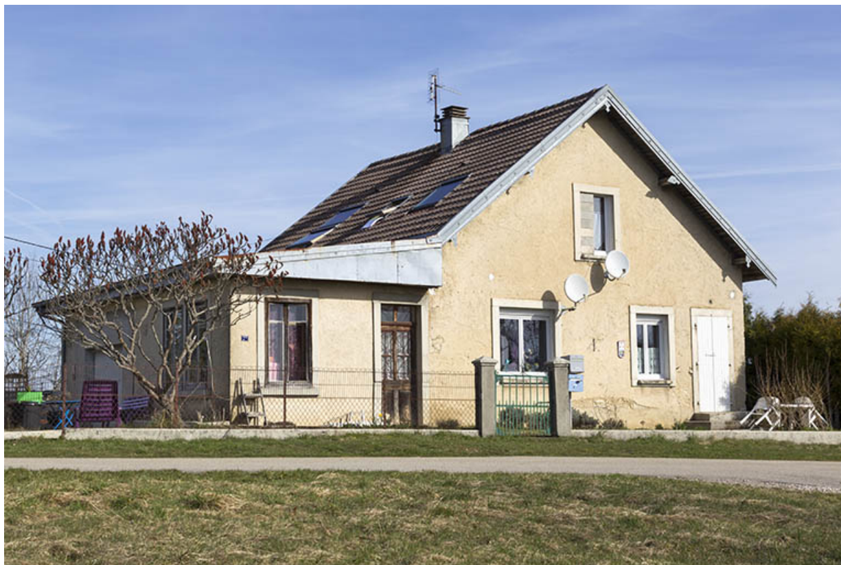
Vue d'ensemble, depuis le sud (façade antérieure, de trois quarts gauche).
