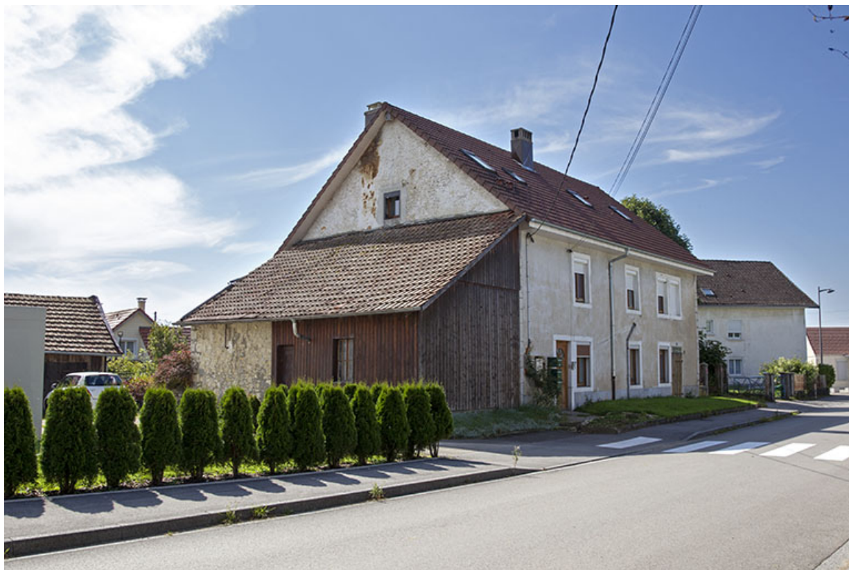
Vue d'ensemble, depuis le nord (façades antérieure et latérale gauche). 25, Charquemont, 10 rue de l' Eglise
