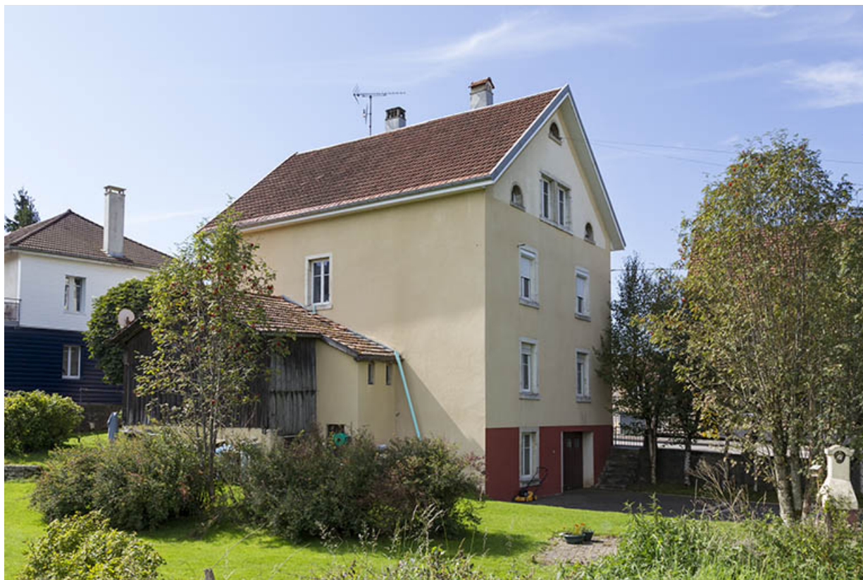
Vue d'ensemble, depuis le nord (façades postérieure et latérale droite). 25, Charquemont, 3 Grande Rue
