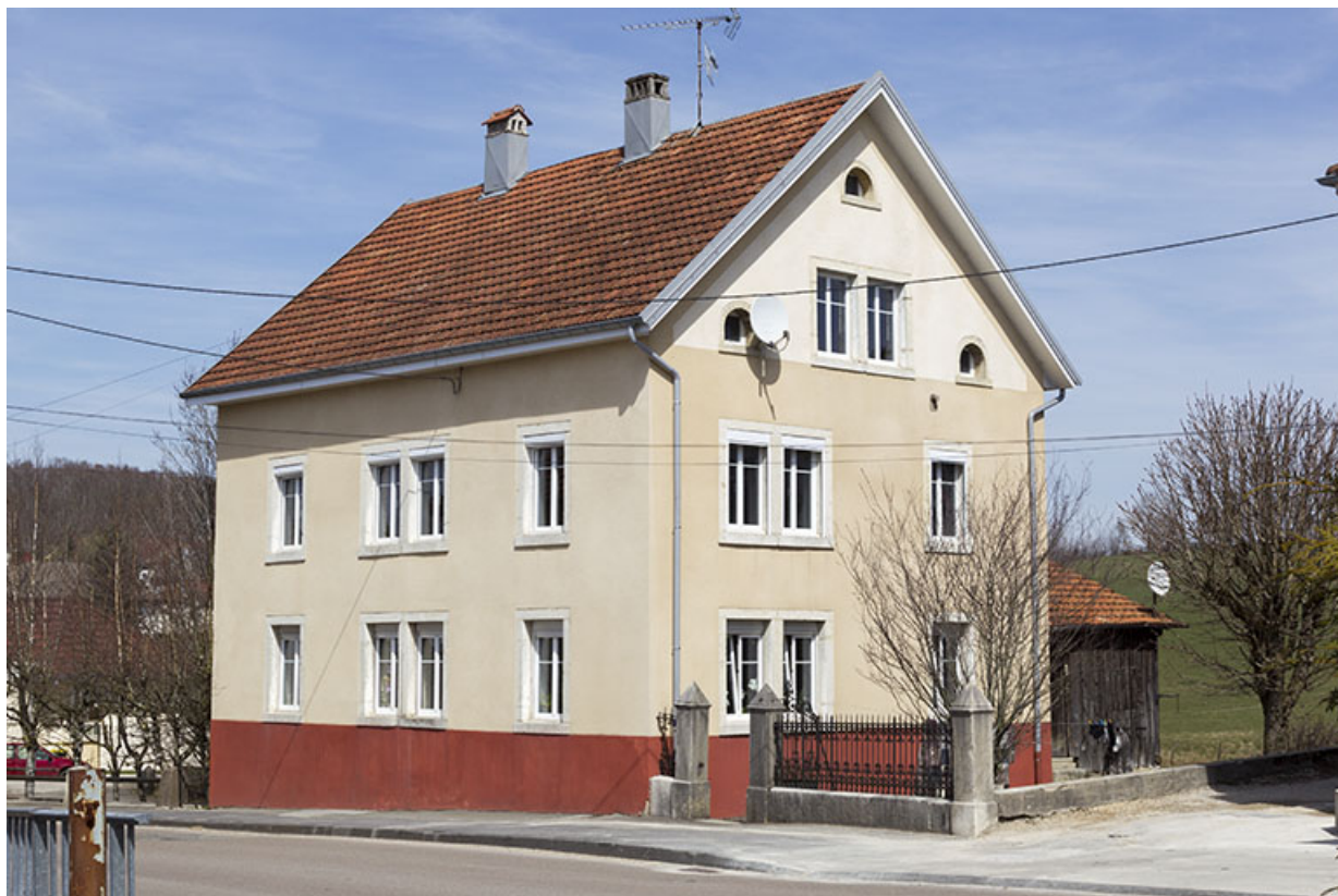
Vue d'ensemble, depuis le sud (façades antérieure et latérale gauche). 25, Charquemont, 3 Grande Rue
