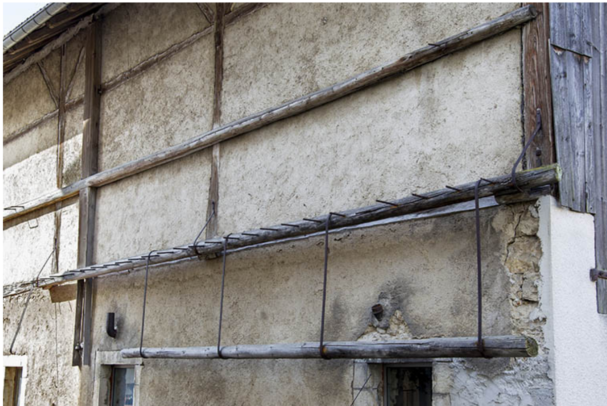
Ecurie : support pour stockage vertical de barres métalliques, sur la façade antérieure. 25, Charquemont, 50 et 52 Grande Rue
