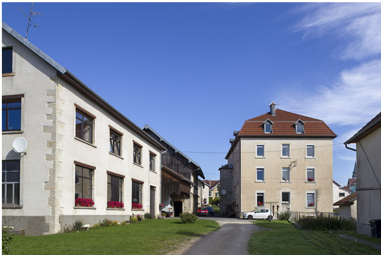
Logement patronal : façade latérale gauche. A gauche, l'ancienne fonderie se prolongeant par la remise et l'écurie-fenil. 25, Charquemont, 50 et 52 Grande Rue
