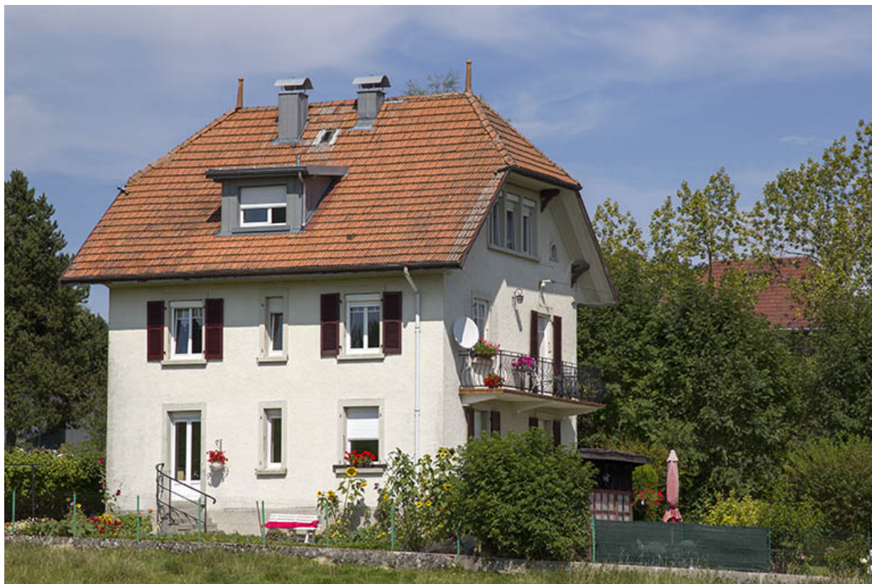
Une maison des années 1920 (vers 1926) et son atelier d'horlogerie : maison Chapuis (16 rue du Château). 25, Charquemont
