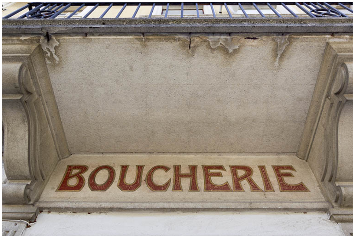
Façade antérieure : partie gauche de l'enseigne peinte.
