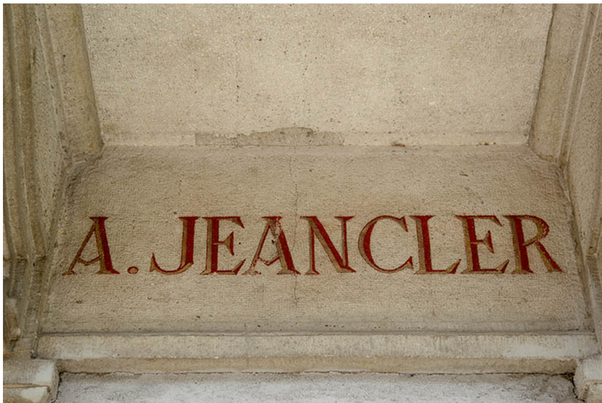
Façade antérieure : partie centrale de l'enseigne peinte.
