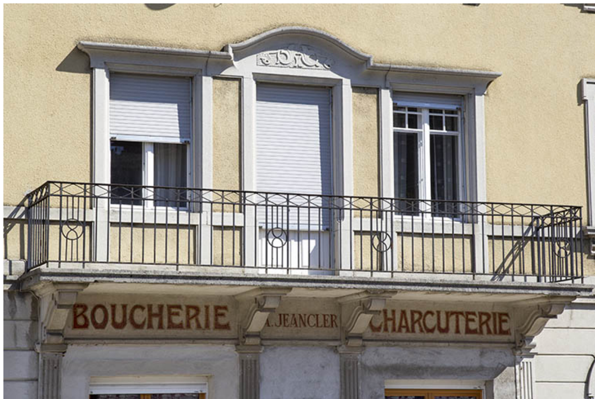
Façade antérieure : baies centrales à l'étage et balcon.
