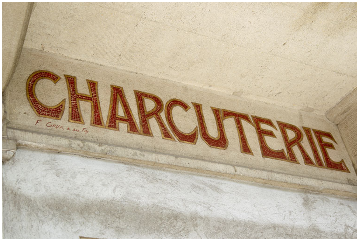
Façade antérieure : partie droite de l'enseigne peinte.
