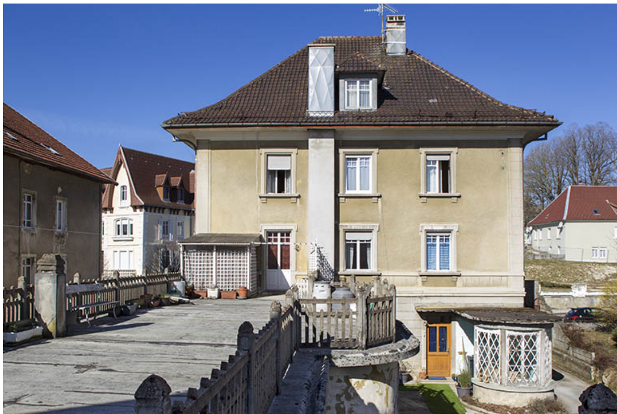
Façade postérieure et terrasse surmontant la cuisine.
