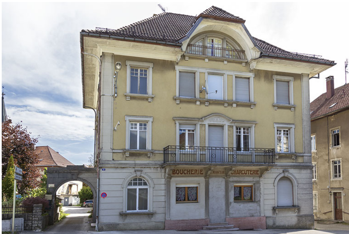
Façade antérieure, de trois quarts gauche. A gauche le portail. 25, Charquemont, 21 Grande Rue
