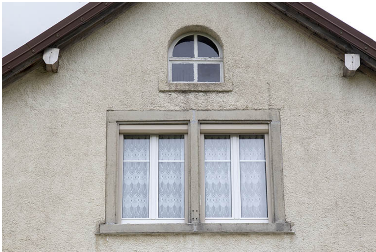
Façade latérale gauche : fenêtre horlogère et fenêtre du comble.
