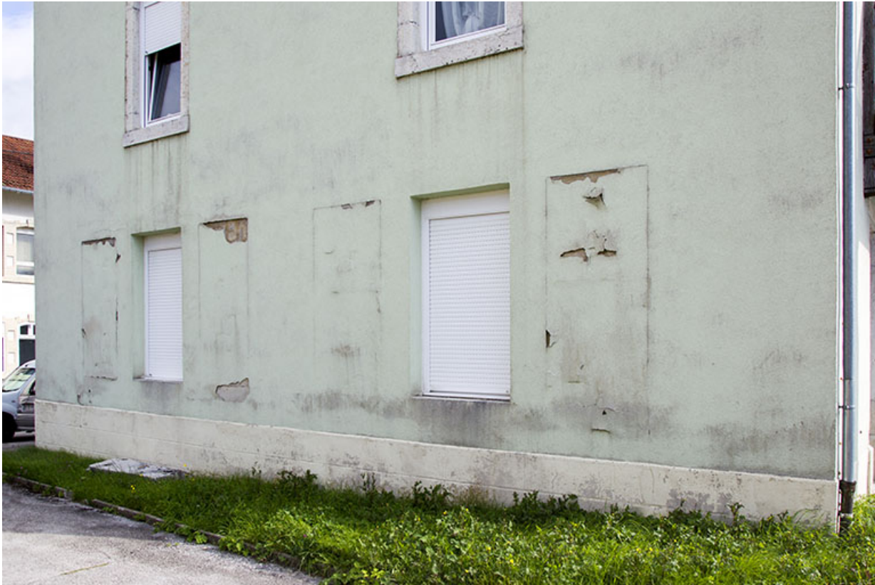
Façade latérale droite : fenêtres multiples encore visibles au rez-de-chaussée. 25, Charquemont rue de l' Eglise
