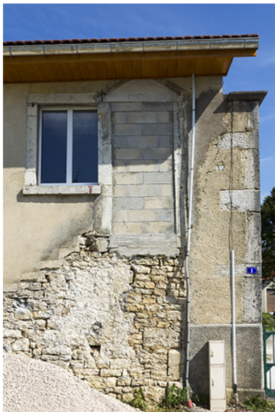
Façade latérale gauche : porte murée à l'étage. 25, Charquemont, 1 rue de la Paix
