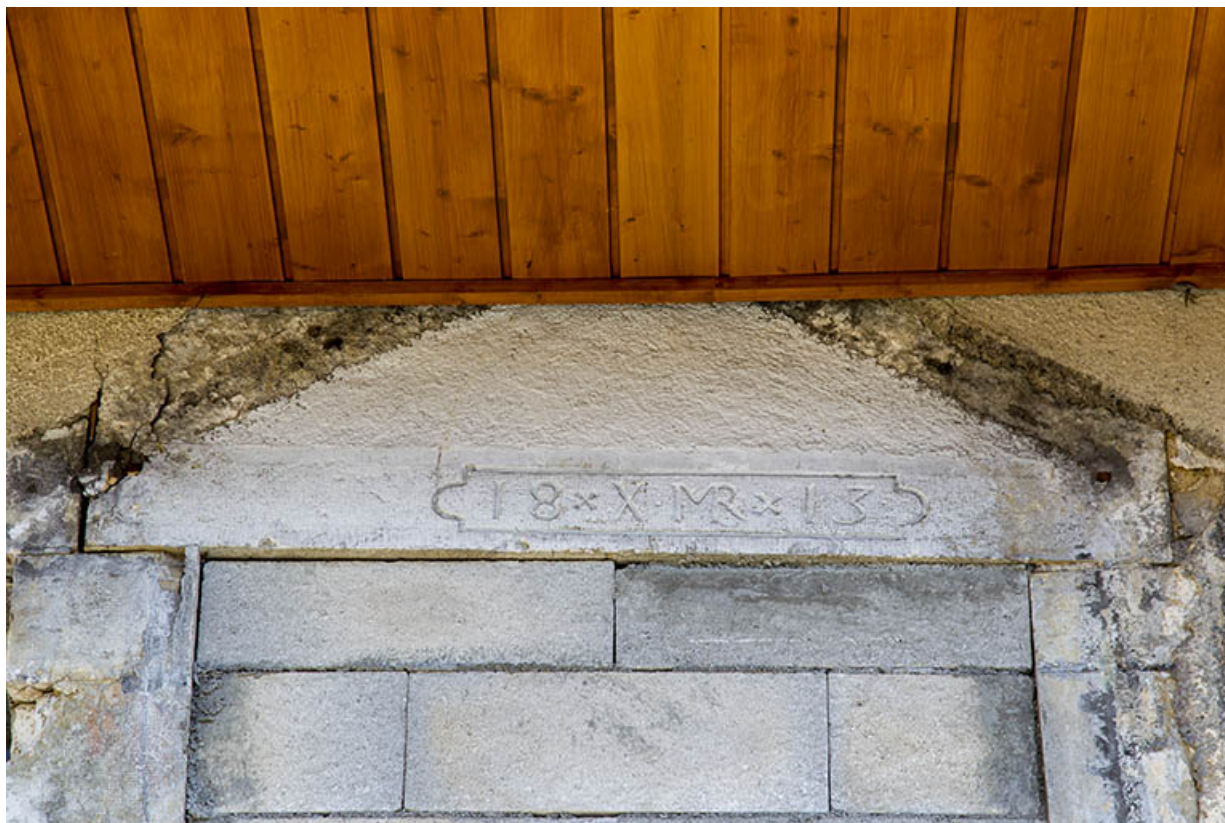
Façade latérale gauche : date et initiales gravées sur le linteau de la porte murée.
