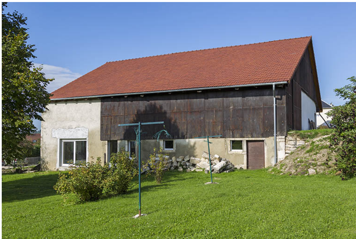
Façade latérale droite, de trois quarts droite.
