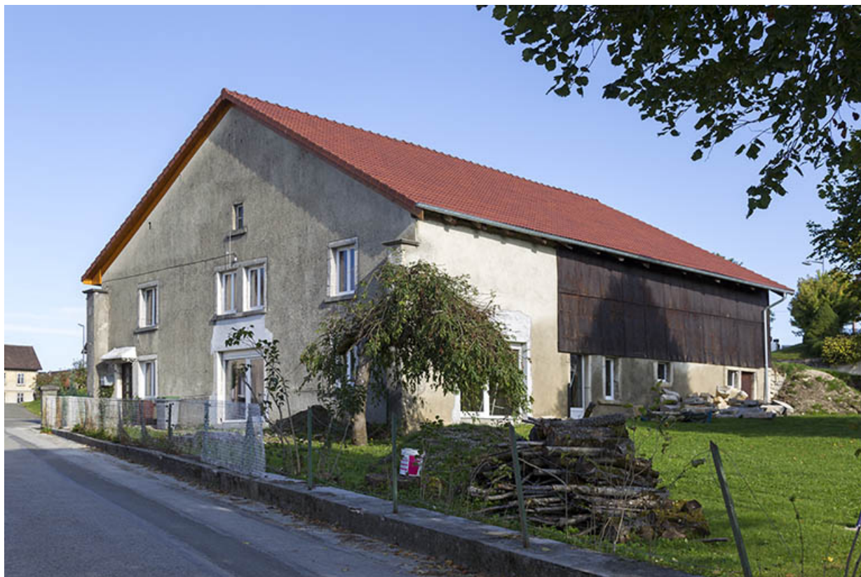
Une ferme horlogère du 19e siècle : l'atelier Guédât puis Vigezzi (1 rue de la Paix). 25, Charquemont
