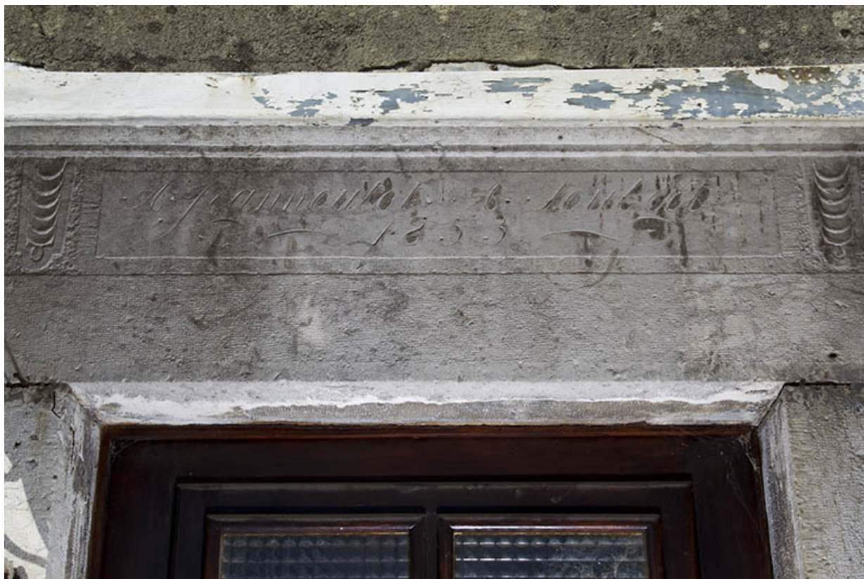
Façade antérieure : date et noms gravés sur le linteau de la porte.
