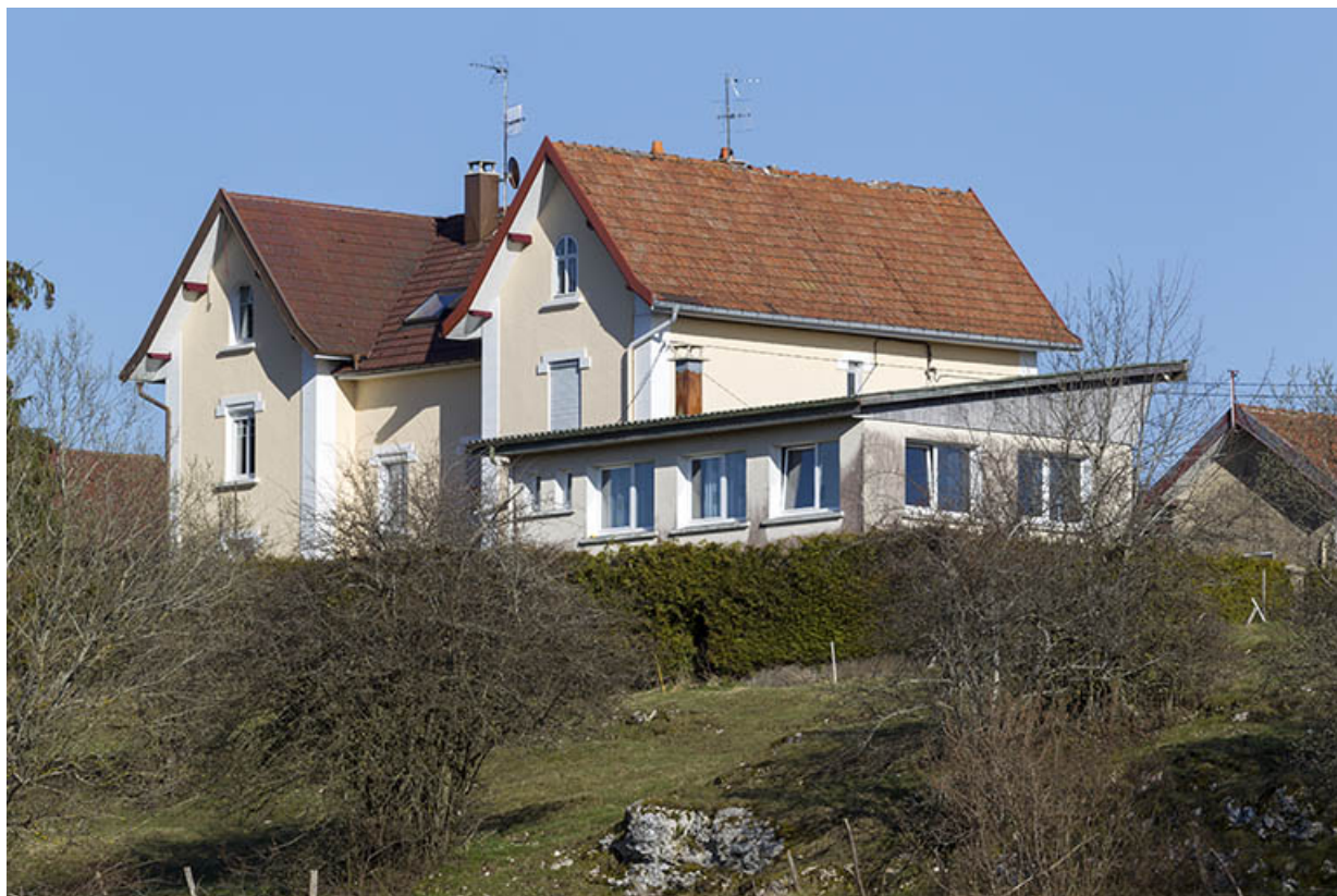
Vue d'ensemble, depuis l'ouest (maison et atelier).
