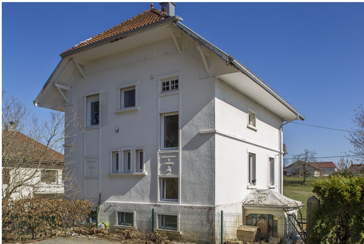
Façades postérieure et latérale gauche.
