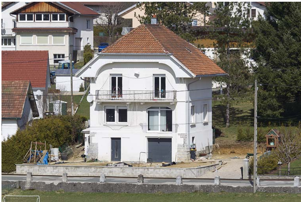
Façades antérieure et latérale droite.
