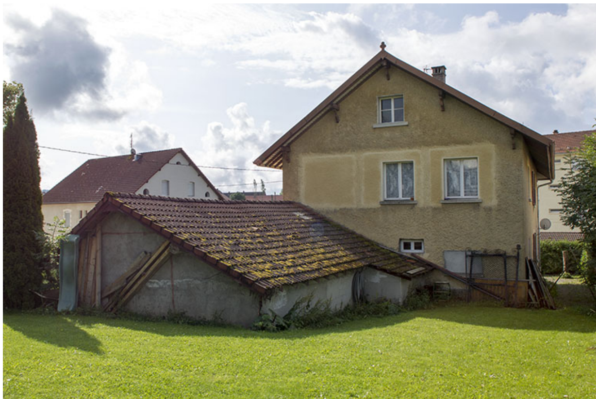
Façade postérieure. Noter les fenêtres d'atelier partiellement murées.
