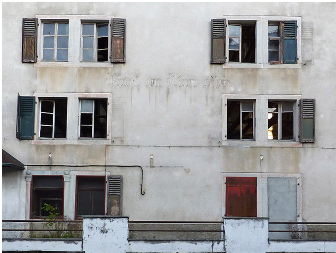
Hôtel, 17 juillet 2012 : baies sur la façade antérieure (est). 25, Charquemont place de l' Hôtel de Ville
