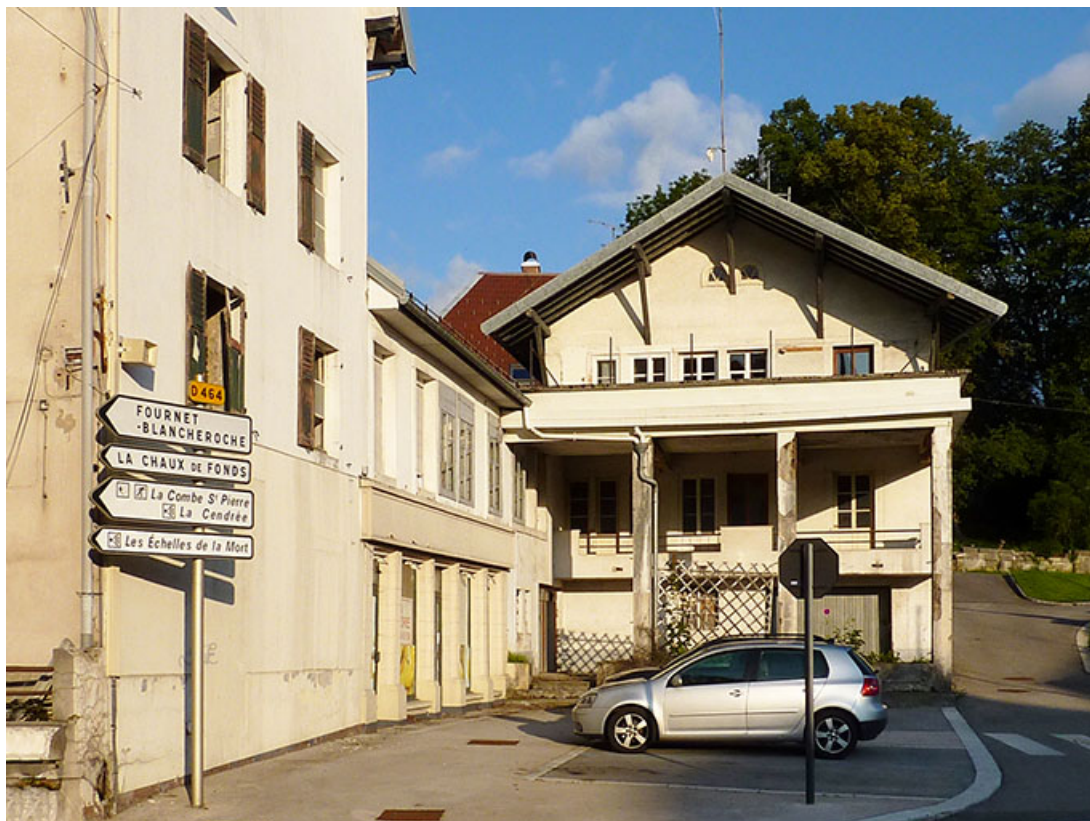
Logement surmontant le garage, 17 juillet 2012. 25, Charquemont place de l' Hôtel de Ville
