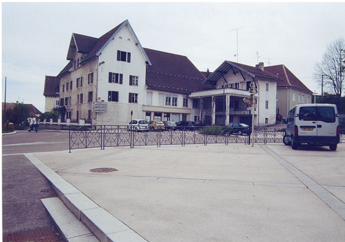
Vue d'ensemble depuis le nord-est, début juin 2012.
