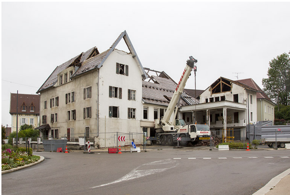
Démontage des toitures, 30 août 2012 : vue d'ensemble depuis le nord-est. 25, Charquemont place de l' Hôtel de Ville
