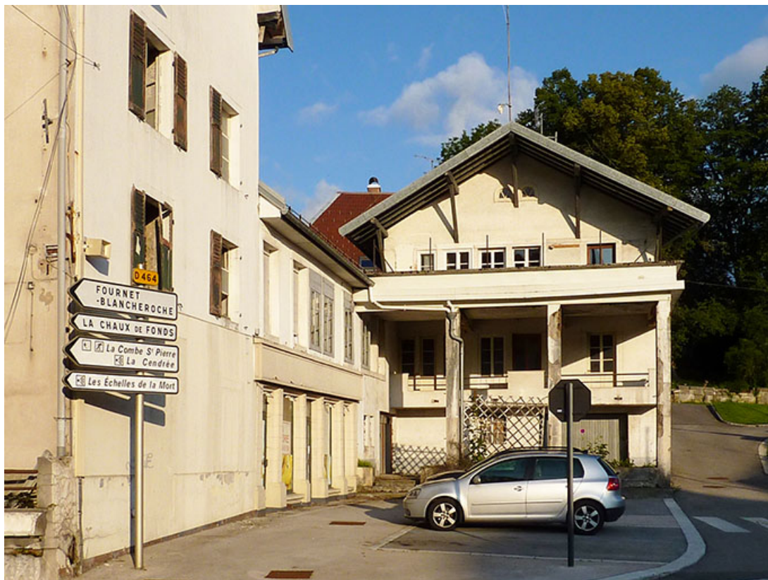
Logement surmontant le garage, 17 juillet 2012. 25, Charquemont place de l' Hôtel de Ville
