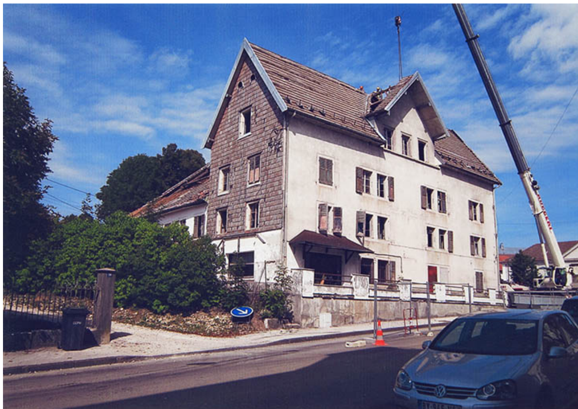
Démontage des toitures, 30 août 2012 : vue d'ensemble depuis le sud-est. 25, Charquemont place de l' Hôtel de Ville
