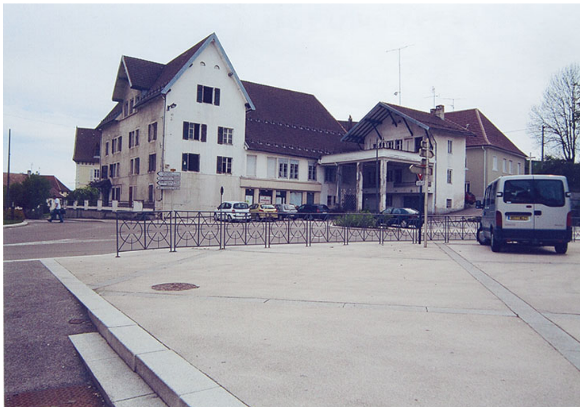
Vue d'ensemble depuis le nord-est, début juin 2012. 25, Charquemont place de l' Hôtel de Ville
