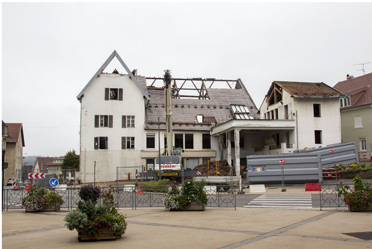
Démontage des toitures, 30 août 2012 : vue d'ensemble depuis le nord. 25, Charquemont place de l' Hôtel de Ville
