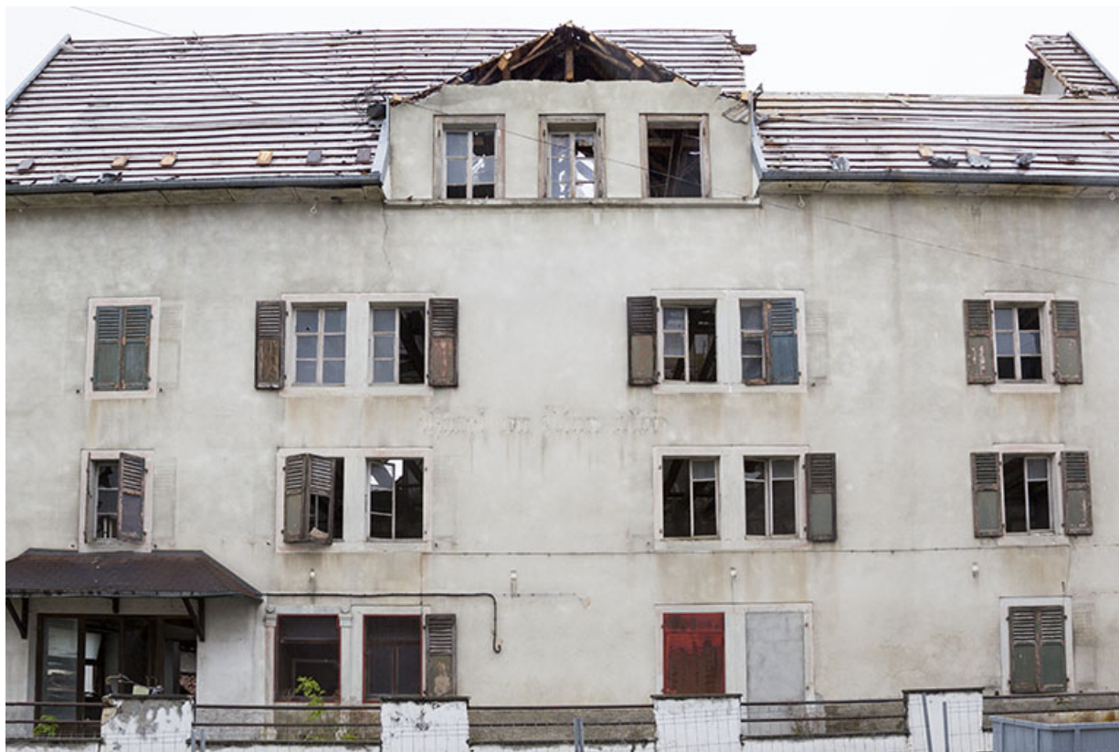
Destruction des bâtiments, 30 août 2012 : baies sur la façade antérieure (est) de l'hôtel. 25, Charquemont place de l' Hôtel de Ville
