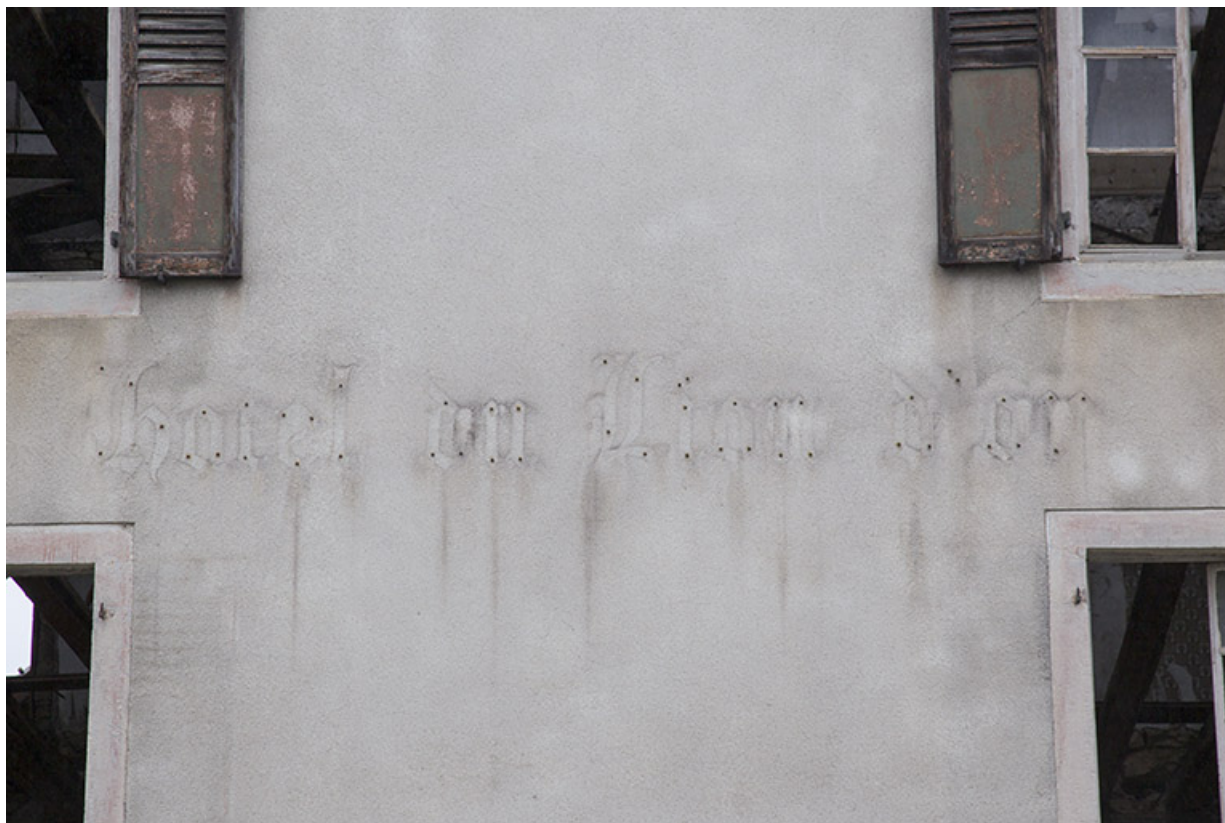
Destruction des bâtiments, 30 août 2012 : traces de l'enseigne sur la façade antérieure de l'hôtel. 25, Charquemont place de l' Hôtel de Ville
