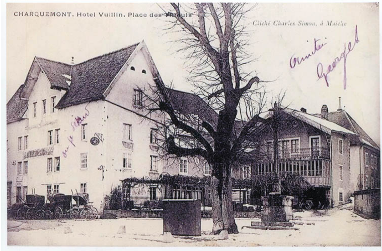
Charquemont. Hôtel Vuillin. Place des Tilleuls, limite 19e siècle 20e siècle. 25, Charquemont place de l' Hôtel de Ville
