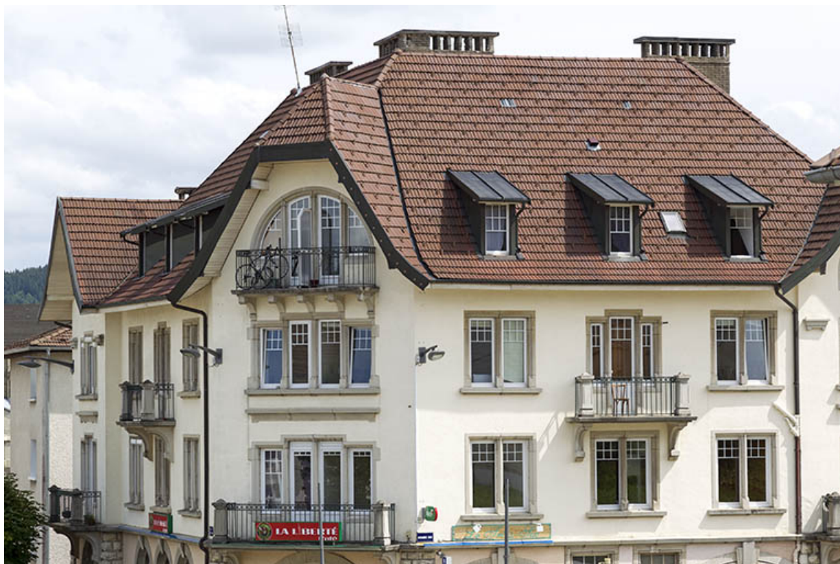
Façade antérieure et pan coupé : niveaux supérieurs.
