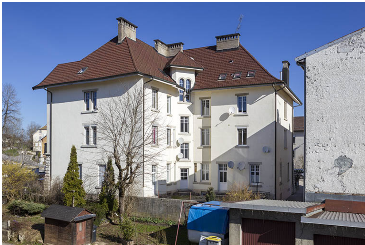
Vue d'ensemble, depuis le sud-est (façades postérieure et latérale droite). 25, Charquemont, 19 Grande Rue
