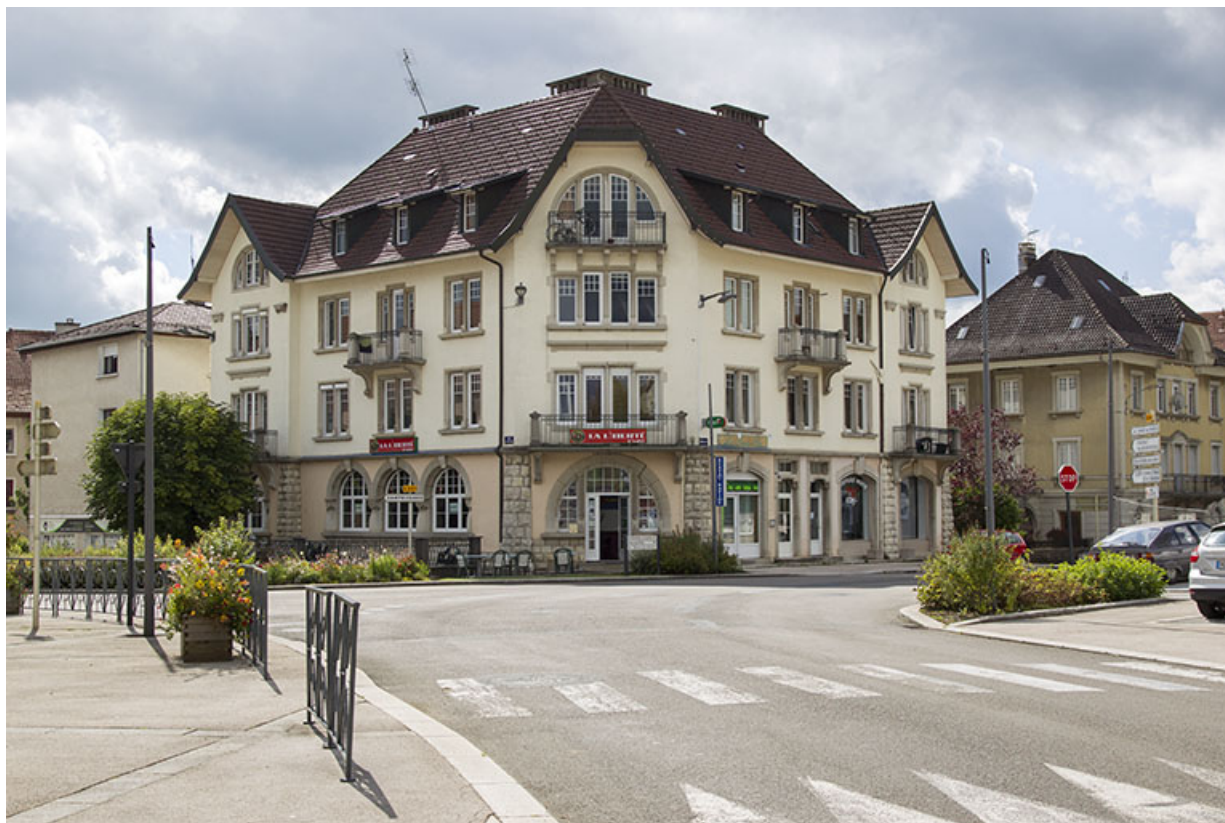
Vue d'ensemble rapprochée, depuis le nord-ouest (façades antérieure et latérale gauche). 25, Charquemont, 19 Grande Rue
