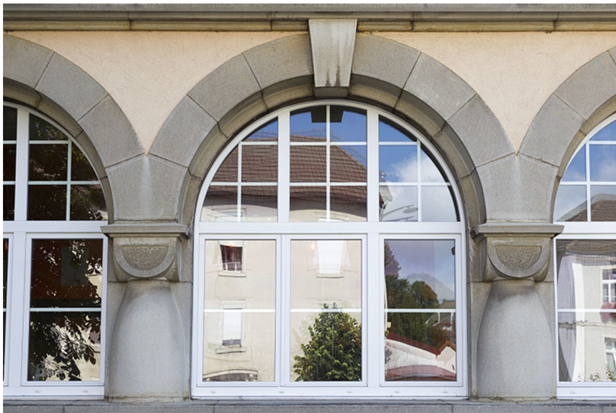
Façade latérale gauche : détail d'une fenêtre en arc plein cintre et ses colonnes.
