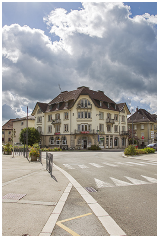
Vue d'ensemble, depuis le nord-ouest (cadrage vertical). 25, Charquemont, 19 Grande Rue
