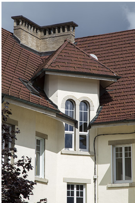
Façade postérieure : niveau supérieur au revers du pan coupé. 25, Charquemont, 19 Grande Rue
