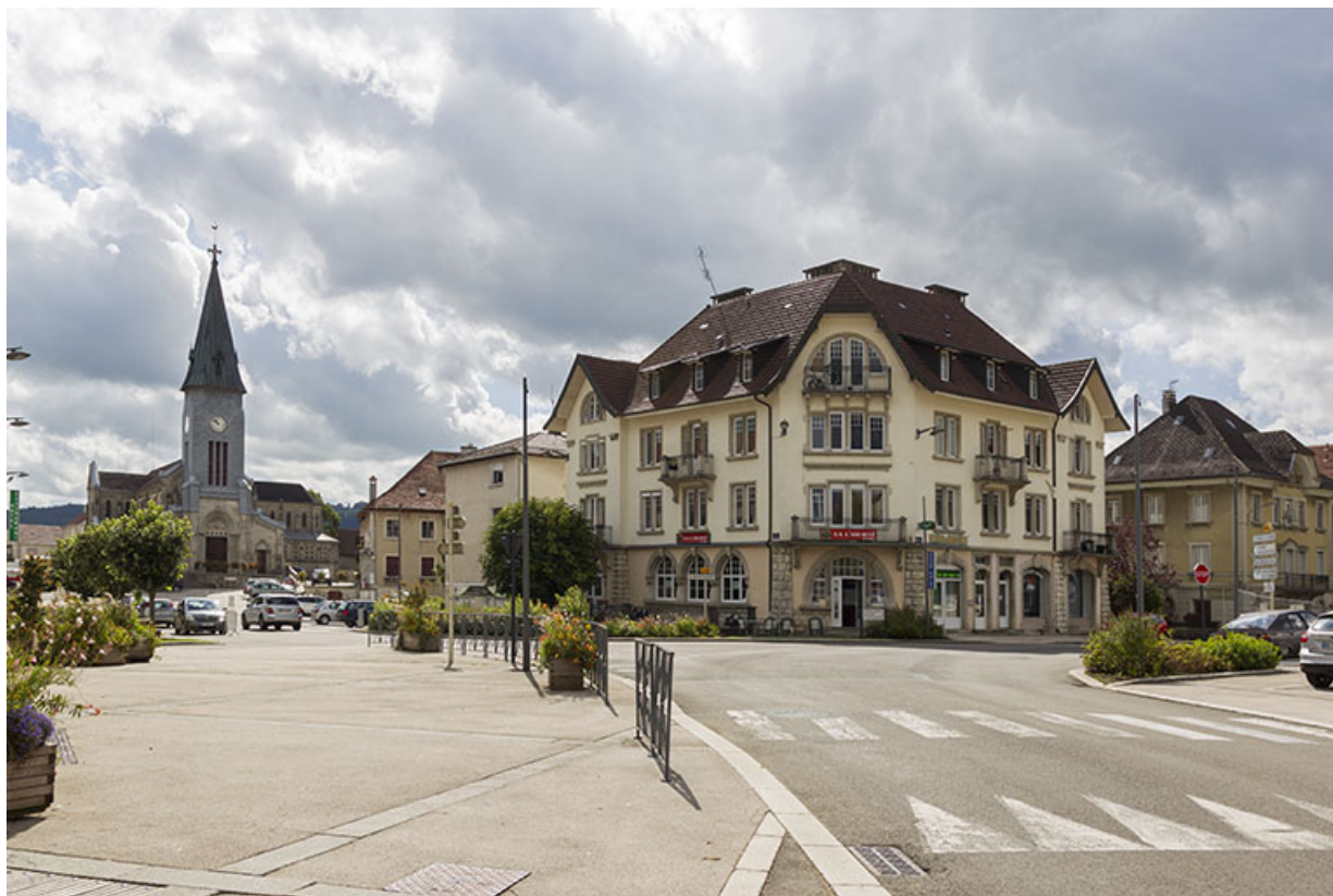
Vue d'ensemble, depuis le nord-ouest (cadrage horizontal). 25, Charquemont
