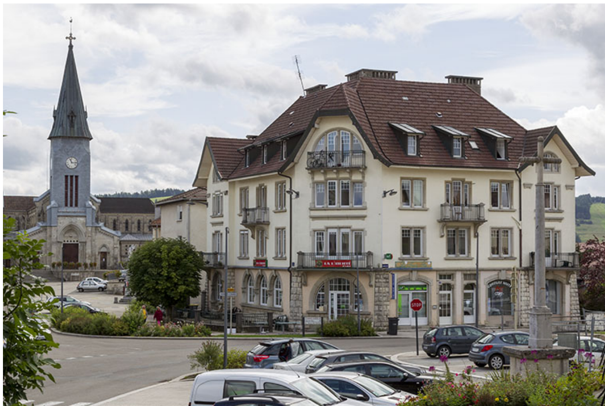
Vue d'ensemble, depuis l'ouest (façades antérieure et latérale gauche). 25, Charquemont, 19 Grande Rue
