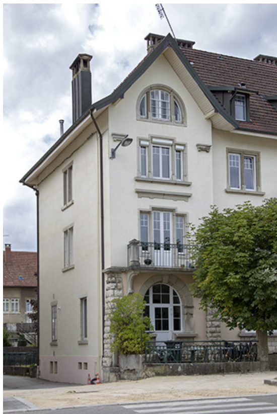
Façade latérale gauche : avant-corps gauche. 25, Charquemont, 19 Grande Rue
