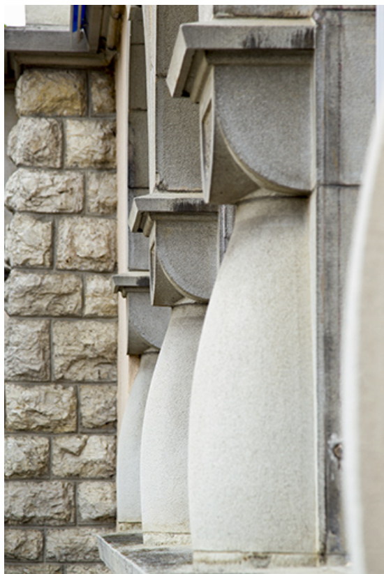
Façade latérale gauche : les colonnes, vues en enfilade.
