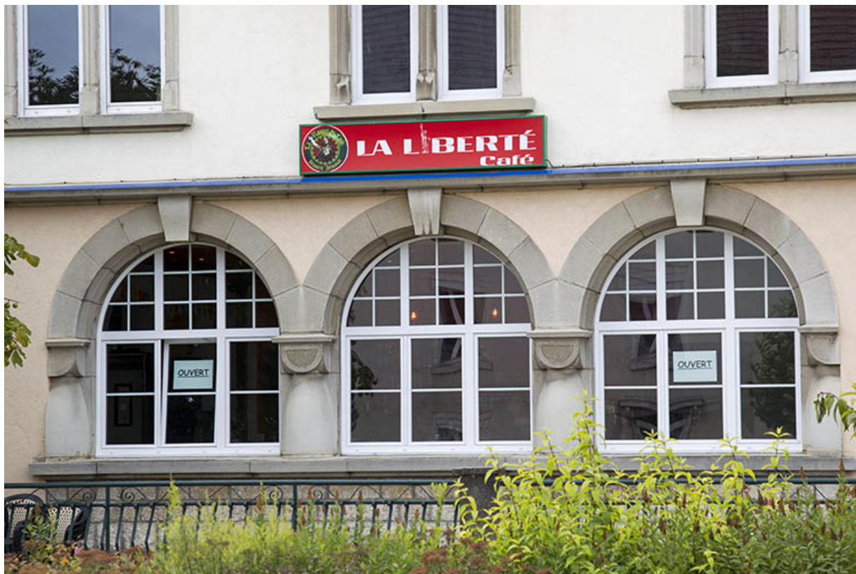
Façade latérale gauche : fenêtres en arc plein cintre et colonnes.
