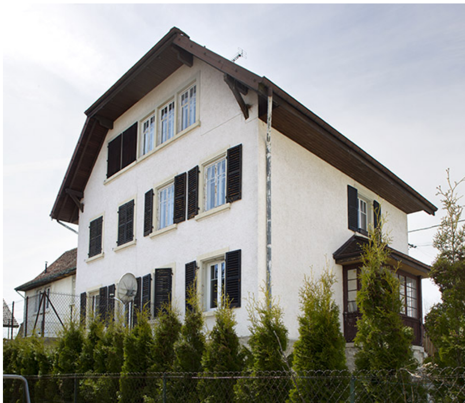
Vue d'ensemble, depuis l'est (façades postérieure et latérale gauche).
