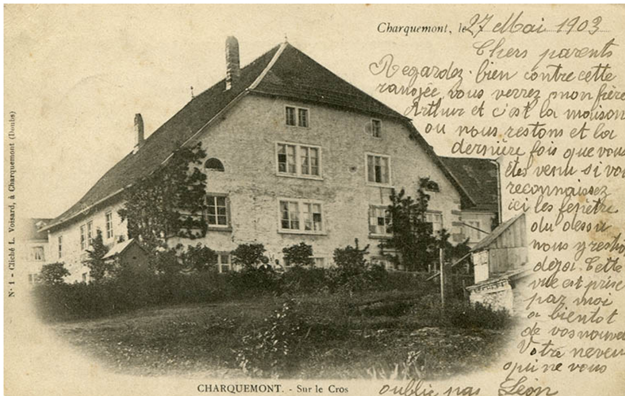
Charquemont. - Sur le Cros [façade postérieure de la maison], 4e quart 19e siècle (avant 1903). 25, Charquemont, 5 rue du Château
