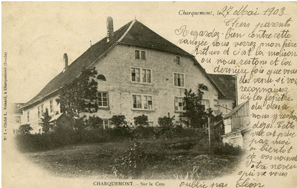
Charquemont. - Sur le Cros [façade postérieure de la maison], 4e quart 19e siècle (avant 1903). 25, Charquemont, 5 rue du Château
