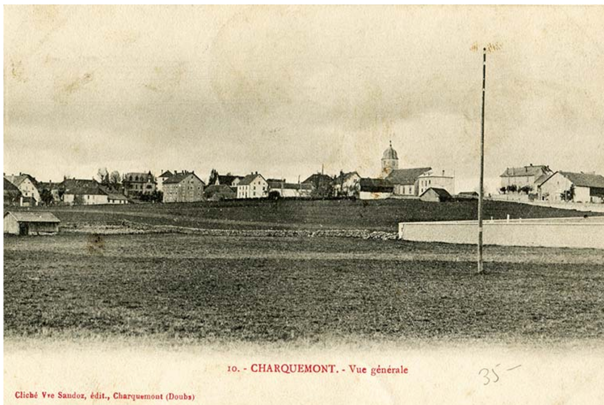
10. - Charquemont. - Vue générale [le village vu du cimetière, au sud-est], 1er quart 20e siècle, entre 1904 et 1908. La ferme est visible tout à droite.
