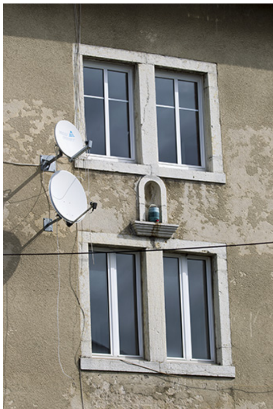
Fenêtres et niche sur la façade latérale droite.
